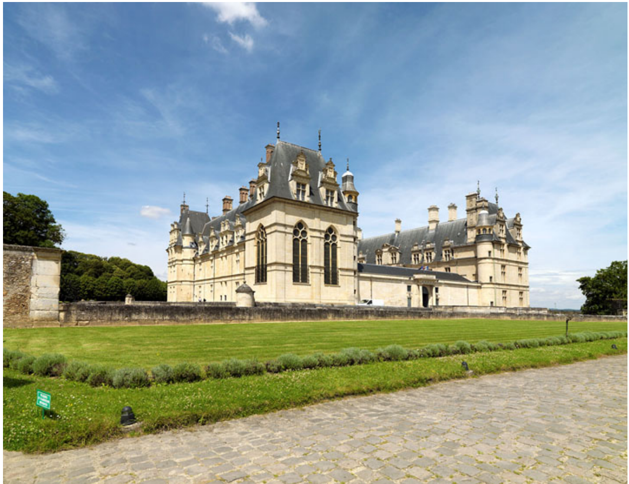
Vue extérieure d'ensemble, depuis le sud-est : l'aile d'entrée, la chapelle, l'aile sud (abritant les appartements du connétable).
