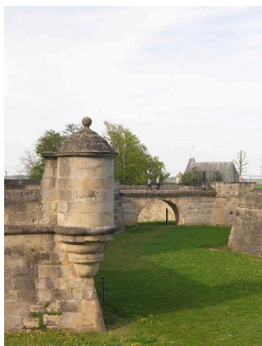
Les douves sèches avec l'échauguette sud-est et le pont dormant donnant accès à l'entrée du château. Dans le fond se profile le toit de l'église Saint-Acceul. Phot. Philippe Ayrault IVR11_20189500052NUC4A
