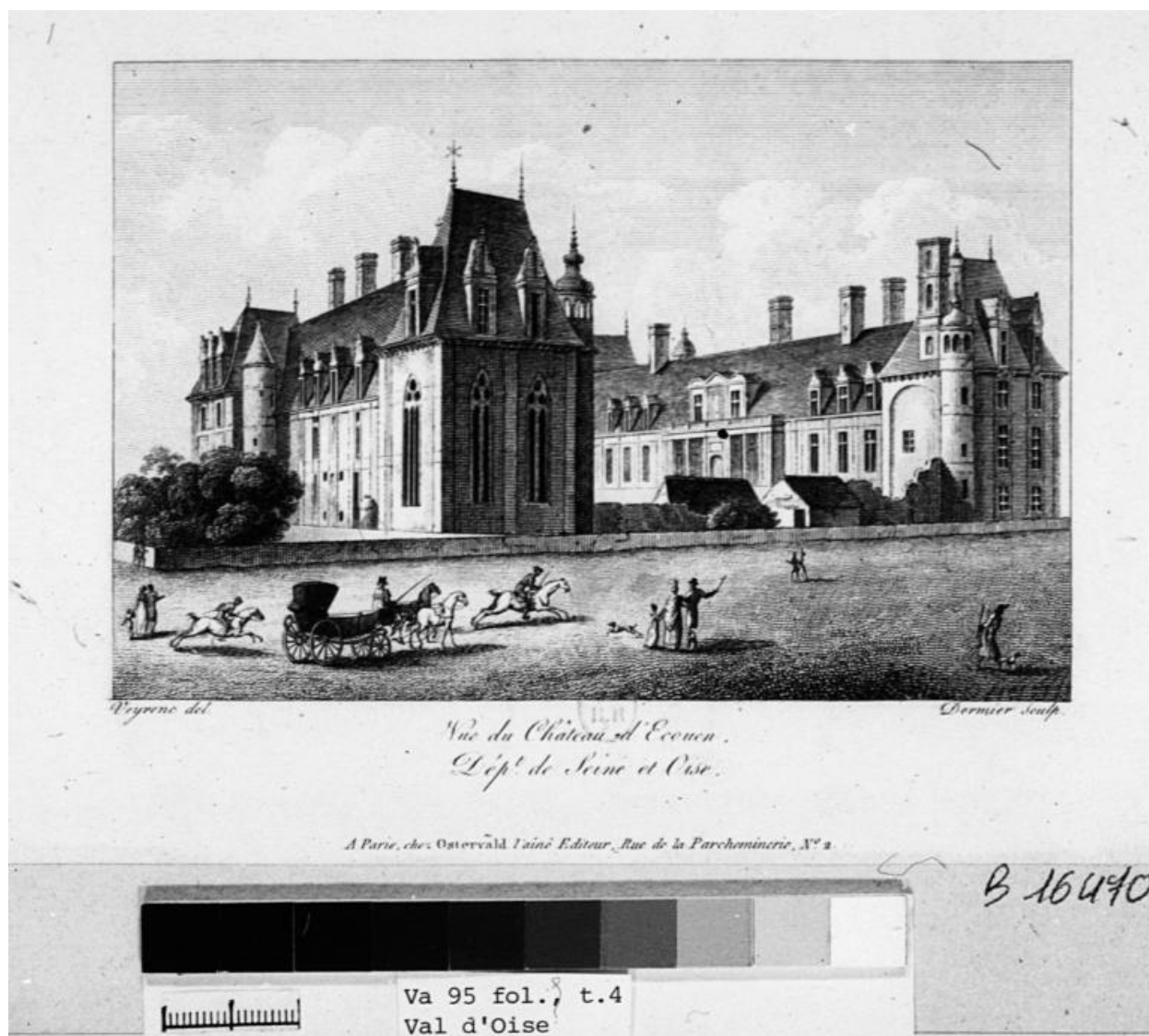
"Vue du château d'Ecouen. Département de Seine-et-Oise". Gravure de Dormier sur un dessin de Veyrenc, éditée par Ostervald à Paris. Le château est vu depuis l'est, vers 1800 (l'aile d'entrée de Peyre n'est pas encore construite). BnF, Estampes, Topo Va Val d'Oise, t. 4, B 16470.
