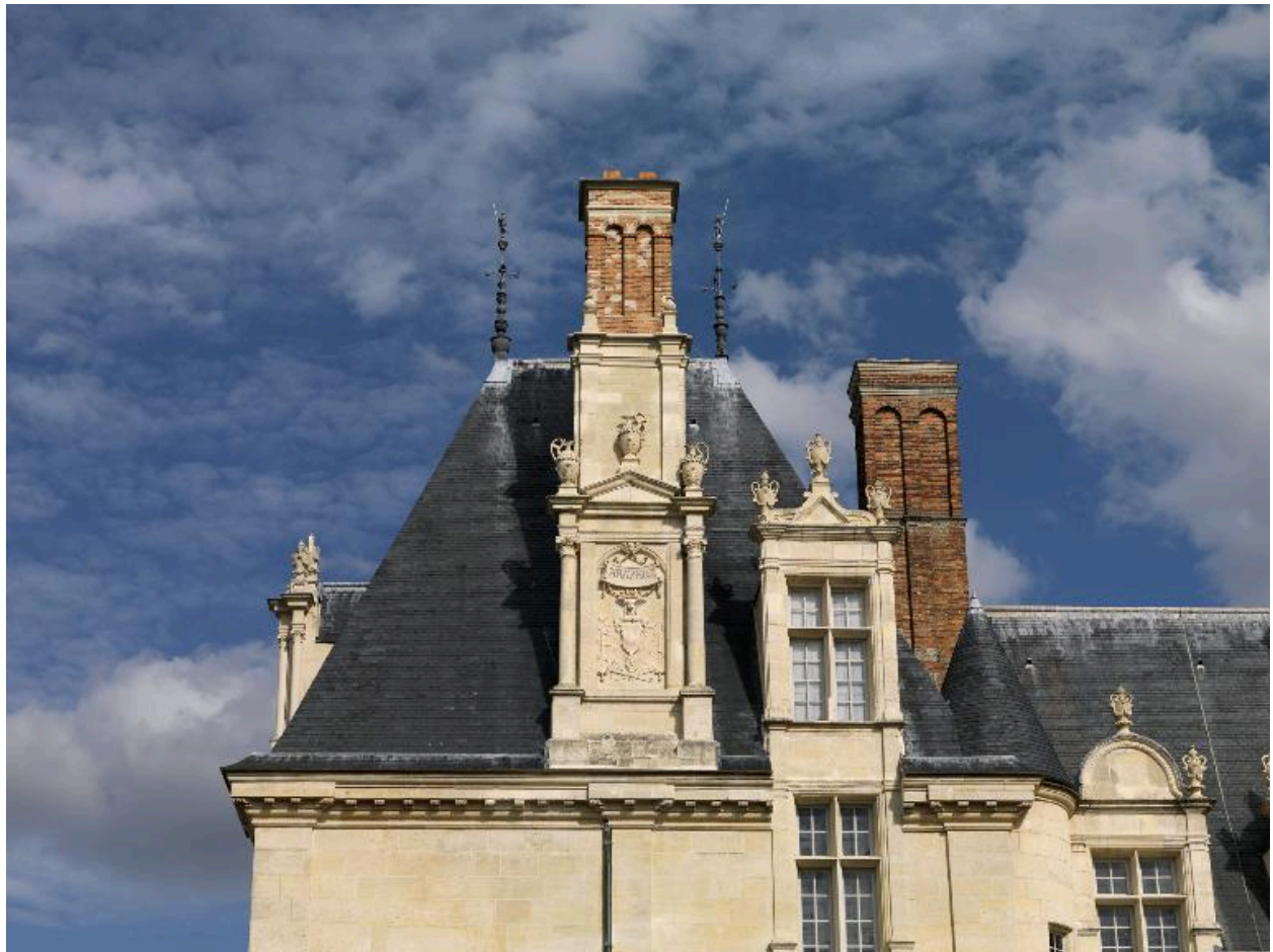
Détail du traitement des parties hautes, sur l'élévation ouest du pavillon d'angle nord-ouest : lucarnes et souche de cheminée.
