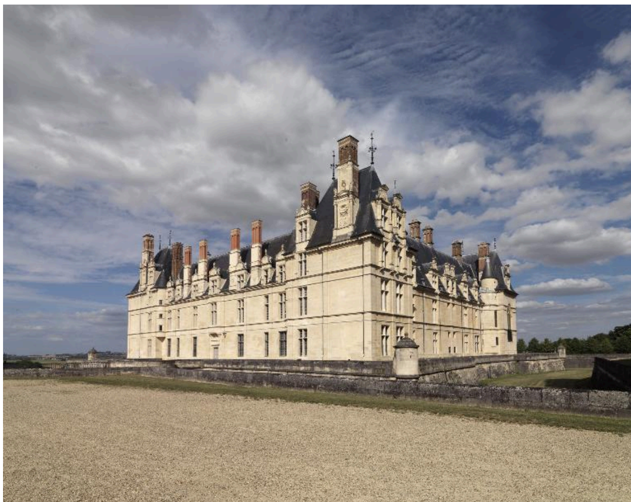
Vue d'ensemble du château, depuis le sud-ouest.
