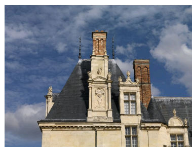
Détail du traitement des parties hautes, sur l'élévation ouest du pavillon d'angle nord-ouest : lucarnes et souche de cheminée.
