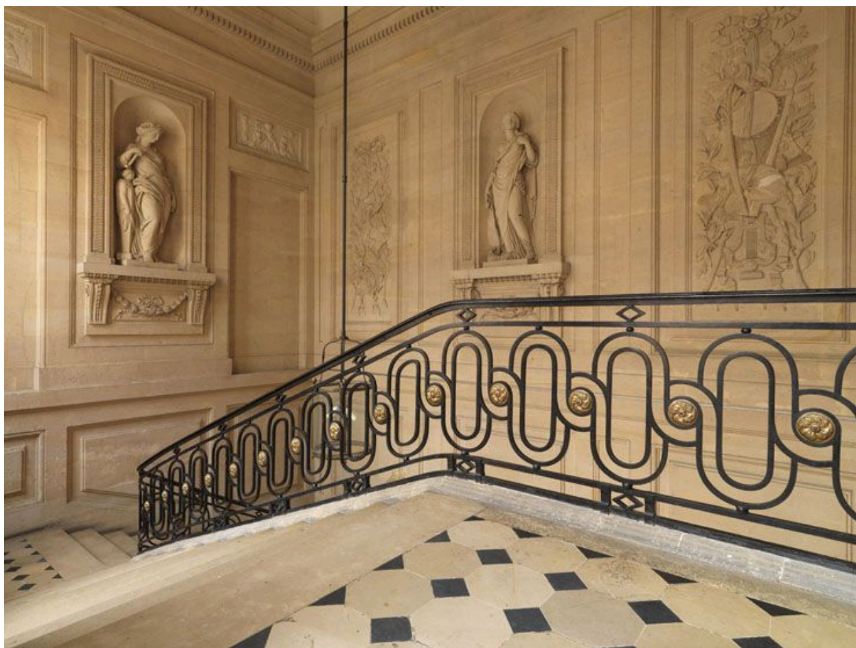
Vue de la rampe à partir du palier.
