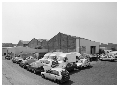
Façade arrière des bâtiments. Phot. Philippe Ayrault IVR11_20039100957X
