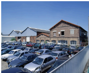
Vue d'ensemble du côté du quai de l'Industrie. Phot. Philippe Ayrault IVR11_20039100954XA
