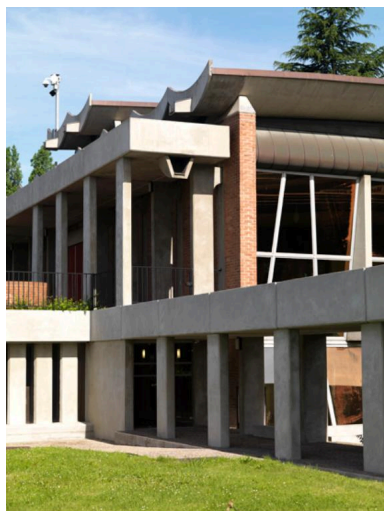
Vue rapprochée sur les longues galeries, les cheneaux et les gouttières monumentales qui « relient » les différents bâtiments entre eux. Le bardage de cuivre a été remplacé par une tôle peinte.
