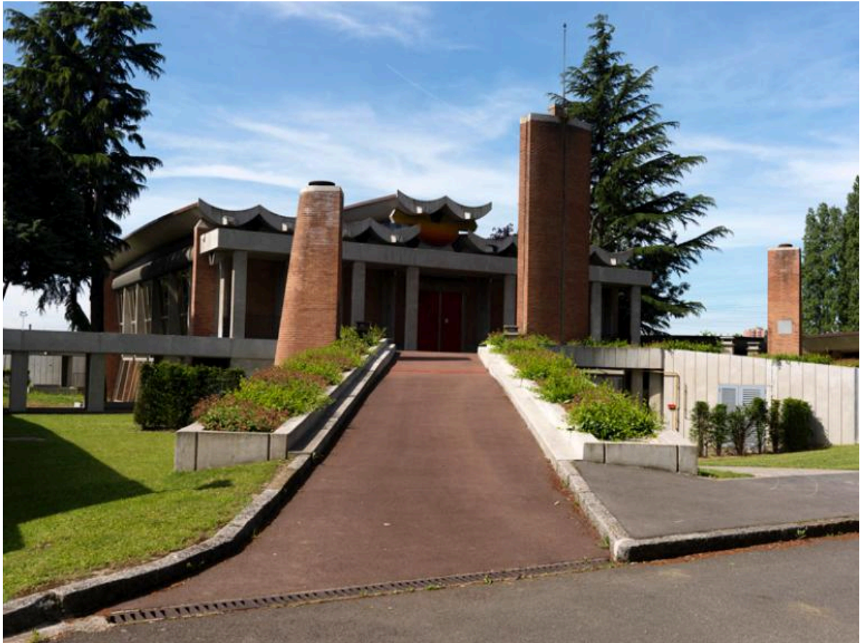
Vue du bâtiment principal côté cimetière. Au premier plan les trois cheminées des fours crématoires. Le second panneau de céramique d'Atila Biro est visible.
