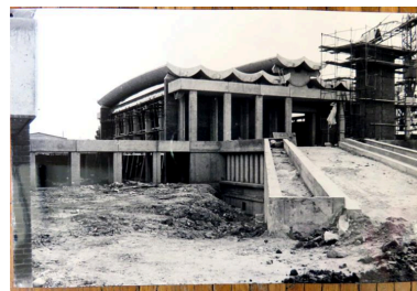
Vue durant le chantier de la salle omniculture côté cimetière. La cheminée du crématorium n'est pas terminée. Circa 1974. SIAF/CAPA. Fonds Robert Auzelle 242 IFA, boîte 53, affaire RA 17. Phot. Isabelle Duhau IVR11_20179300254NUCA
