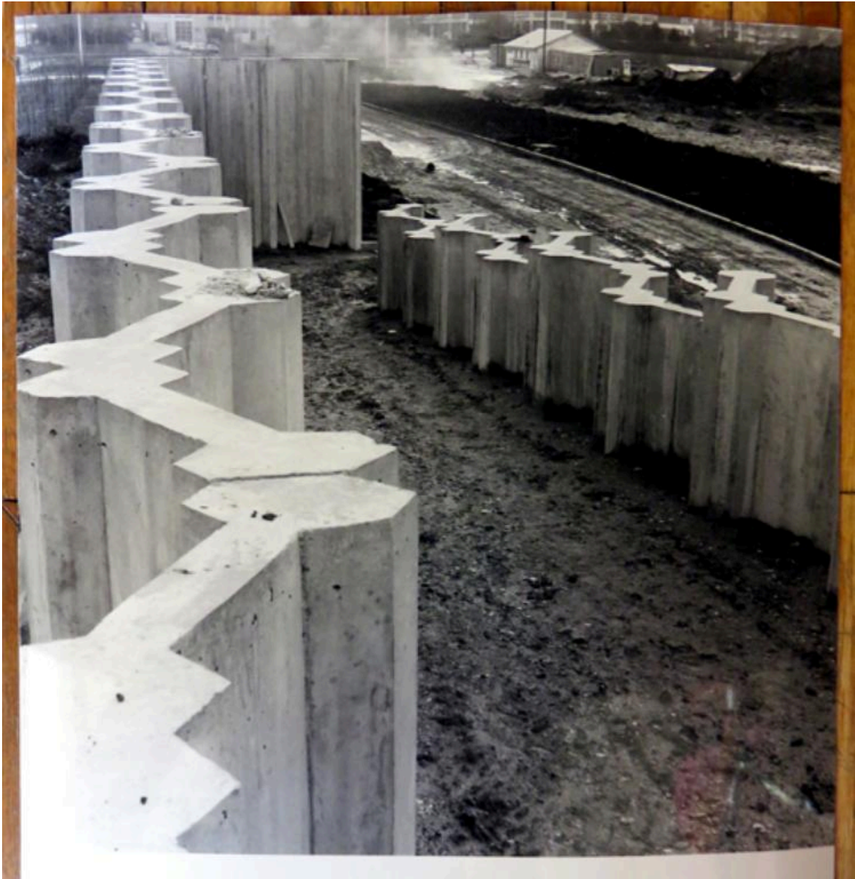
Vue durant le chantier des modules en béton assemblés délimitant les aires d'inhumation et leurs rampes d'accès. Circa 1974. SIAF/CAPA. Fonds Robert Auzelle 242 IFA, boîte 53, affaire RA 17.
