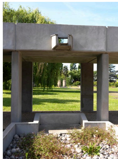
Détail d'une gargouille et d'un bassin recueillant les eaux de pluie au milieu d'une galerie ouverte. Dans le lointain, le groupe sculpté de Calka. Phot. Stéphane Asseline IVR11_20179300274NUCA
