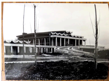
Vue durant le chantier de la salle omniculture côté entrée du cimetière. A gauche, le funérarium. Circa 1975. SIAF/CAPA. Fonds Robert Auzelle 242 IFA, boîte 53, affaire RA 17. Phot. Isabelle Duhau IVR11_20179300253NUCA
