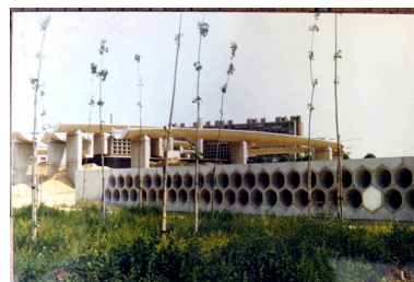
Vue durant le chantier de la zone de l'ossuaire et des enfeus. Circa 1974. SIAF/CAPA. Fonds Robert Auzelle 242 IFA, boîte 53, affaire RA 17. Phot. Isabelle Duhau IVR11_20179300257NUCA
