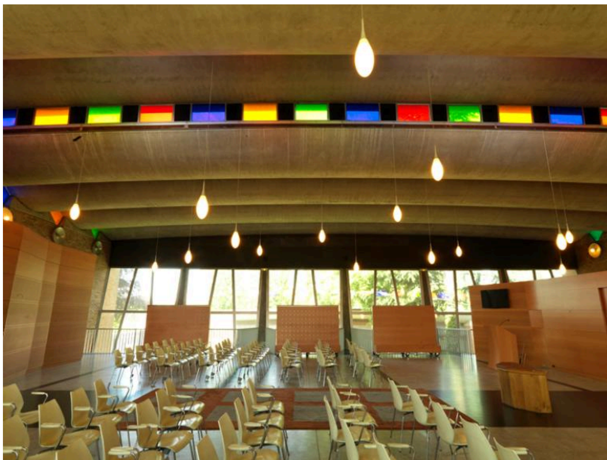
Vue intérieure latérale de la salle omniculture. L'éclairage zénithal en verres colorés, le long d'une des coques en béton de la couverture est bien visible.
