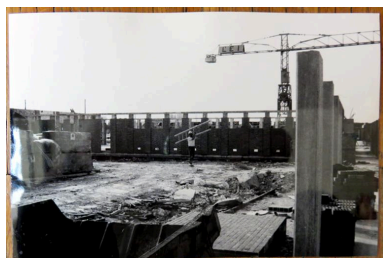
Vue durant le chantier des bâtiments annexes, construits avec une structure béton et un habillage des parements en brique. Circa 1974. SIAF/CAPA. Fonds Robert Auzelle 242 IFA, boîte 53, affaire RA 17. Phot. Isabelle Duhau IVR11_20179300255NUCA
