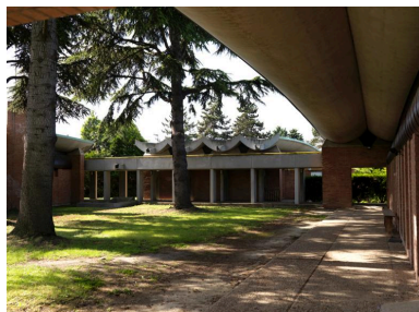
Détail des galeries de circulation extérieures entre bâtiments. Phot. Stéphane Asseline IVR11_20179300272NUCA
