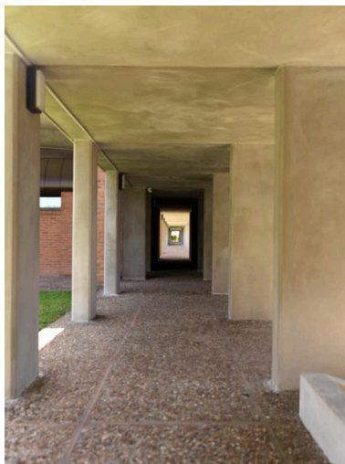
Autre vue d'une galerie extérieure. Phot. Stéphane Asseline IVR11_20179300273NUCA
