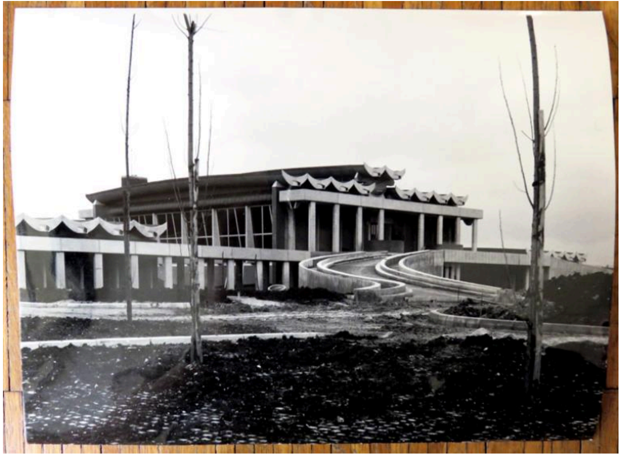
Vue durant le chantier de la salle omniculte côté entrée du cimetière. A gauche, le funérarium. Circa 1975. SIAF/CAPA. Fonds Robert Auzelle 242 IFA, boîte 53, affaire RA 17.
