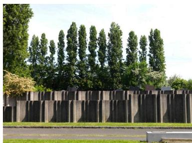
Vue des panneaux en béton moulé qui, assemblés, forment les murs de soutènement et les rampes d'accès aux aires d'inhumation.
