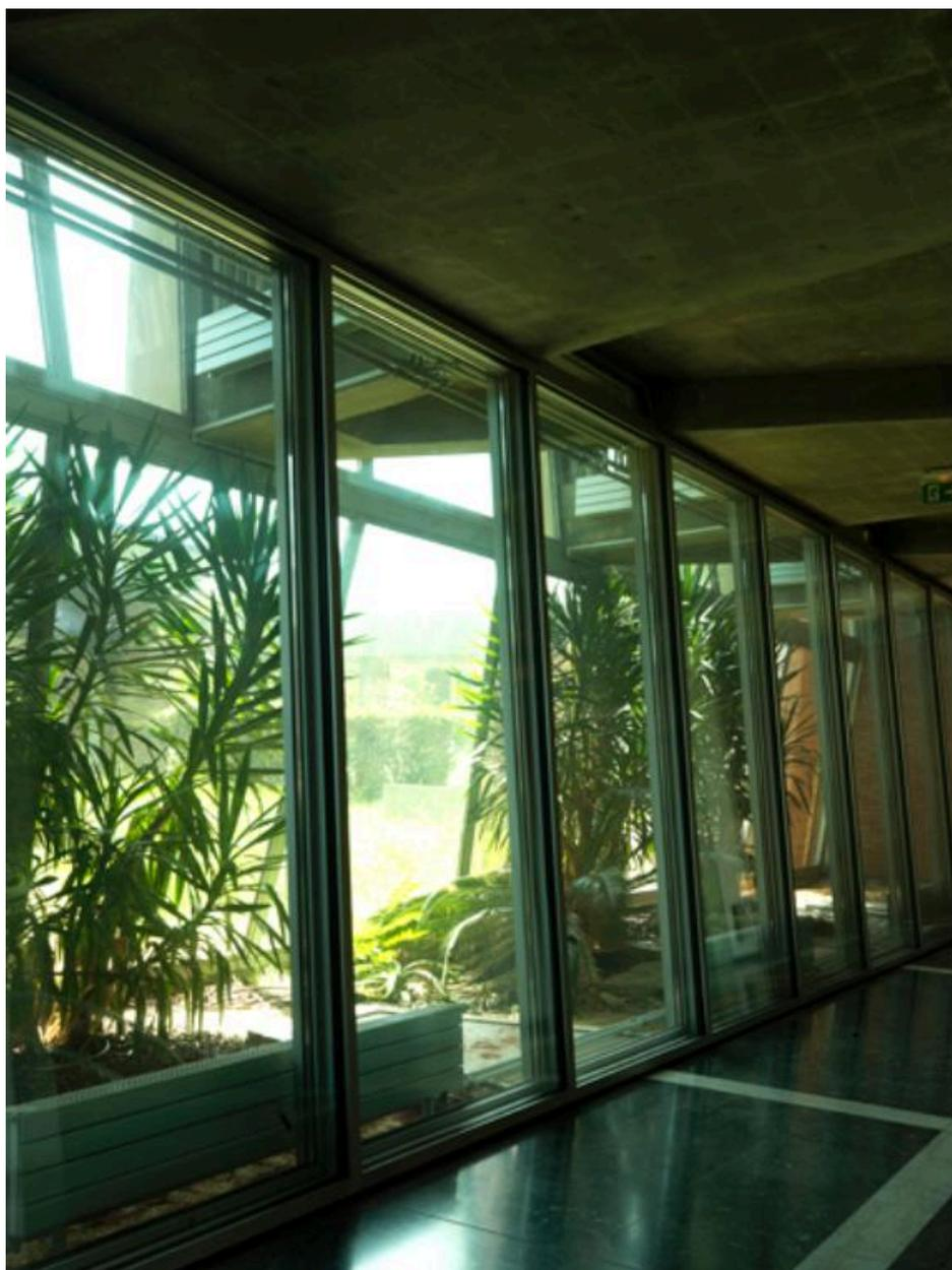
Vue latérale de la salle du crématorium, ouverte sur le jardin d'hiver latéral. La fermeture vitrée a été ajoutée postérieurement à Auzelle, lorsque les deux salles superposées ont dû être utilisées simultanément quand l'activité du crématorium a commencé d'augmenter.
