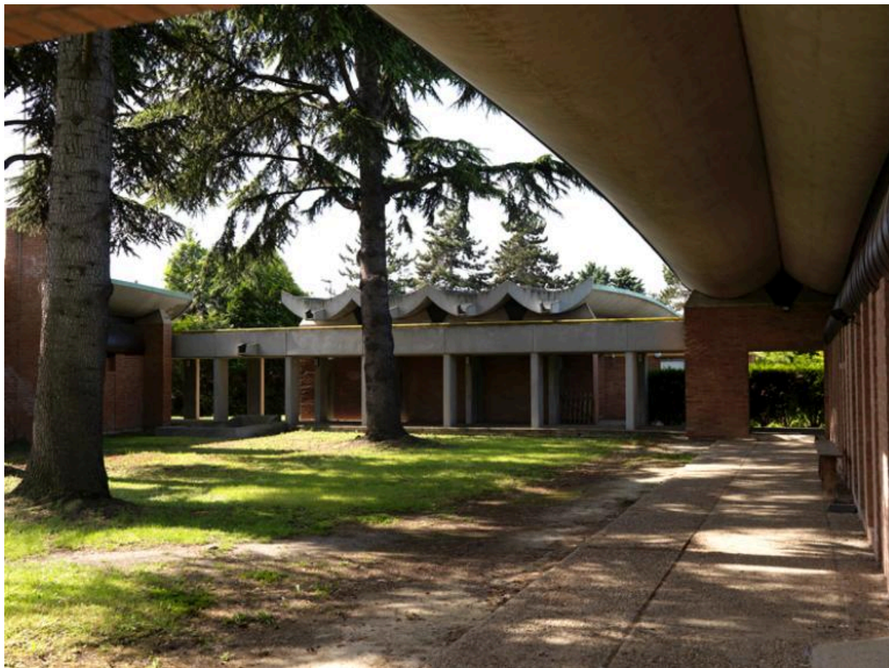
Détail des galeries de circulation extérieures entre bâtiments.
