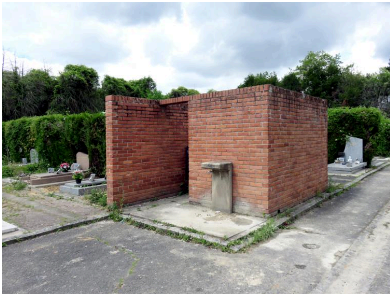
Vue d'un édicule doté d'une fontaine et dissimulant les poubelles.
