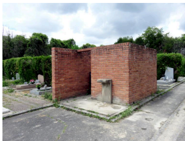
Vue d'un édicule doté d'une fontaine et dissimulant les poubelles. Phot. Stéphane Asseline IVR11_20179300307NUCA
