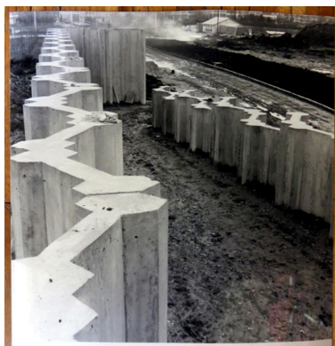
Vue durant le chantier des modules en béton assemblés délimitant les aires d'inhumation et leurs rampes d'accès. Circa 1974. SIAF/CAPA. Fonds Robert Auzelle 242 IFA, boîte 53, affaire RA 17. Phot. Isabelle Duhau IVR11_20179300256NUCA
