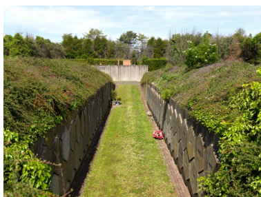
Vue depuis le columbarium, surélevé, sur les alignements d'enfeus qui l'entourent et qui sont recouverts de végétation, dissimulant les cheminées d'aération. Phot. Stéphane Asseline IVR11_20179300292NUCA
