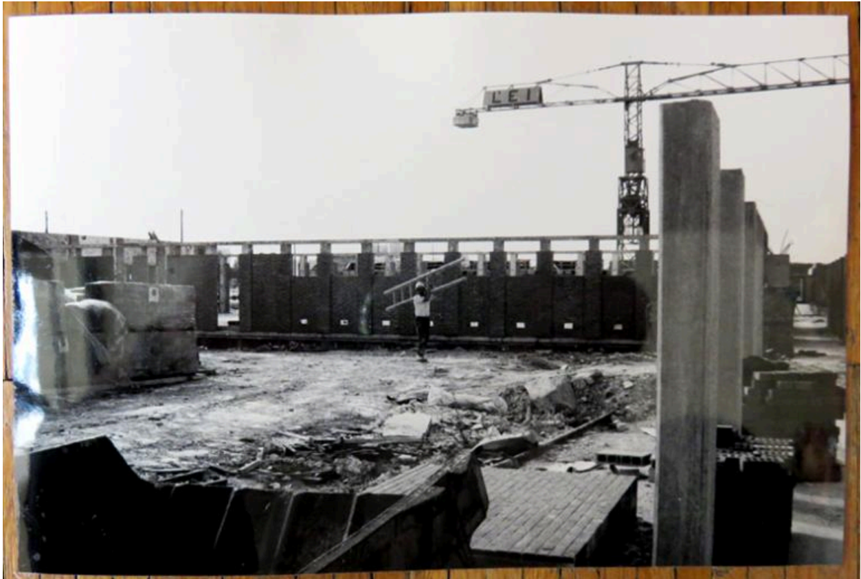
Vue durant le chantier des bâtiments annexes, construits avec une structure béton et un habillage des parements en brique. Circa 1974. SIAF/CAPA. Fonds Robert Auzelle 242 IFA, boîte 53, affaire RA 17.
