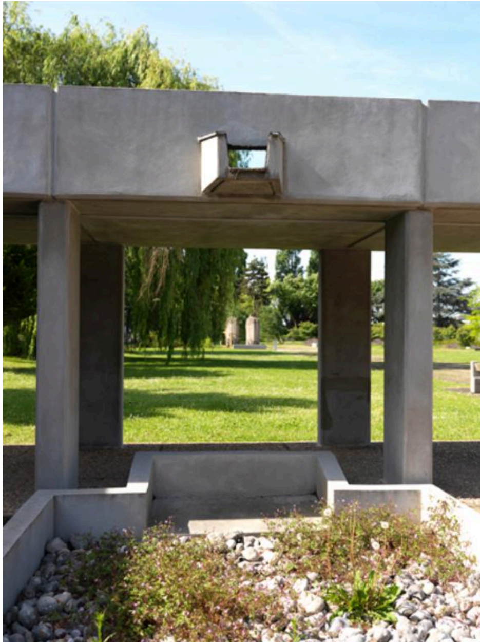
Détail d'une gargouille et d'un bassin recueillant les eaux de pluie au milieu d'une galerie ouverte. Dans le lointain, le groupe sculpté de Calka.
