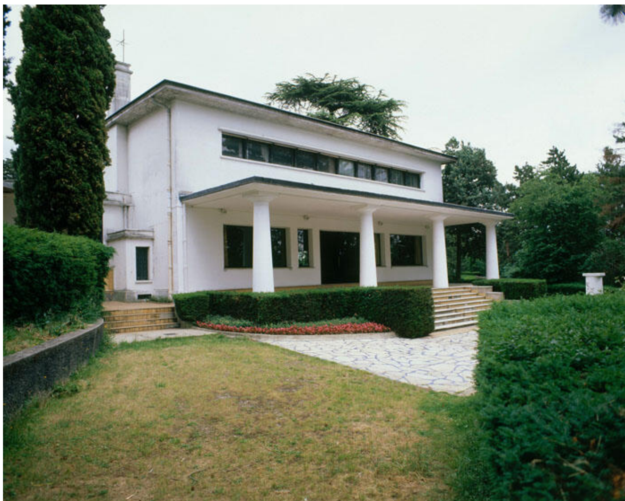
Façade sud à portique
