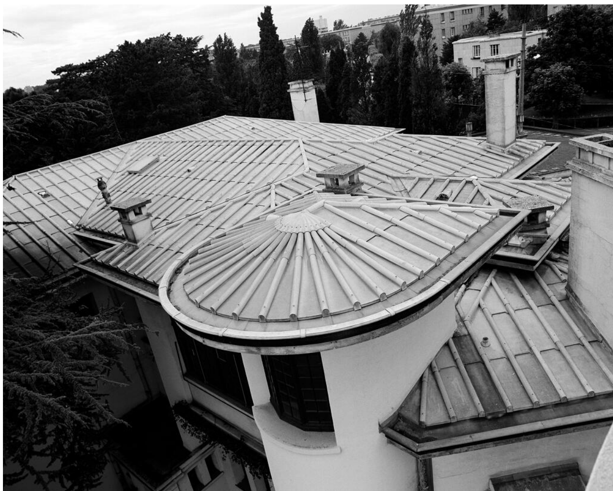
Vue d'ensemble des toits.
