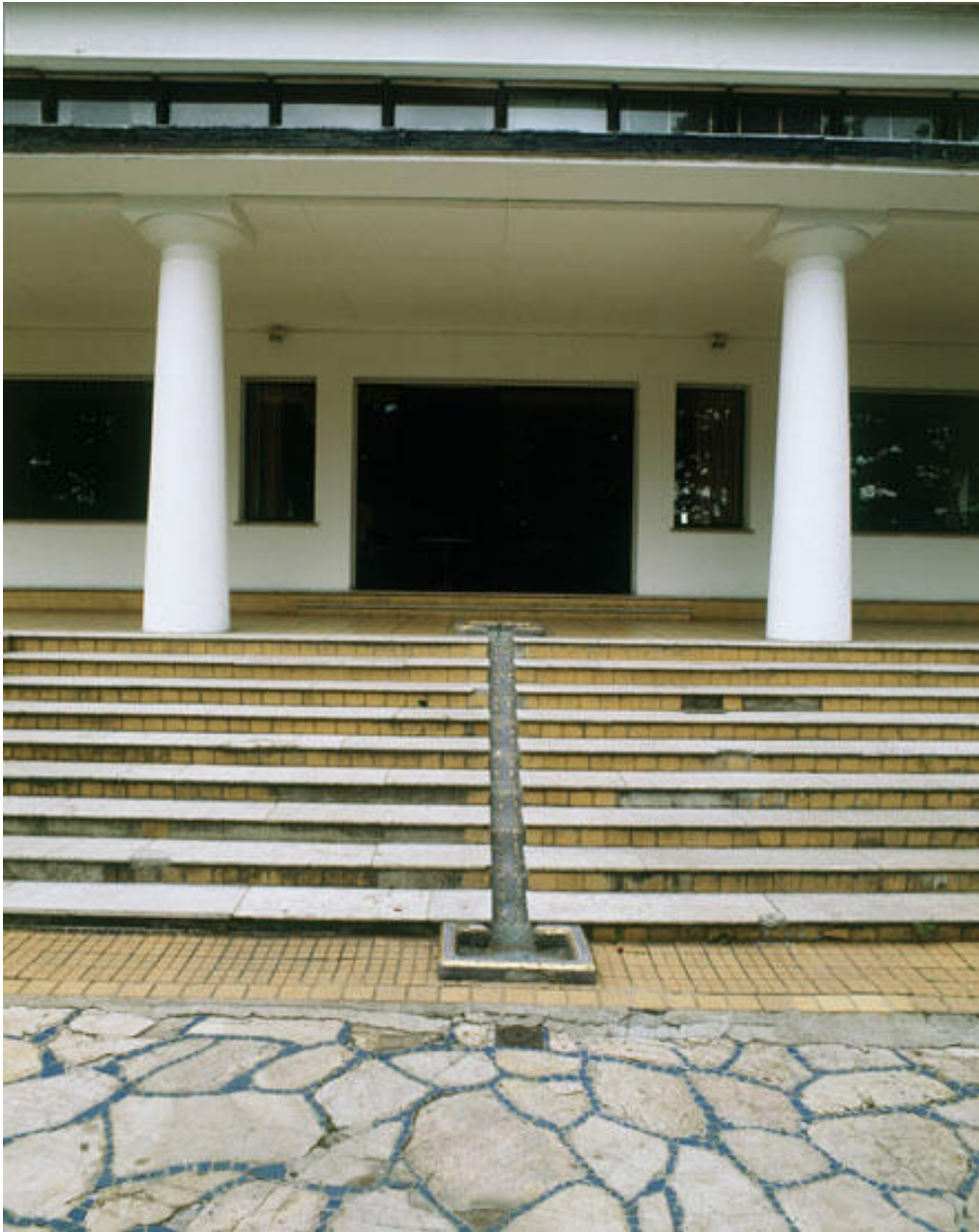
Détail de l'embranchement de la façade sud. Une petite "cascade" recouverte de mosaïque l'agrémente.
