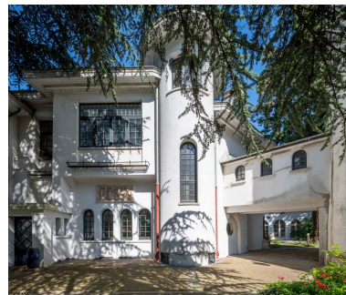
L'entrée se tient discrètement sur la gauche : l'architecte fait fi de la grande monumentalité enseignée aux Beaux-Arts. La façade se présente comme un agrégat de modules de tailles et de formes différentes. Phot. Ayrault Philippe IVR11_20249200096NUC4A
