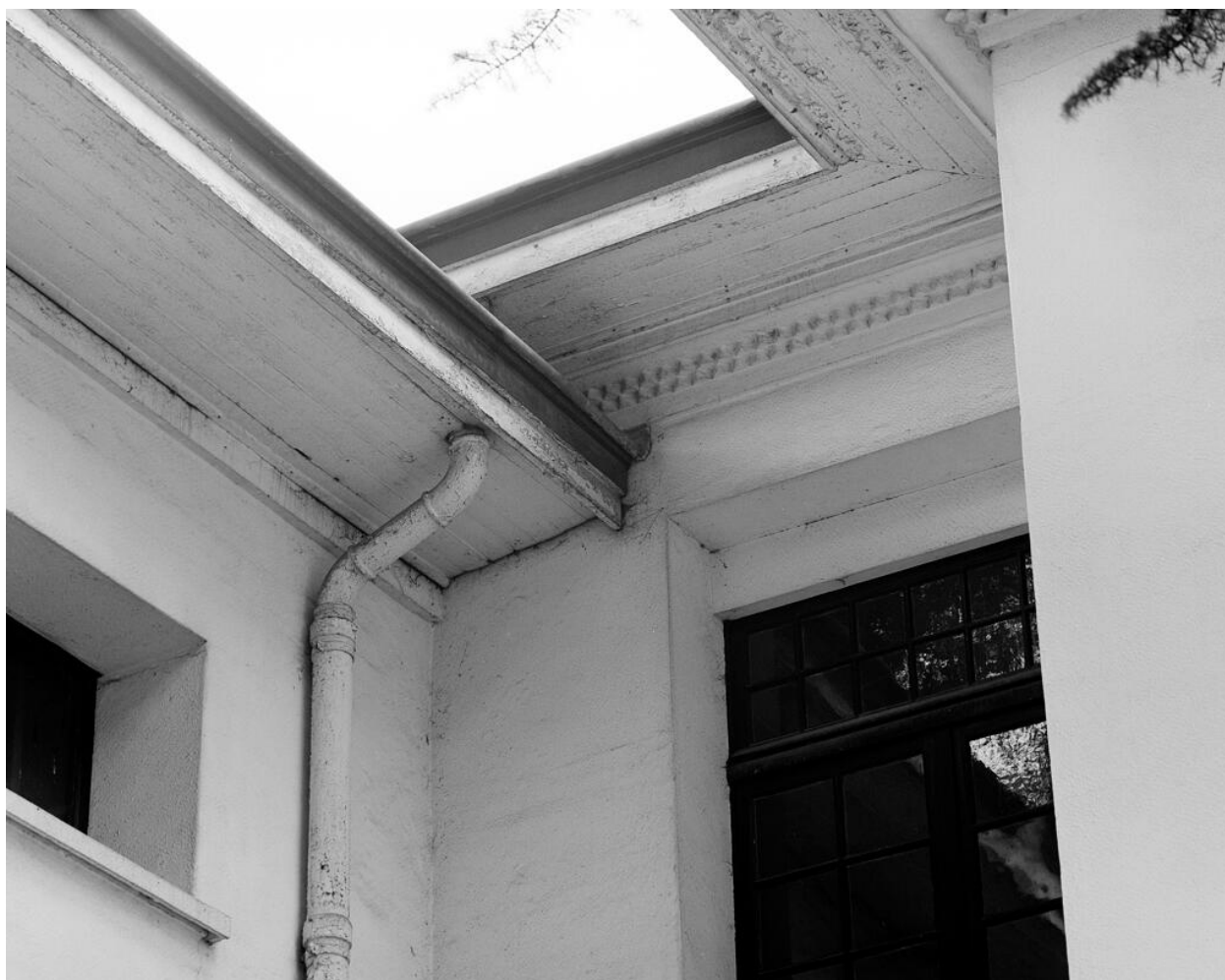
Détail du raccordement des corniches des pavillons Est et Sud. On distingue nettement les deux périodes de construction.
