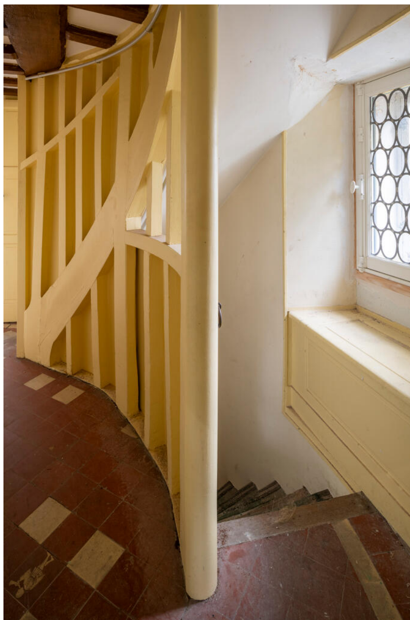
Escalier en charpente de la tour, vu au niveau du palier du 2e étage, qui possède un vitrail à carreaux circulaires en verre blanc.
