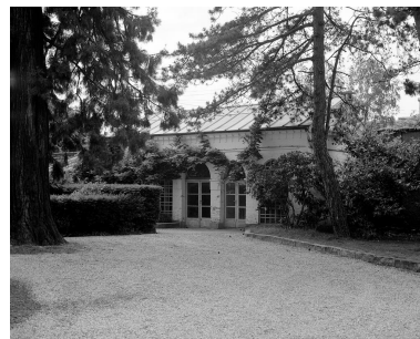
Vue d'ensemble de l'orangerie. Phot. Jean-Bernard Vialles IVR11_19919200801X
