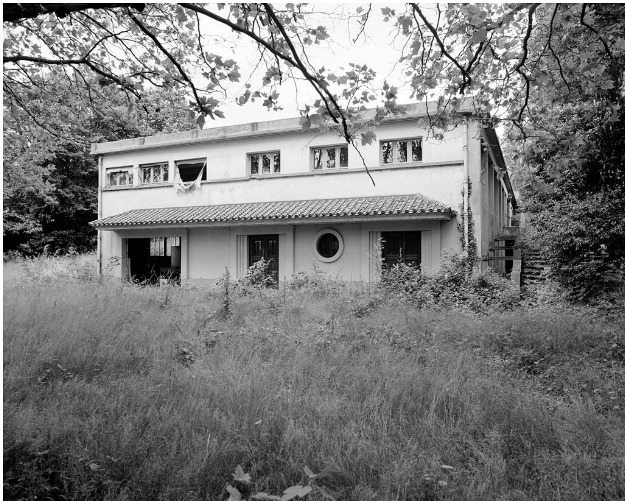
Façade sud du gymnase.
