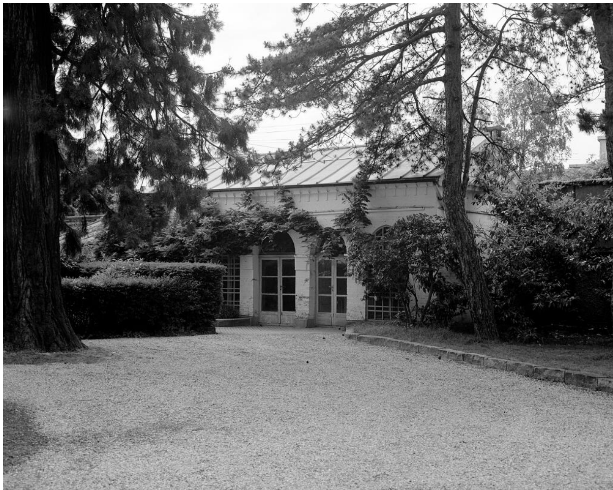
Vue d'ensemble de l'orangerie.
