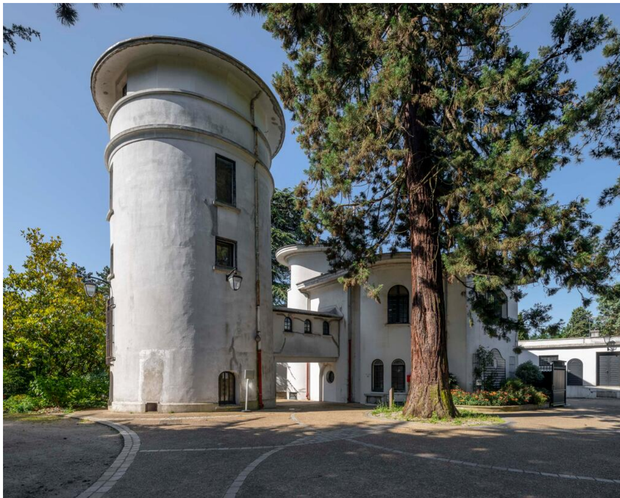
La façade nord.
