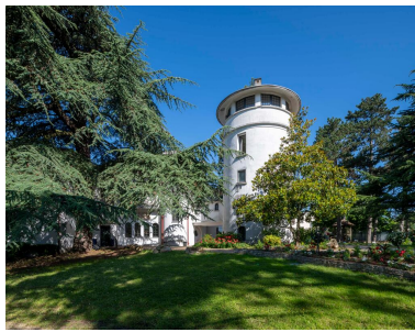
Vue générale de la façade sud dominée par la tour de l'ancien moulin. Phot. Ayrault Philippe IVR11_20249200088NUC4A
