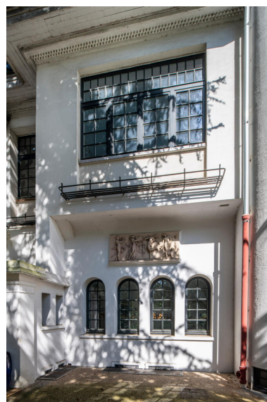
Sur la façade d'entrée l'architecte joue du contraste entre les baies du rez-de-chaussée et la grande baie unique de l'étage. Phot. Ayrault Philippe IVR11_20249200098NUC4A
