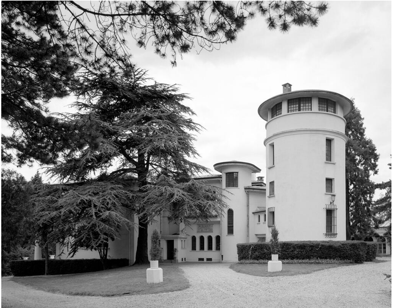
Façade principale (Est)
