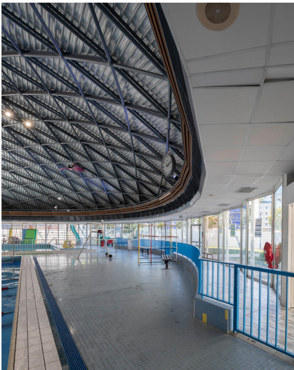
Stade nautique de Drancy. Anneau circulaire soutenant la charpente métallique.
