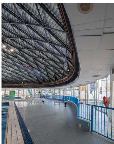
Stade nautique de Drancy. Anneau circulaire soutenant la charpente métallique. Phot. Ayrault Philippe IVR11_20229300864NUC4A
