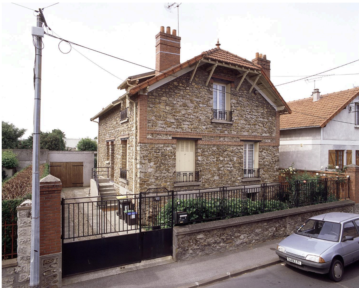
Vue d'ensemble. Les garde-corps sont caractéristiques des années 20.
