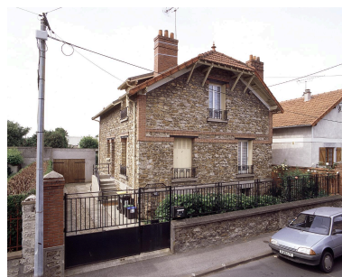
Vue d'ensemble. Les garde-corps sont caractéristiques des années 20. Phot. Philippe Ayrault IVR11_20019100229XA
