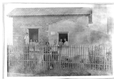
Vue d'ensemble d'un cabanon dans les années 20, situé avenue Condorcet. IVR11_20019100767NUCB
