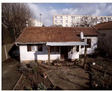
Vue d'ensemble. Phot. Philippe Ayrault IVR11_20059100194XA
