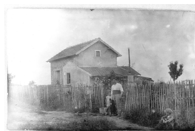
Vue d'ensemble d'un cabanon dans les années 20, situé avenue Condorcet. IVR11_20019100766NUCB
