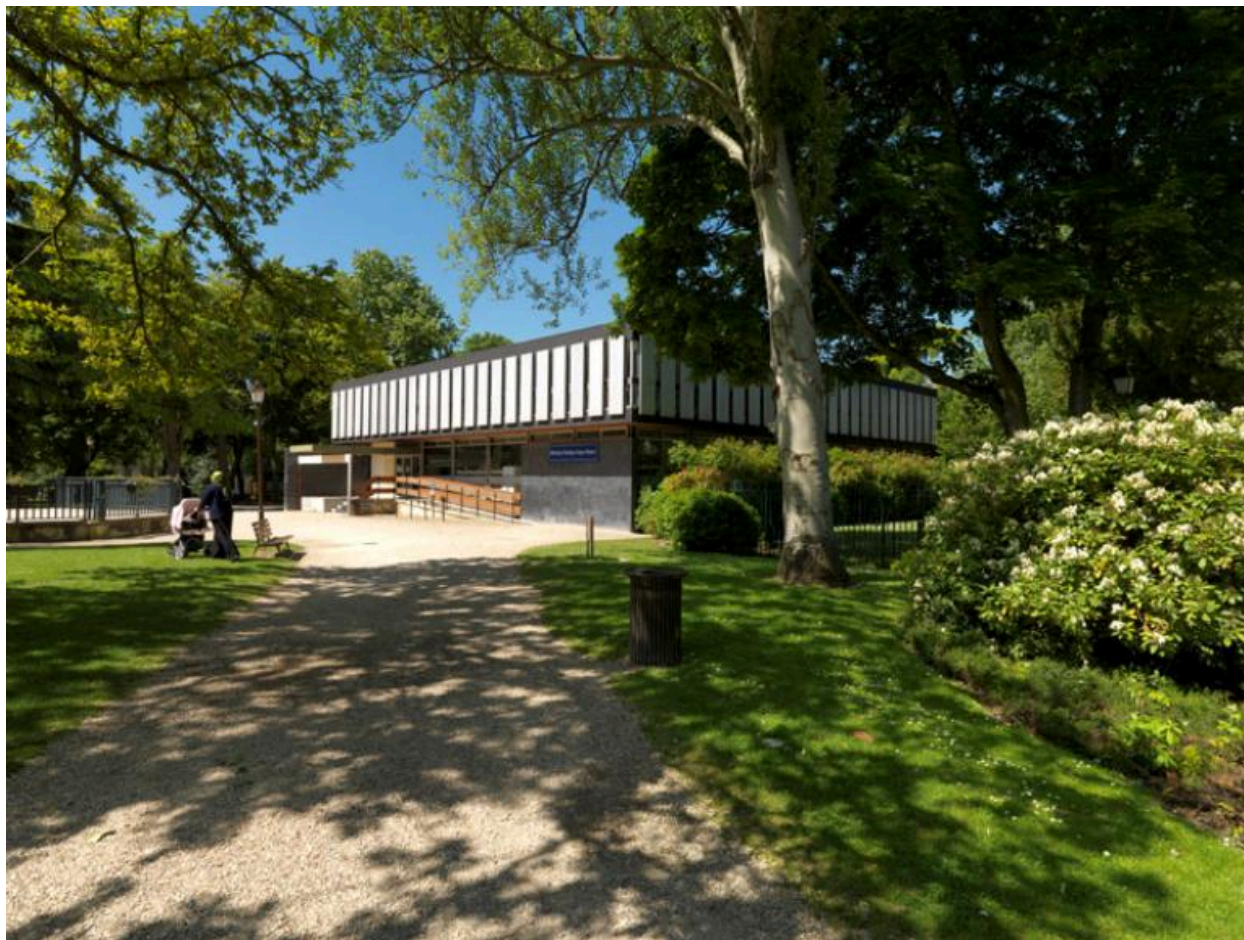
La façade principale de la bibliothèque et le square dans lequel elle se trouve.
