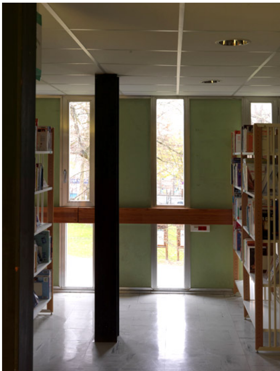
Les ouvertures verticales de la salle du premier étage.
