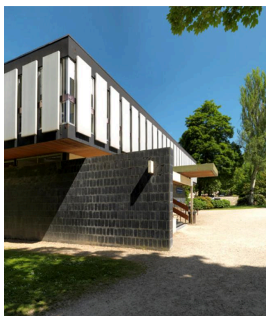
Jeux de formes sur la façade.
