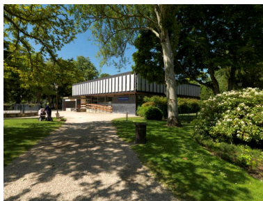
La façade principale de la bibliothèque et le square dans lequel elle se trouve.
