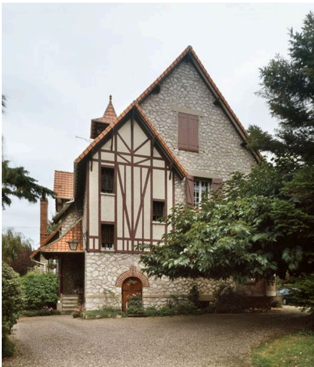
Vue d'ensemble de la façade antérieure.
