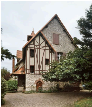
Vue d'ensemble de la façade antérieure. Phot. Laurent Kruszyk IVR11_20067800762VA
