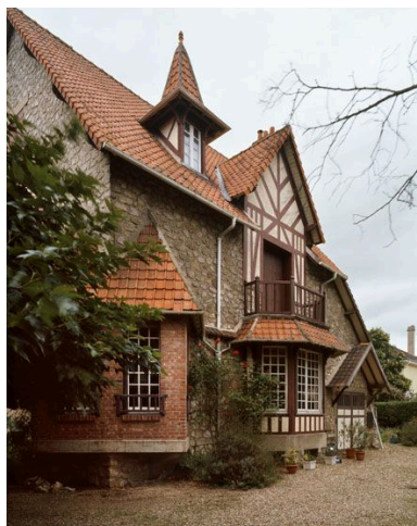
Le bow-window et l'oriel de la façade sur jardin. Phot. Laurent Kruszyk IVR11_20067800766VA
