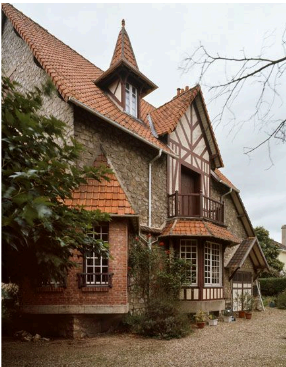
Le bow-window et l'oriel de la façade sur jardin.
