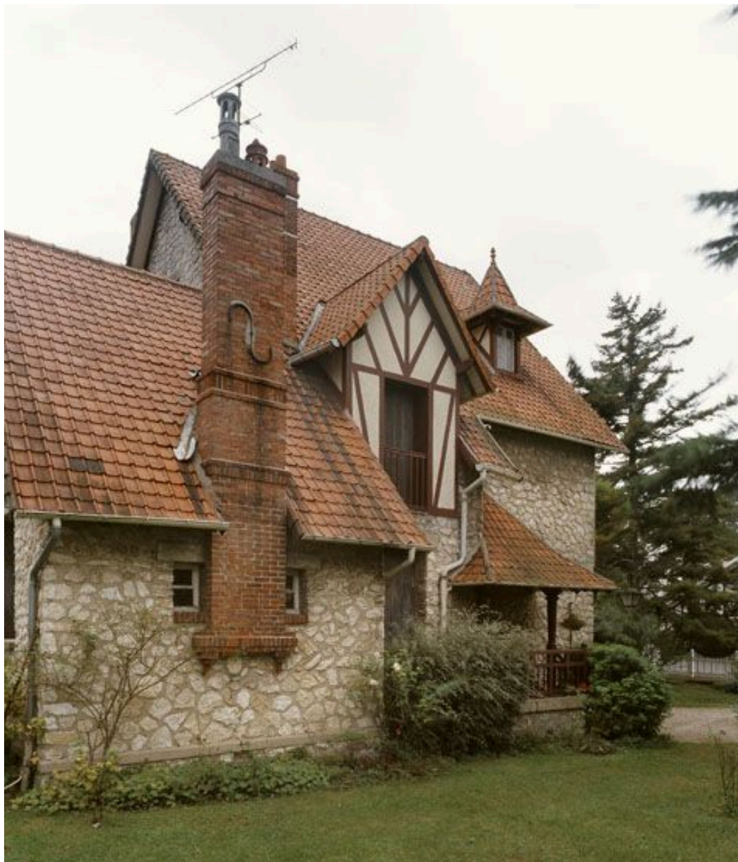
Vue d'ensemble de la façade nord.
