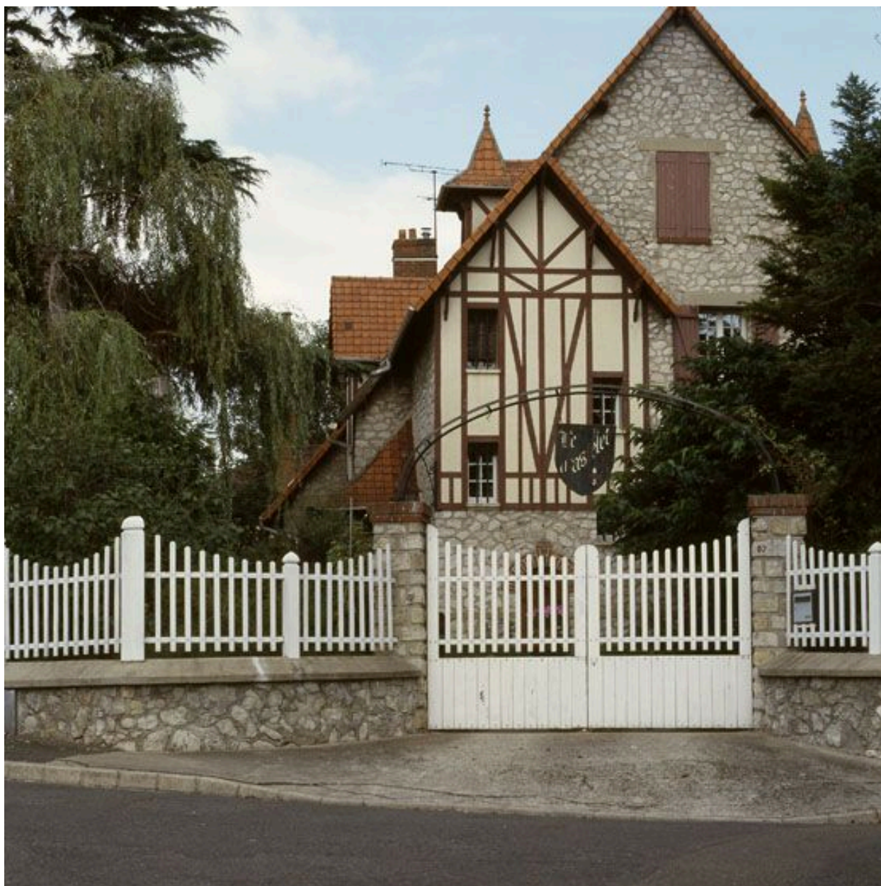
Vue d'ensemble du portail et de la façade d'entrée.
