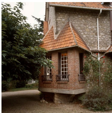
Détail de l'oriel. Phot. Laurent Kruszyk IVR11_20067800768XA
