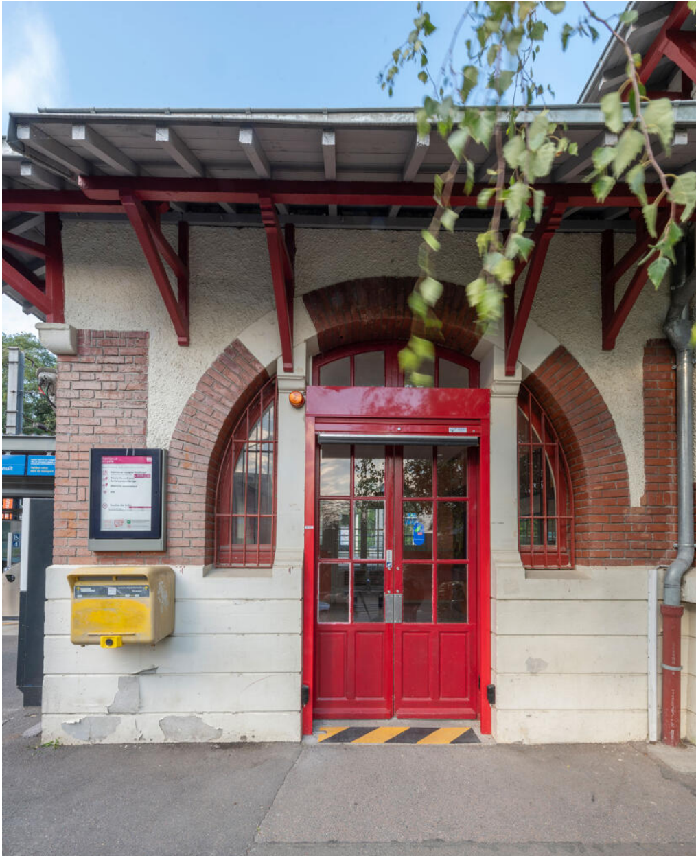
Gare du Val d'Or, façade sud, porte du hall
