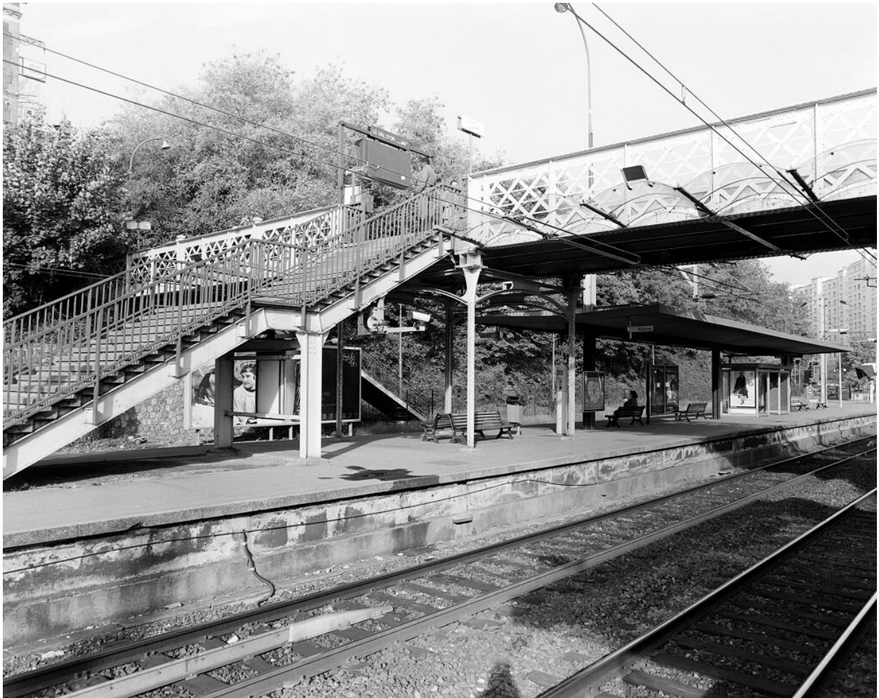
Gare du Val d'Or, passerelle en charpente métallique
