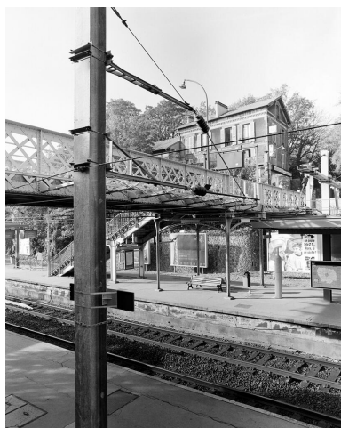
Gare du Val d'Or, passerelle en charpente métallique Phot. Ayrault Philippe IVR11_19969201027X
