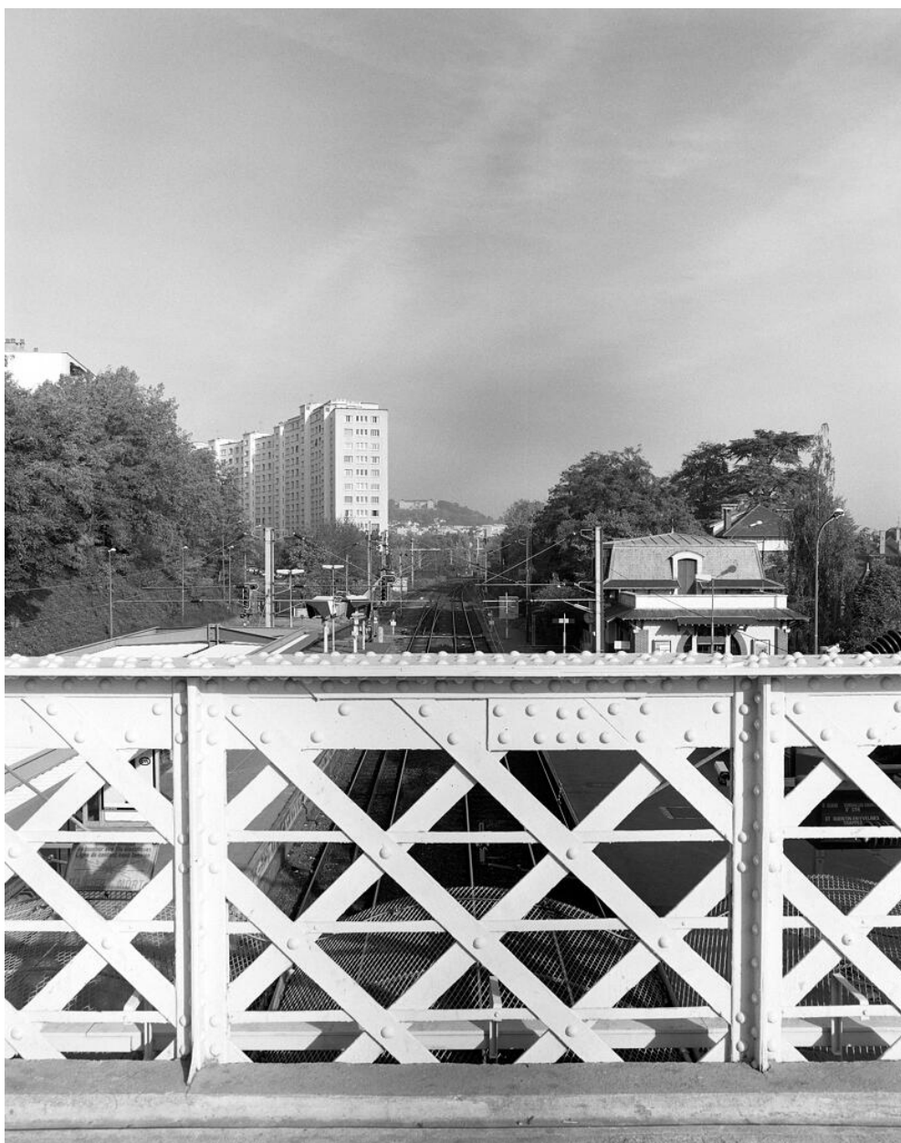
Gare du Val d'Or, passerelle en charpente métallique
