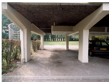
Détail des pilotis ménageant des parkings sous les bâtiments.
