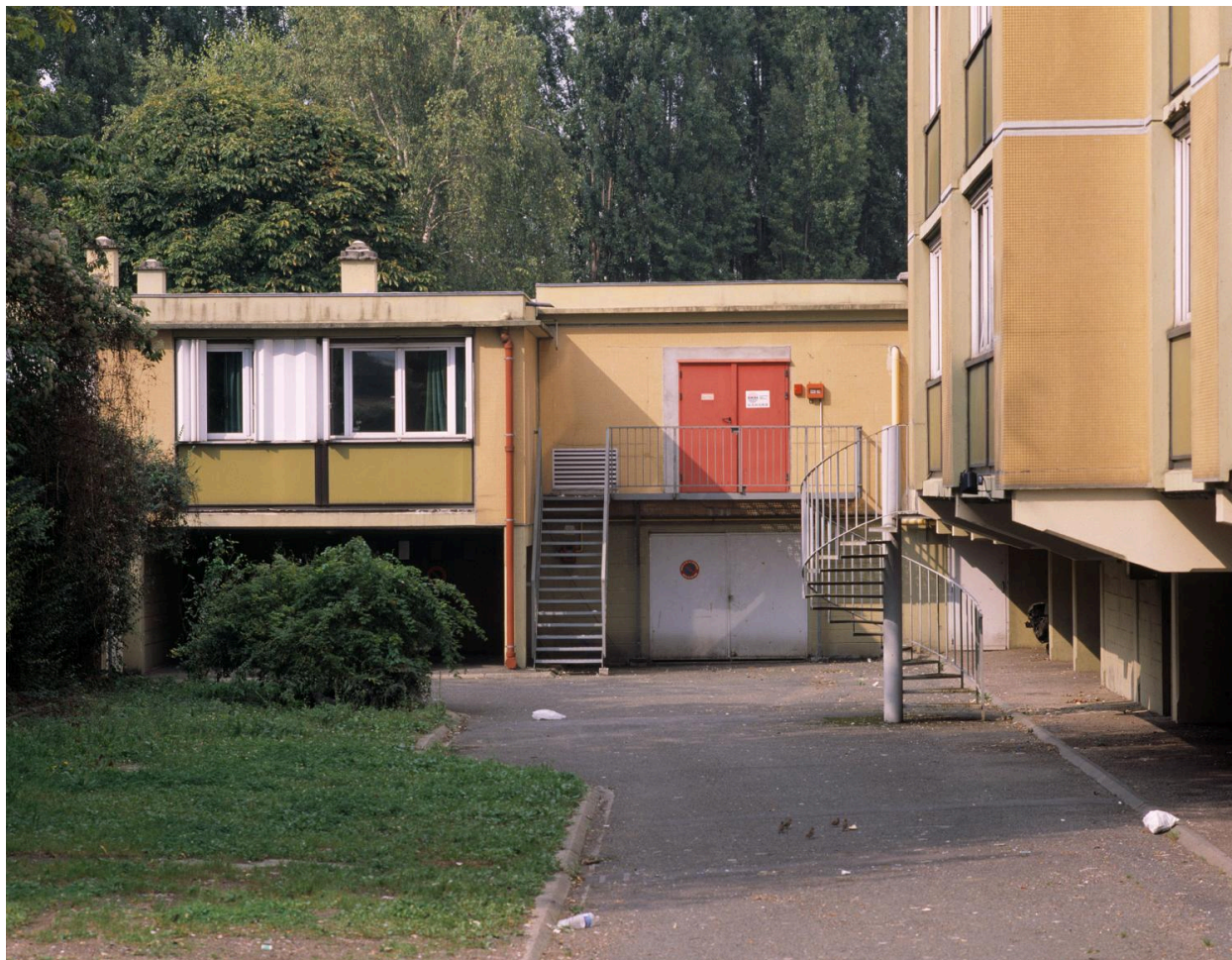
Vue du bâtiment de la chaufferie et du logement des gérants situé sur la façade postérieure, derrière l'entrée.
