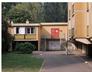
Vue du bâtiment de la chaufferie et du logement des gérants situé sur la façade postérieure, derrière l'entrée. Phot. Philippe Ayrault
