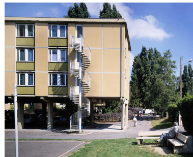
Vue partielle de l'aile sud du bâtiment. Phot. Philippe Ayrault IVR11_20029101081VA
