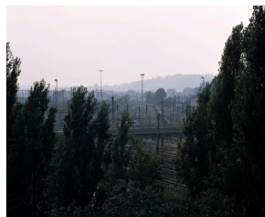
Vue sur la voie ferrée, prise du toit-terrasse du bâtiment.
