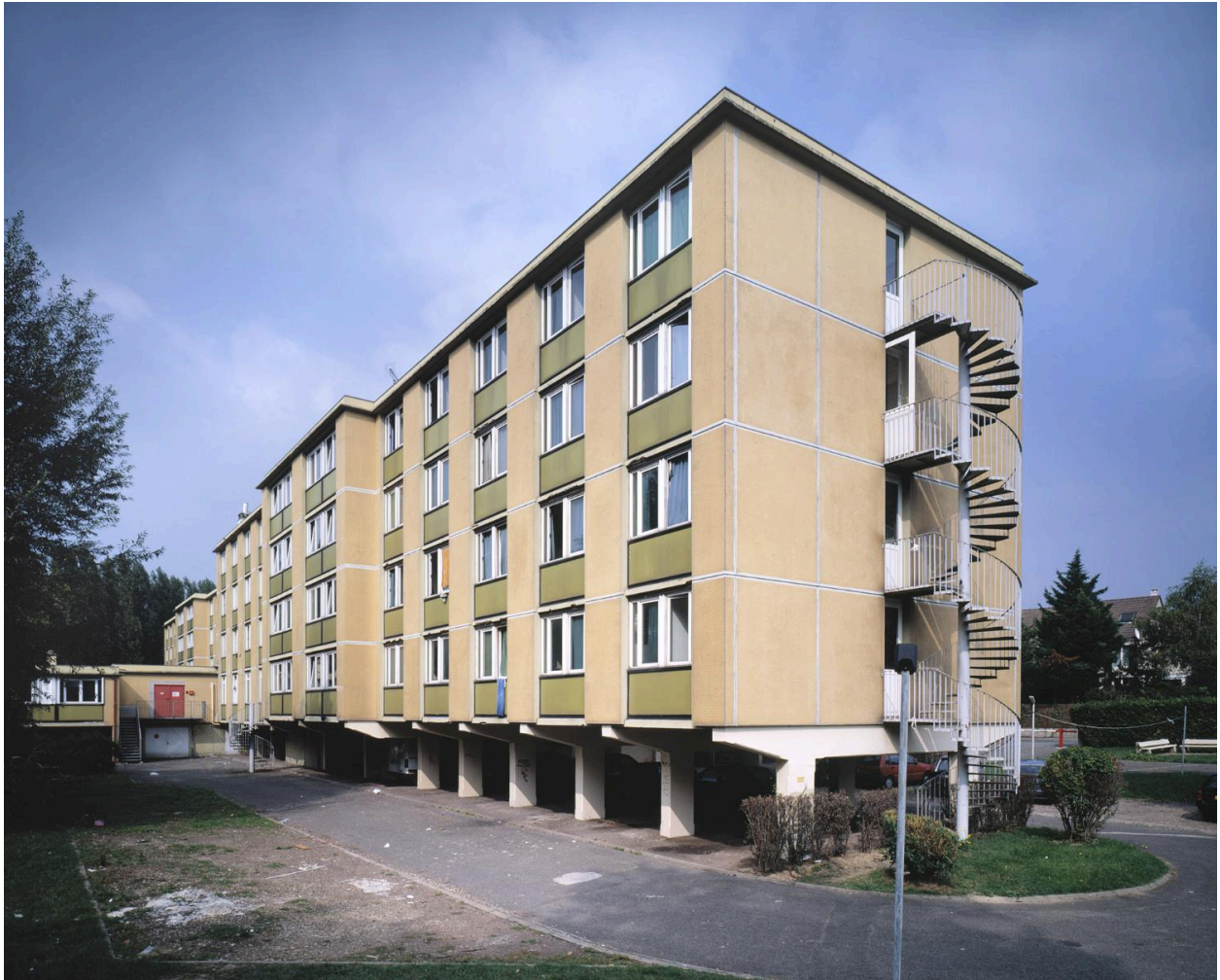
Vue d'ensemble de l'aile sud du bâtiment (façade postérieure).
