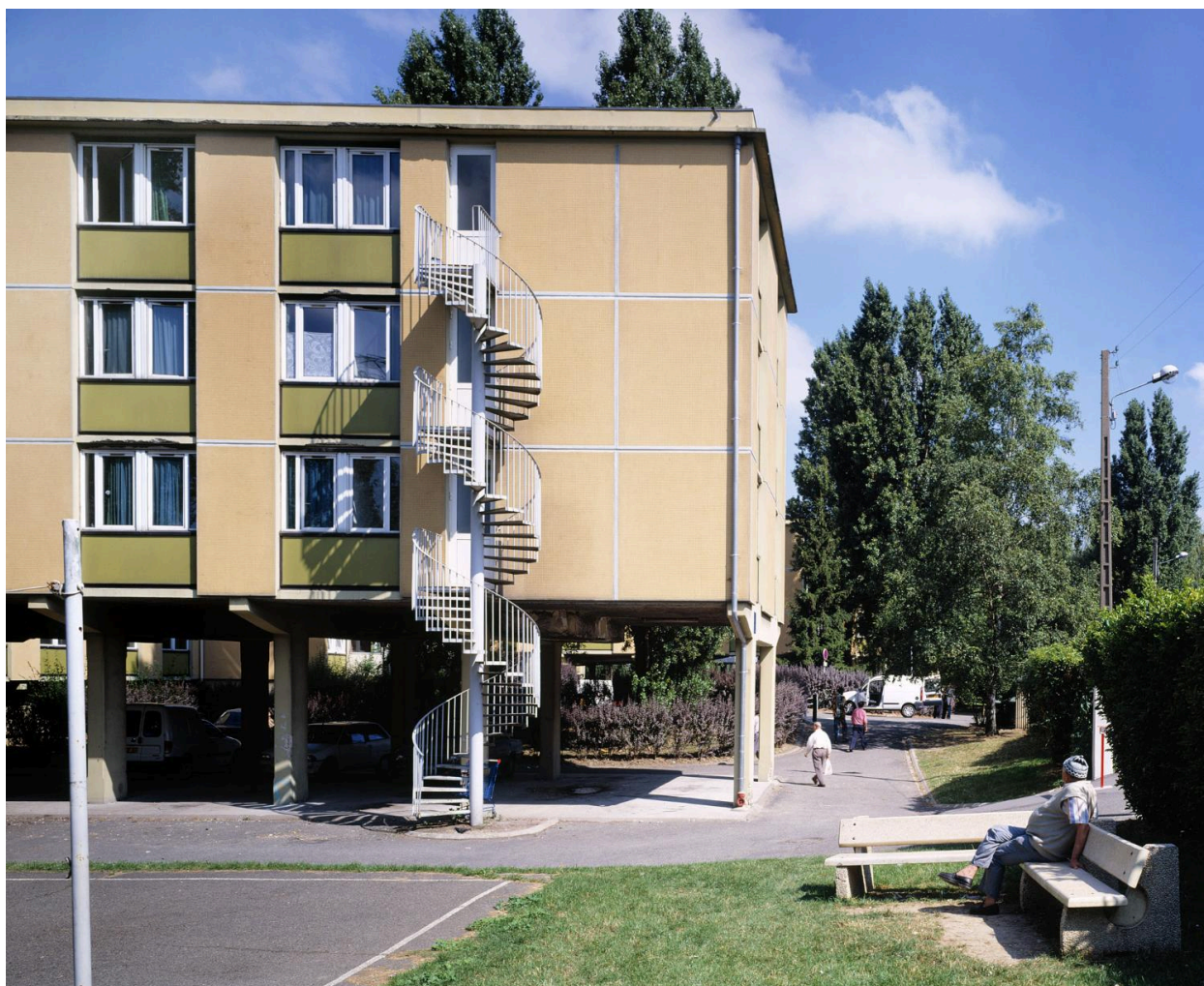
Vue partielle de l'aile sud du bâtiment.
