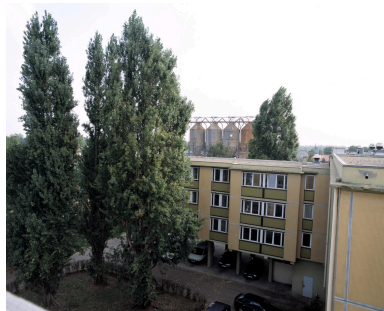
Vue d'une partie des bâtiments depuis le toit-terrasse (façade nord du bâtiment perpendiculaire à l'aile sud).
