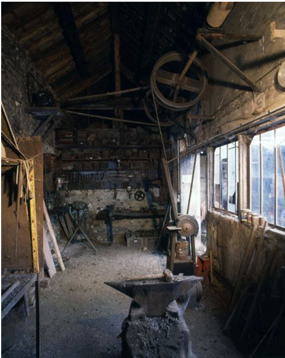
L'ancienne forge : le système de courroie qui actionnait les machines de l'atelier est encore en place.
