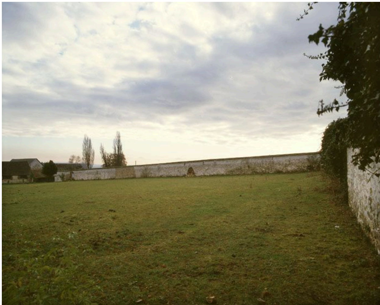
Mur de clôture de l'ancien potager servant aussi de mur à chasselas.
