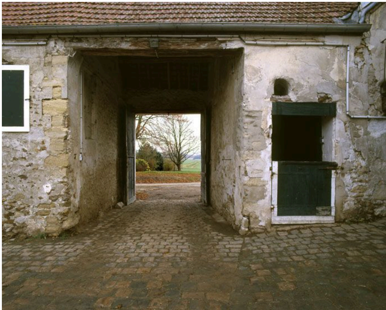
Vue de la seconde porte charretière.
