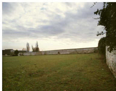
Mur de clôture de l'ancien potager servant aussi de mur à chasselas. Phot. Laurent Kruszyk IVR11_20077800539XA
