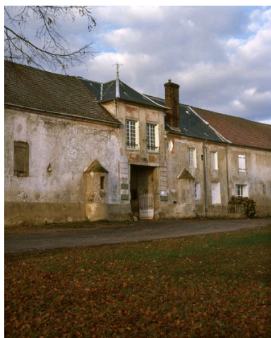
Façade antérieure : vue de trois quarts. Phot. Laurent Kruszyk IVR11_20077800510XA
