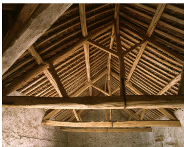
La charpente de la grange qui ferme la cour à l'angle nord est. Phot. Laurent Kruszyk IVR11_20077800542XA
