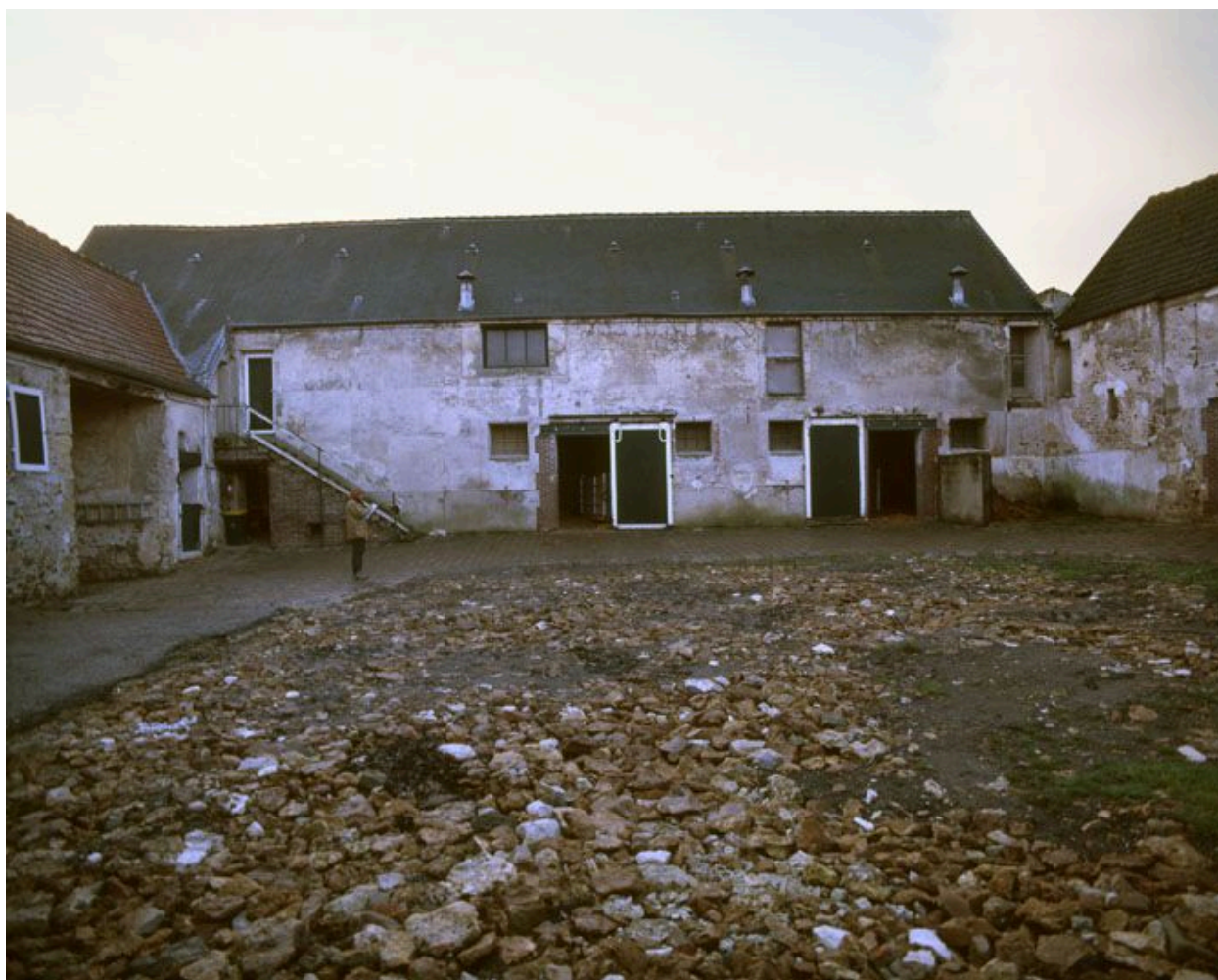
Vue depuis la cour du bâtiment sud comportant écuries et grenier.
