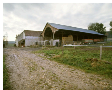
La façade nord avec la charreterie construite en 1909. Phot. Laurent Kruszyk IVR11_20077800514XA
