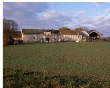
Vue du corps d'entrée et des bâtiments qui l'encadrent depuis les champs. Phot. Laurent Kruszyk IVR11_20077800502XA
