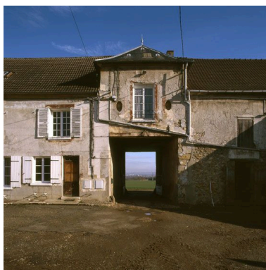
Vue du corps d'entrée depuis la cour. Phot. Laurent Kruszyk IVR11_20077800521XA
