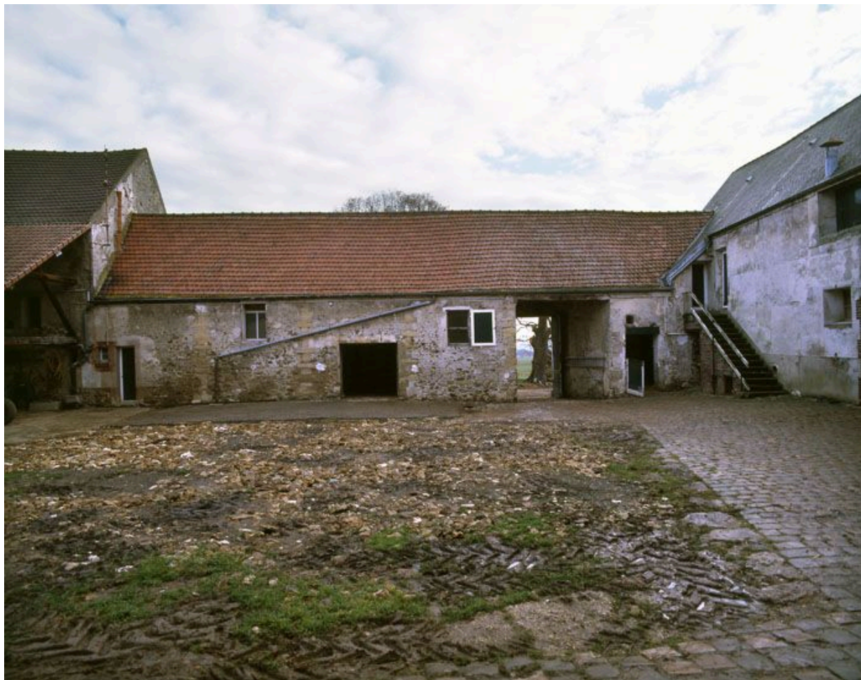
Vue de la seconde porte charretière qui se trouve à l'extrémité des bâtiments du corps d'entrée.
