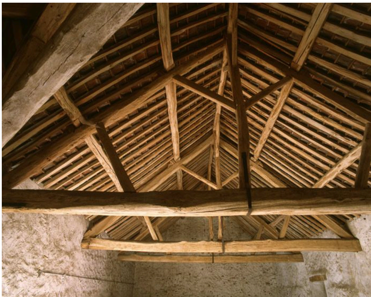
La charpente de la grange qui ferme la cour à l'angle nord est.
