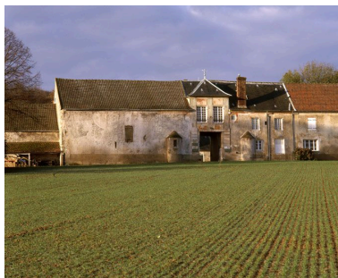
La façade antérieure de la ferme : vue de face. Phot. Laurent Kruszyk IVR11_20077800506XA
