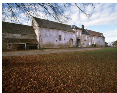
La façade antérieure de la ferme : vue de trois quarts. Phot. Laurent Kruszyk IVR11_20077800508XA
