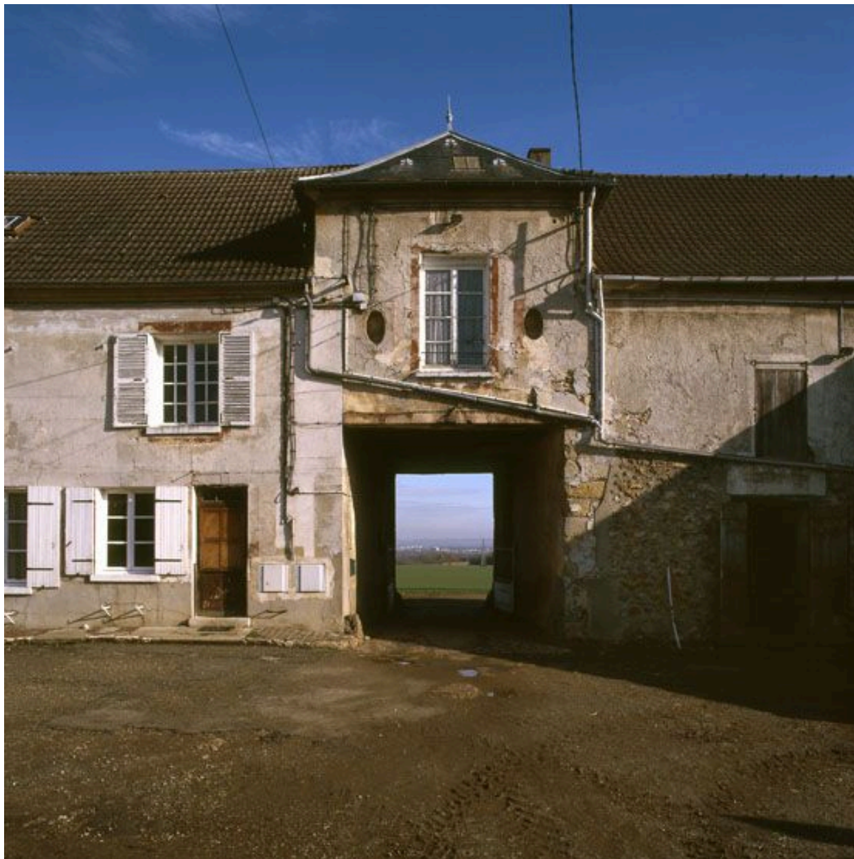
Vue du corps d'entrée depuis la cour.
