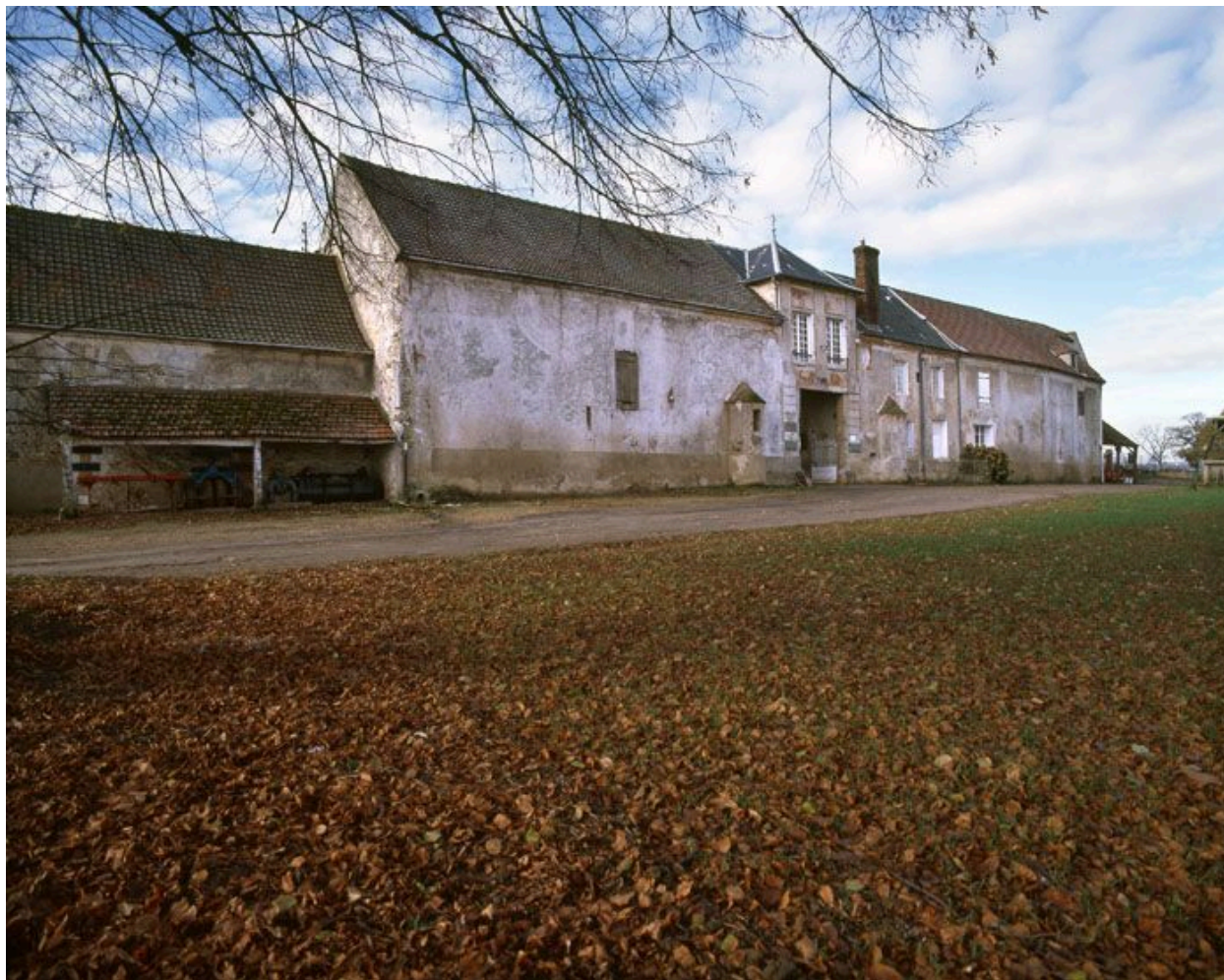
La façade antérieure de la ferme : vue de trois quarts.
