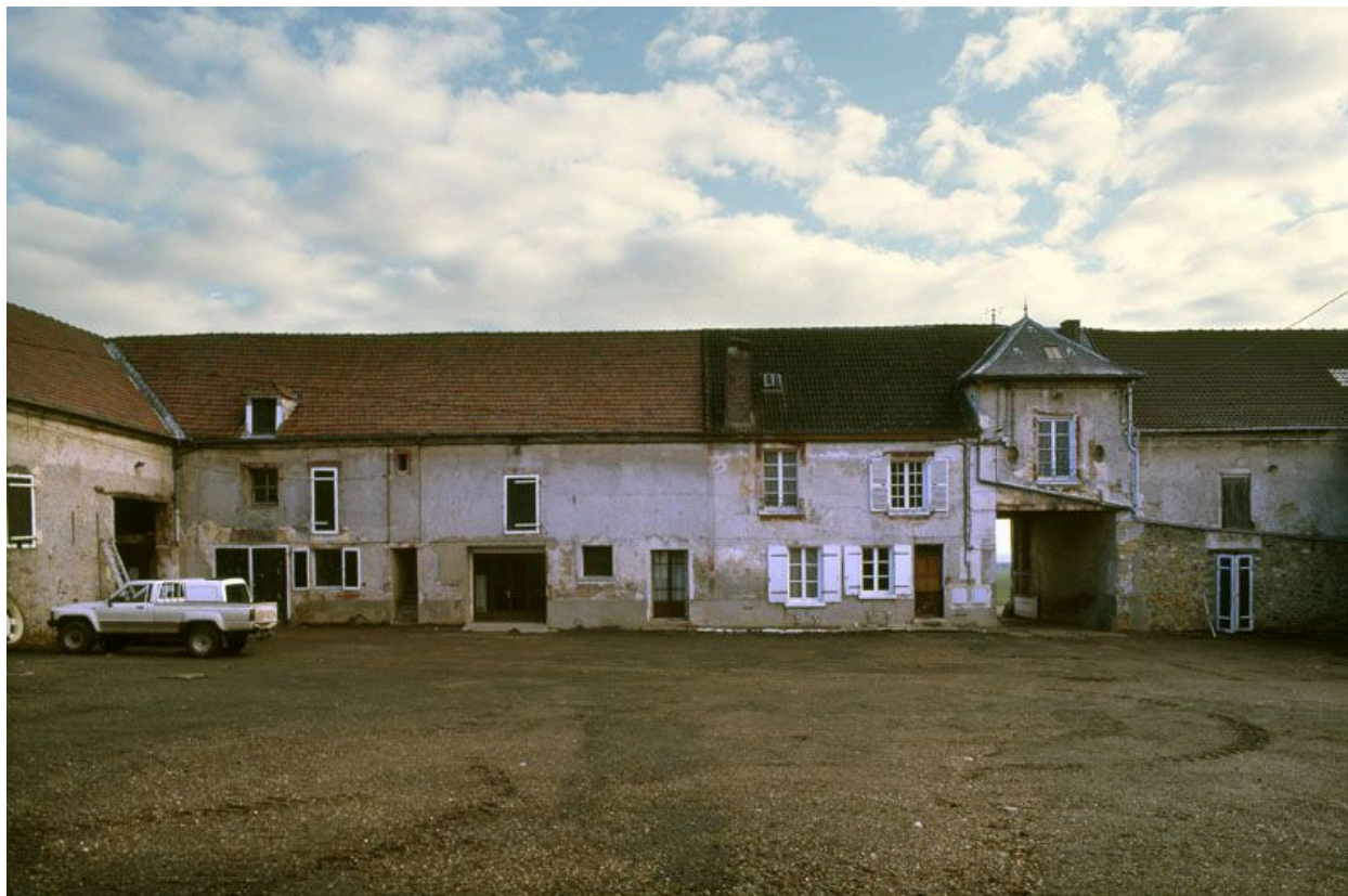
Vue du corps d'entrée depuis la cour.
