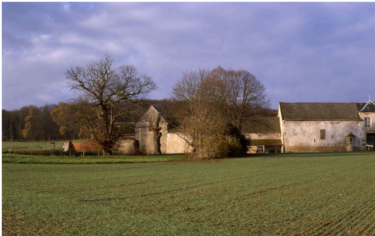
Vue d'une partie des bâtiments agricoles depuis les champs.
