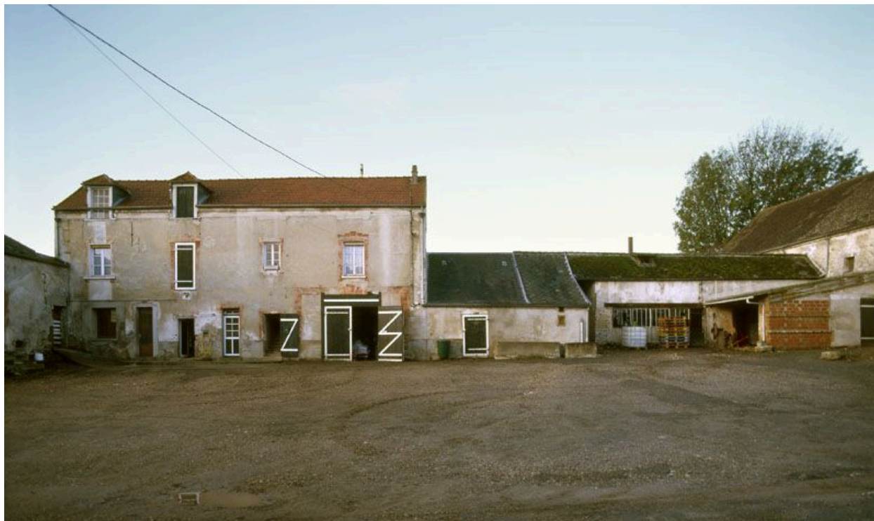
Vue d'ensemble des bâtiments sur le côté ouest de la cour.
