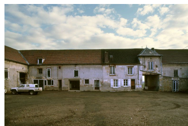
Vue du corps d'entrée depuis la cour. Phot. Laurent Kruszyk IVR11_20077800518XA
