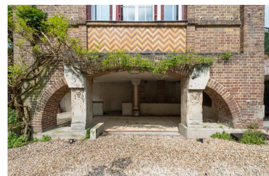
Soubassement de la façade principale de l'atelier Phot. Laurent Kruszyk IVR11_20199500003NUC4A
