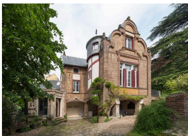
Façade principale de l'atelier Phot. Laurent Kruszyk IVR11_20199500001NUC4A
