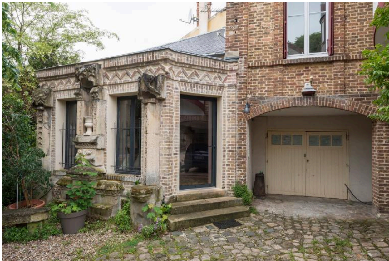
Détail du bâtiment accolé à l'atelier
