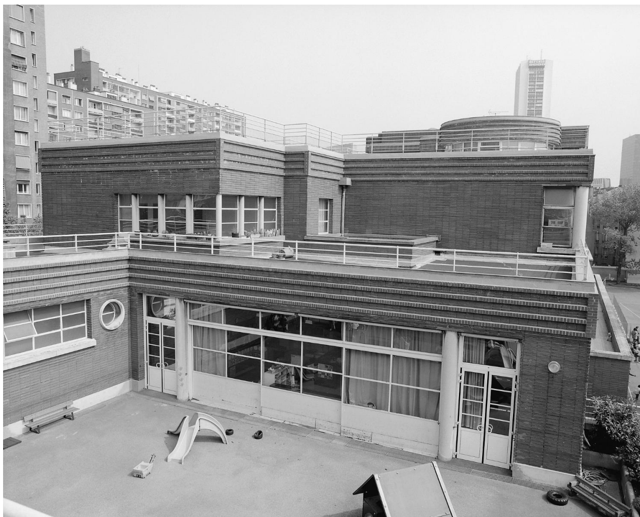
Vue sur les terrasses du côté de la maternelle.. Ecole maternelle, école primaire de garçons, école primaire de filles dites groupe scolaire Marius Jacotot
