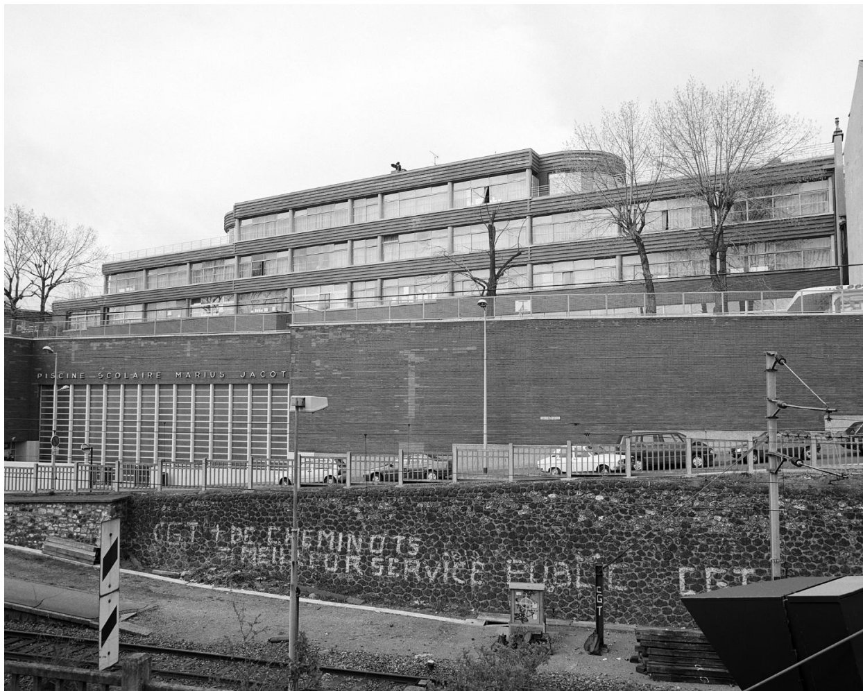
Vue d'ensemble de l'école depuis la voie de chemin de fer. Au premier plan, la grande baie en brique de verre qui éclaire la piscine. Ecole maternelle, école primaire de garçons, école primaire de filles dites groupe scolaire Marius Jacotot
