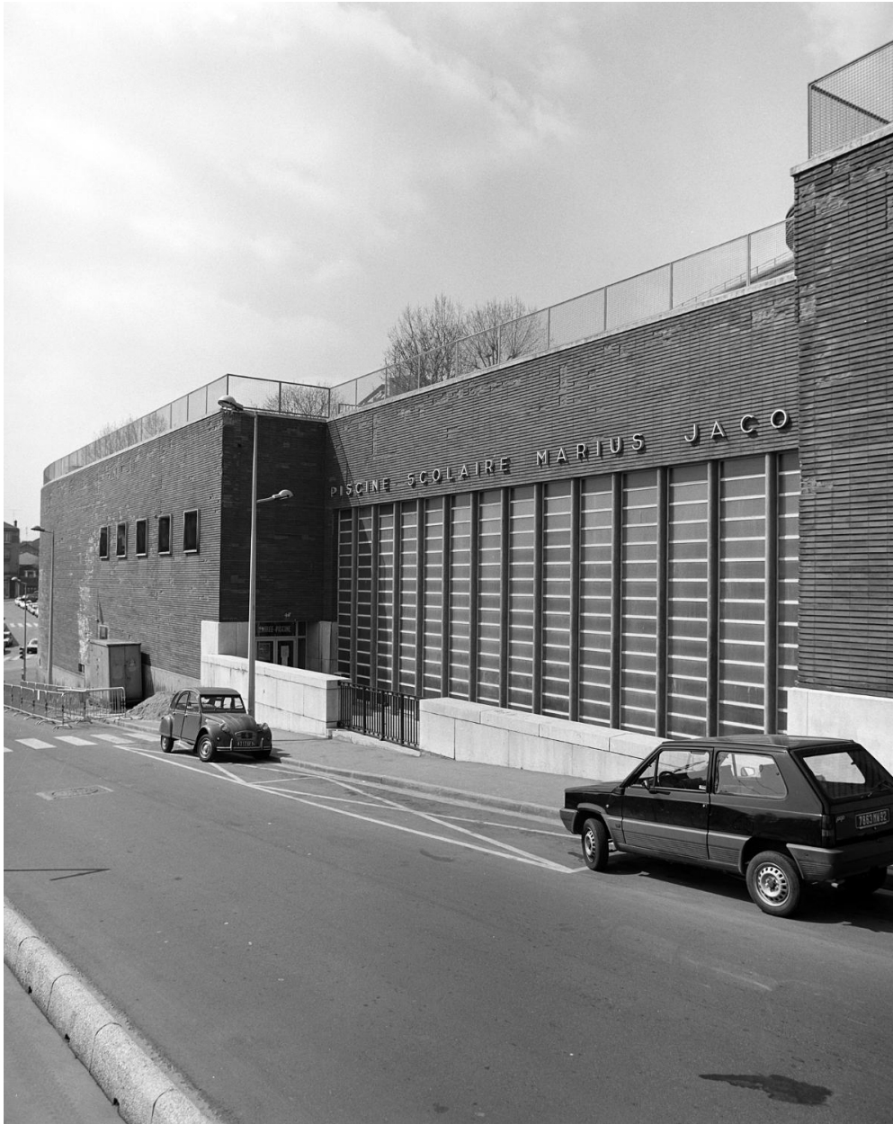
Piscine. Façade antérieure rue Fernand Pelloutier. Ecole maternelle, école primaire de garçons, école primaire de filles dites groupe scolaire Marius Jacotot
