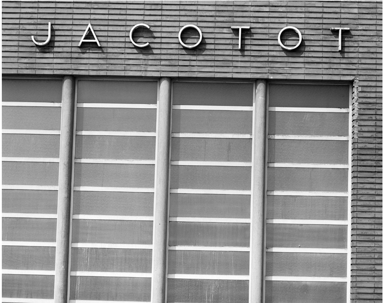
Piscine. Détail de la façade.. Ecole maternelle, école primaire de garçons, école primaire de filles dites groupe scolaire Marius Jacotot
