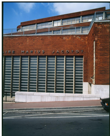
Détail de la façade de la piscine. Phot. Christian Décamps IVR11_19879200315XA
