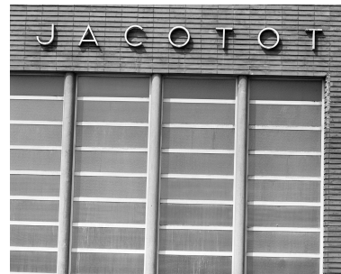
Piscine. Détail de la façade.. Ecole maternelle, école primaire de garçons, école primaire de filles dites groupe scolaire Marius Jacotot Phot. Christian Décamps IVR11_19879200317XS
