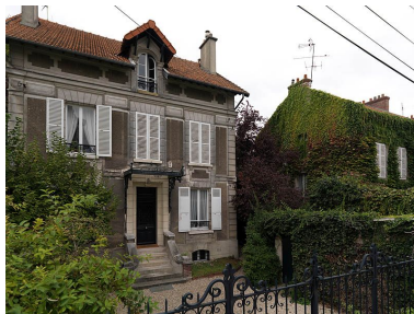
Vue de la villa au n°13. Phot. Stéphane Asseline IVR11_20097701445NUC4A
