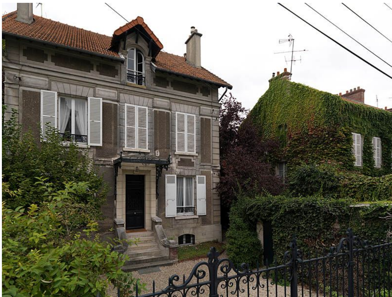
Vue de la villa au n°13.
