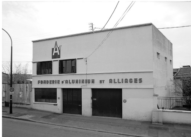
Vue de la façade prise du nord de la rue.
