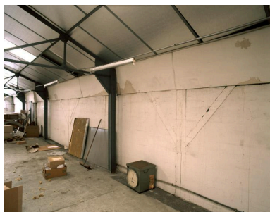
Intérieur du bâtiment de ""stockage du matériel"". Les murs à pans de bois hourdés de brique ont été coiffés tardivement d'une charpente métallique.
