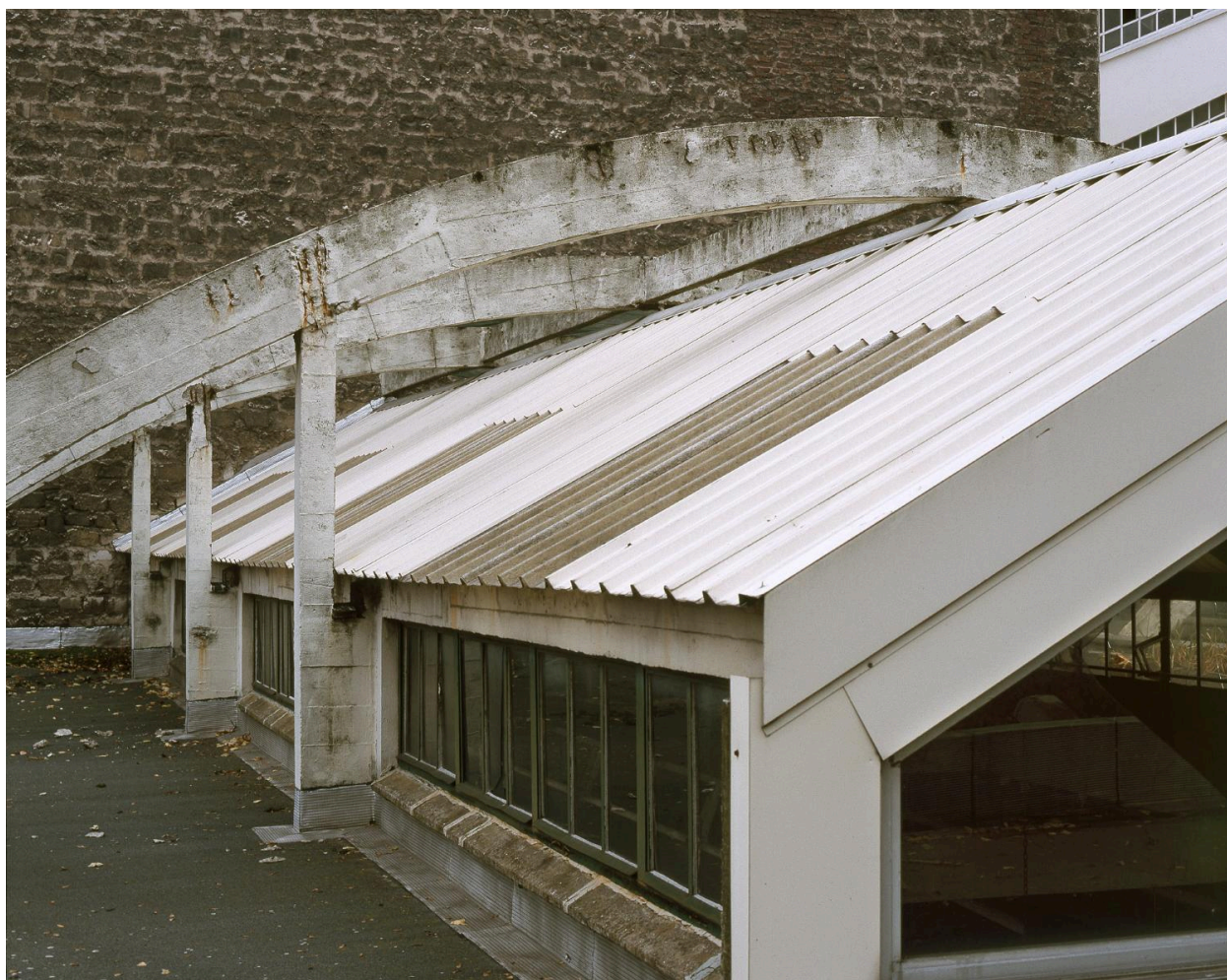
Détail d'un arceau et d'une l'aiguille de fixation de la toiture suspendue.
