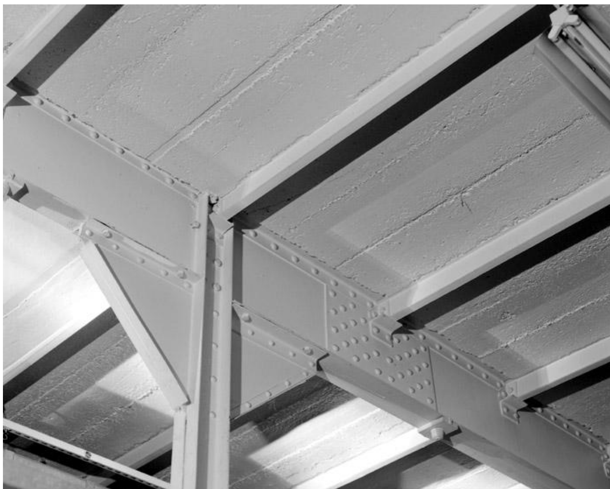
Intérieur du bâtiment de ""stockage du matériel"". Rez-de-chaussée : structure métallique, soutenant le plancher du premier étage, installée après la construction des murs à pans de bois hourdés de brique.
