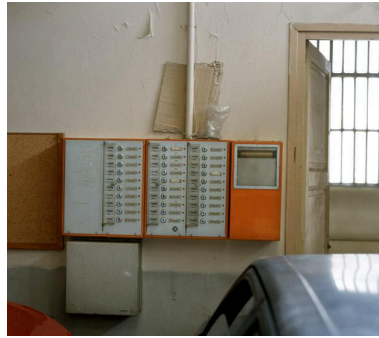
Intérieur de la halle n° 2. Pointeuse. IVR11_20059300080XA
