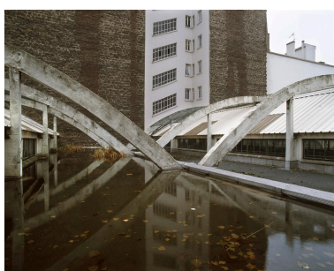
Arceaux et système de fixation de la toiture suspendue. IVR11_20059300069XA
