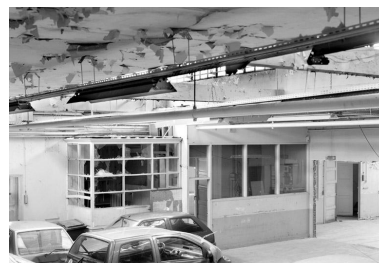
Intérieur de la halle n° 2 (partie manutention). Bureau.
