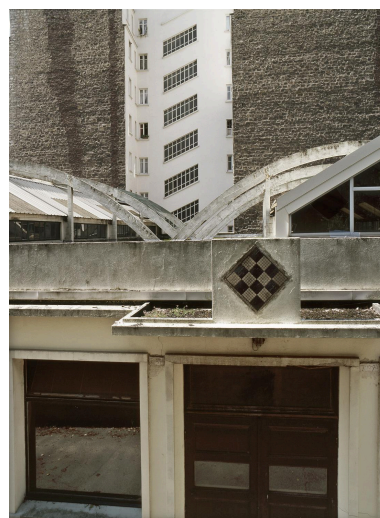
Toiture partiellement dissimulée par le bandeau de couronnement de la façade. Phot. Laurent Kruszyk IVR11_20049300437XA
