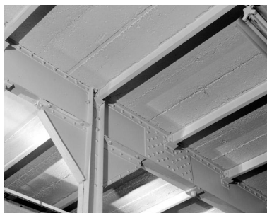
Intérieur du bâtiment de ""stockage du matériel"". Rez-de-chaussée : structure métallique, soutenant le plancher du premier étage, installée après la construction des murs à pans de bois hourdés de brique.
