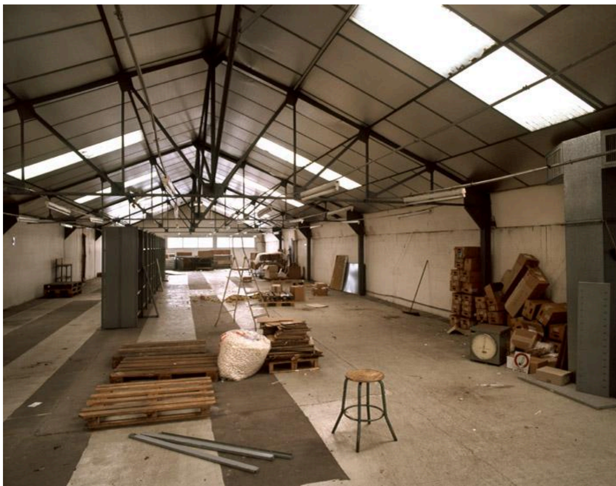
Intérieur du bâtiment de ""stockage du matériel"" , ancien atelier ou entrepôt de l'usine de menuiserie Cuperly.
