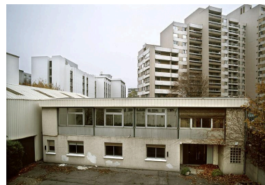
Vue du bâtiment de l'administration.
