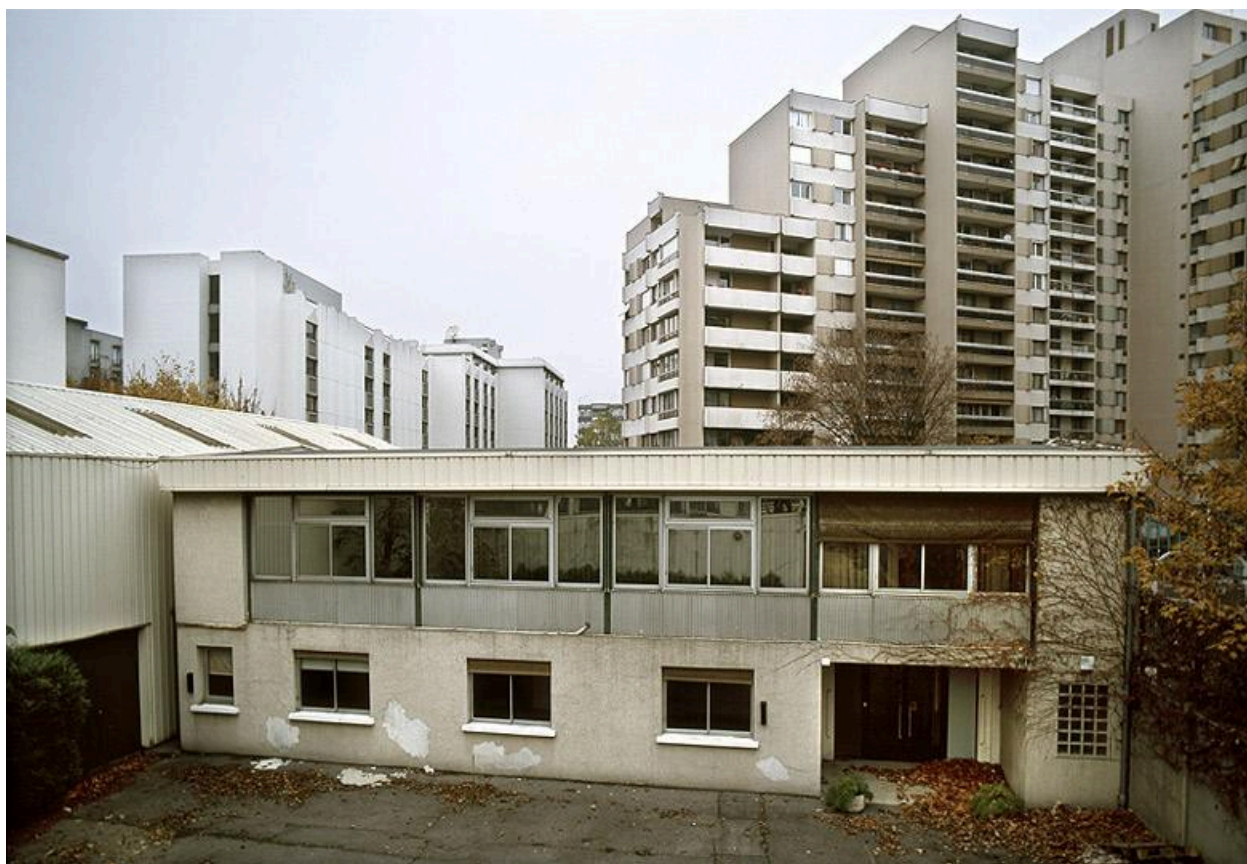
Vue du bâtiment de l'administration.
