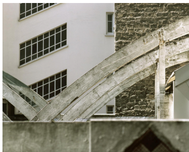
Détail d'un arceau en béton armé et du système de fixation, également en béton armé, de la toiture suspendue.
