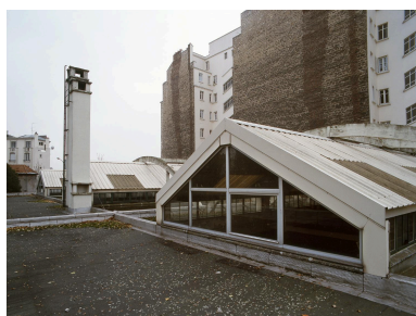
Toiture des trois halles et cheminée de la chaufferie. IVR11_20059300059XA
