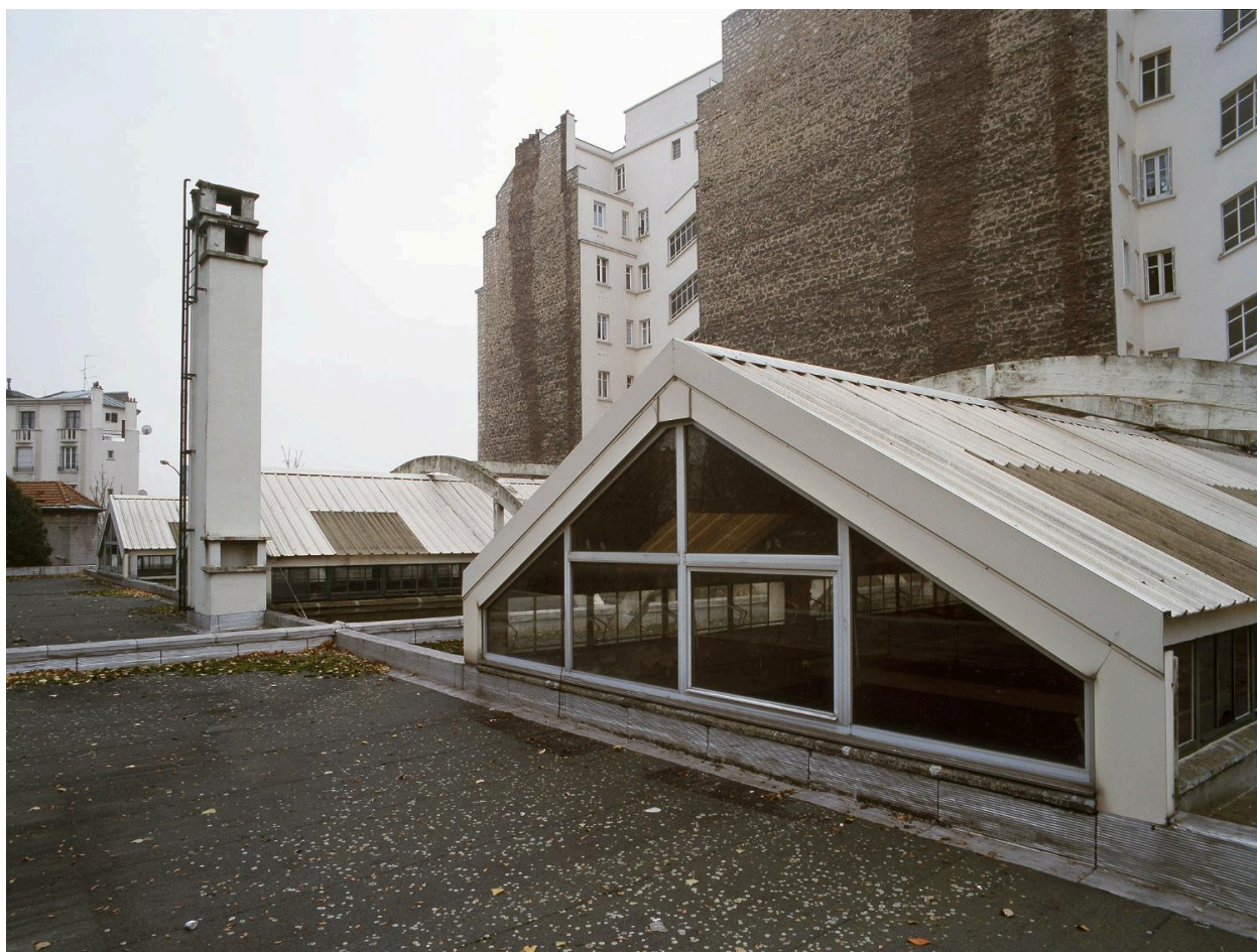
Toiture des trois halles et cheminée de la chaufferie.
