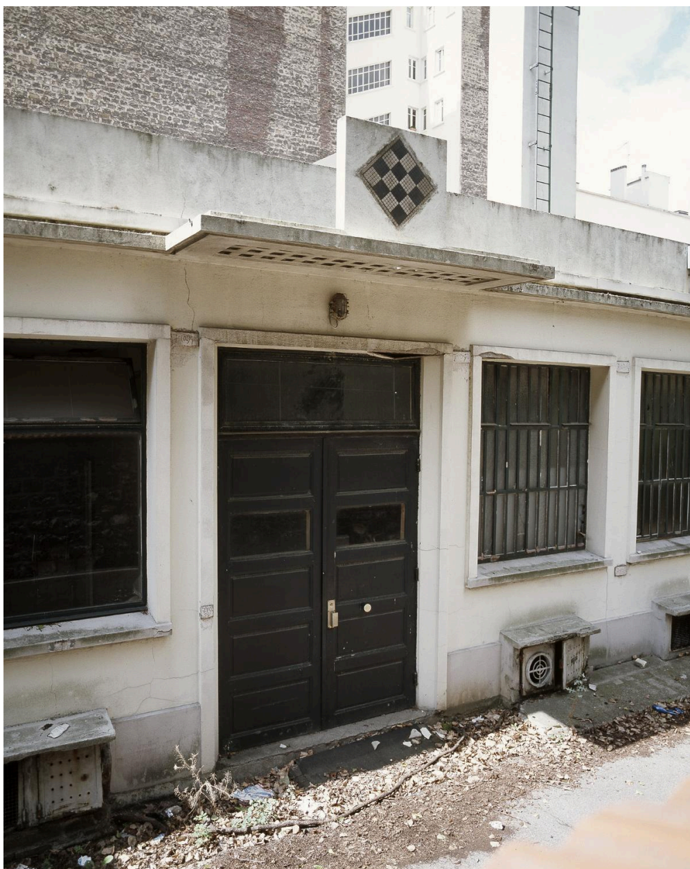
Entrée surmontée d'un auvent en béton translucide (pavés de verre).
