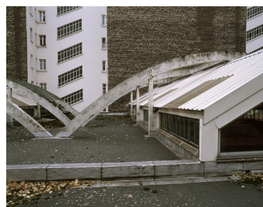
Arceaux et système de fixation de la toiture suspendue. IVR11_20059300063XA
