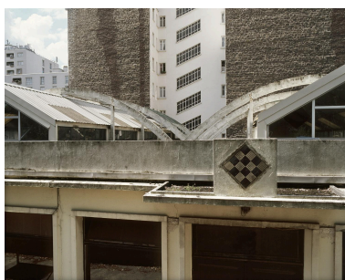
La toiture de chaque halle est suspendue par trois arceaux de béton armé inscrits dans la largeur du bâtiment. Phot. Laurent Kruszyk IVR11_20049300435XA
