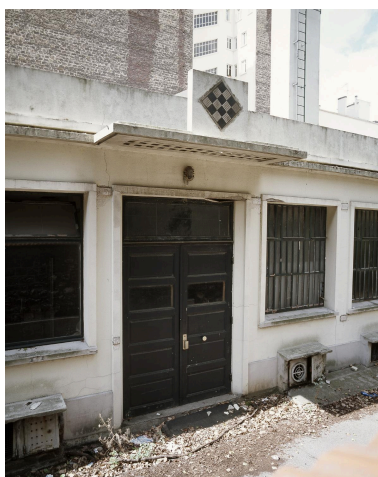
Entrée surmontée d'un auvent en béton translucide (pavés de verre). Phot. Laurent Kruszyk IVR11_20049300440XA
