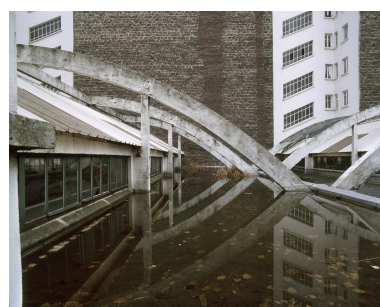
Détail d'un arceau et d'une l'aiguille de fixation de la toiture suspendue. IVR11_20059300067XA
