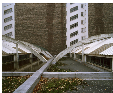
Arceaux et système de fixation de la toiture suspendue. IVR11_20059300061XA
