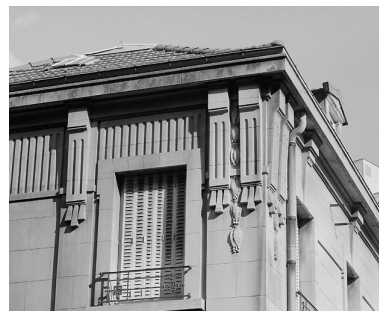
Vue de détail des ornements de la façade. Phot. Jean-Bernard Vialles IVR11_20019300361X
