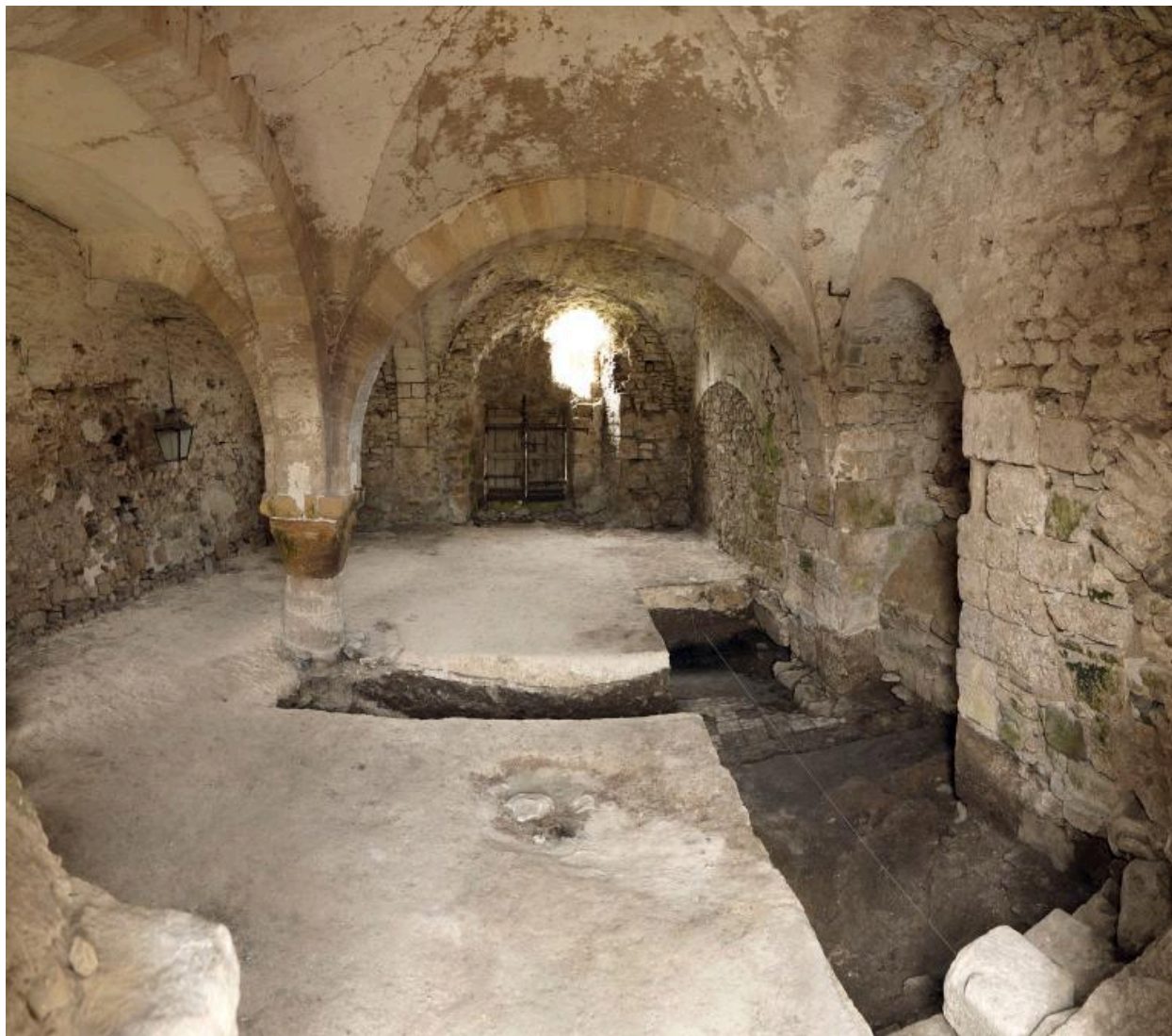
Vue sur la salle 4 (numérotation du sud vers le nord) de la grange des Beauvais depuis l'angle nord-est.
