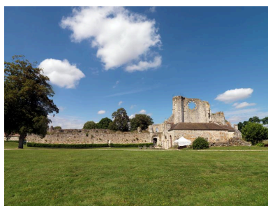
Vue générale des ruines de l'église abbatiale depuis le sud. Phot. Jean-Bernard Vialles IVR11_20167700167NUC4A
