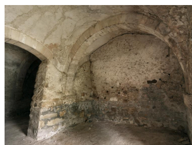
Vue sur le mur nord de la salle 3 de la grange des Beauvais depuis l'angle sud-est. Phot. Jean-Bernard Vialles IVR11_20167700182NUC4A
