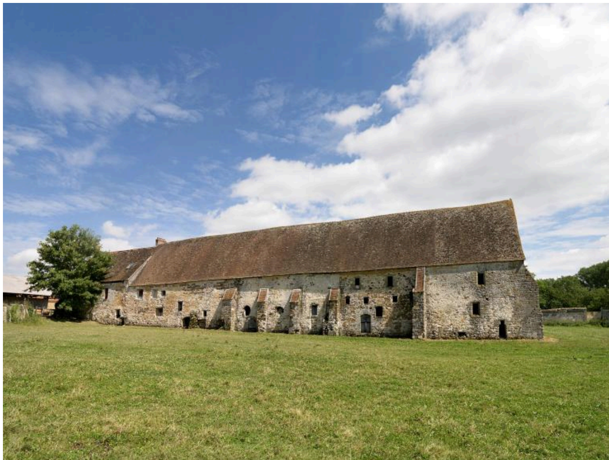
Façade ouest de la grange des Beauvais.
