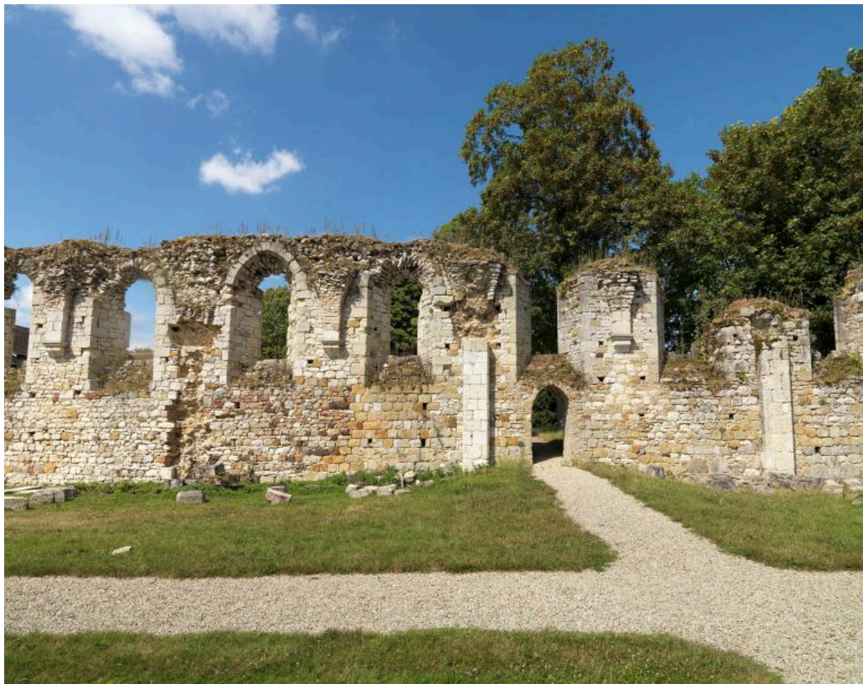
Mur gouttereau nord de la nef.
