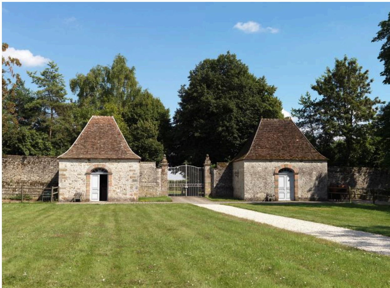
Vue sur le petit porche d'entrée depuis l'intérieur.
