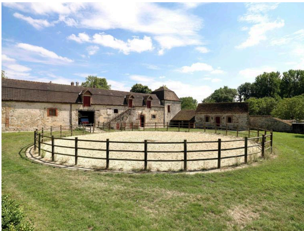
Vue sur le manège depuis le nord-ouest.
