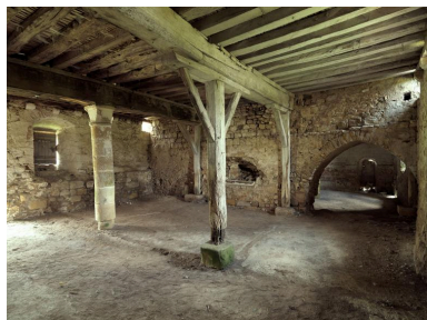
Vue sur la salle 2 de la grange des Beauvais depuis l'angle nord-ouest. Phot. Jean-Bernard Vialles IVR11_20167700183NUC4A
