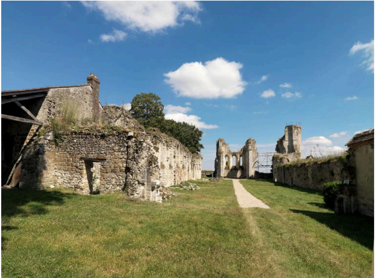
Vue d'ensemble des ruines de l'église abbatiale, depuis l'ouest.
