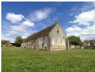
Vue sur le mur pignon sud et sur la façade ouest de la grange des Beauvais. Phot. Jean-Bernard Vialles IVR11_20167700174NUC4A
