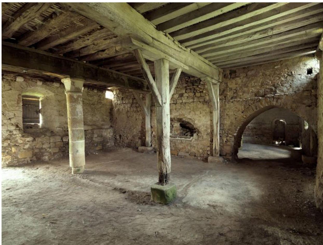
Vue sur la salle 2 de la grange des Beauvais depuis l'angle nord-ouest.
