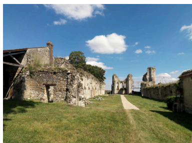
Vue d'ensemble des ruines de l'église abbatiale, depuis l'ouest. Phot. Jean-Bernard Vialles IVR11_20167700161NUC4A
