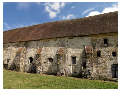
Détail façade ouest de la grange des Beauvais. Phot. Jean-Bernard Vialles IVR11_20167700176NUC4A
