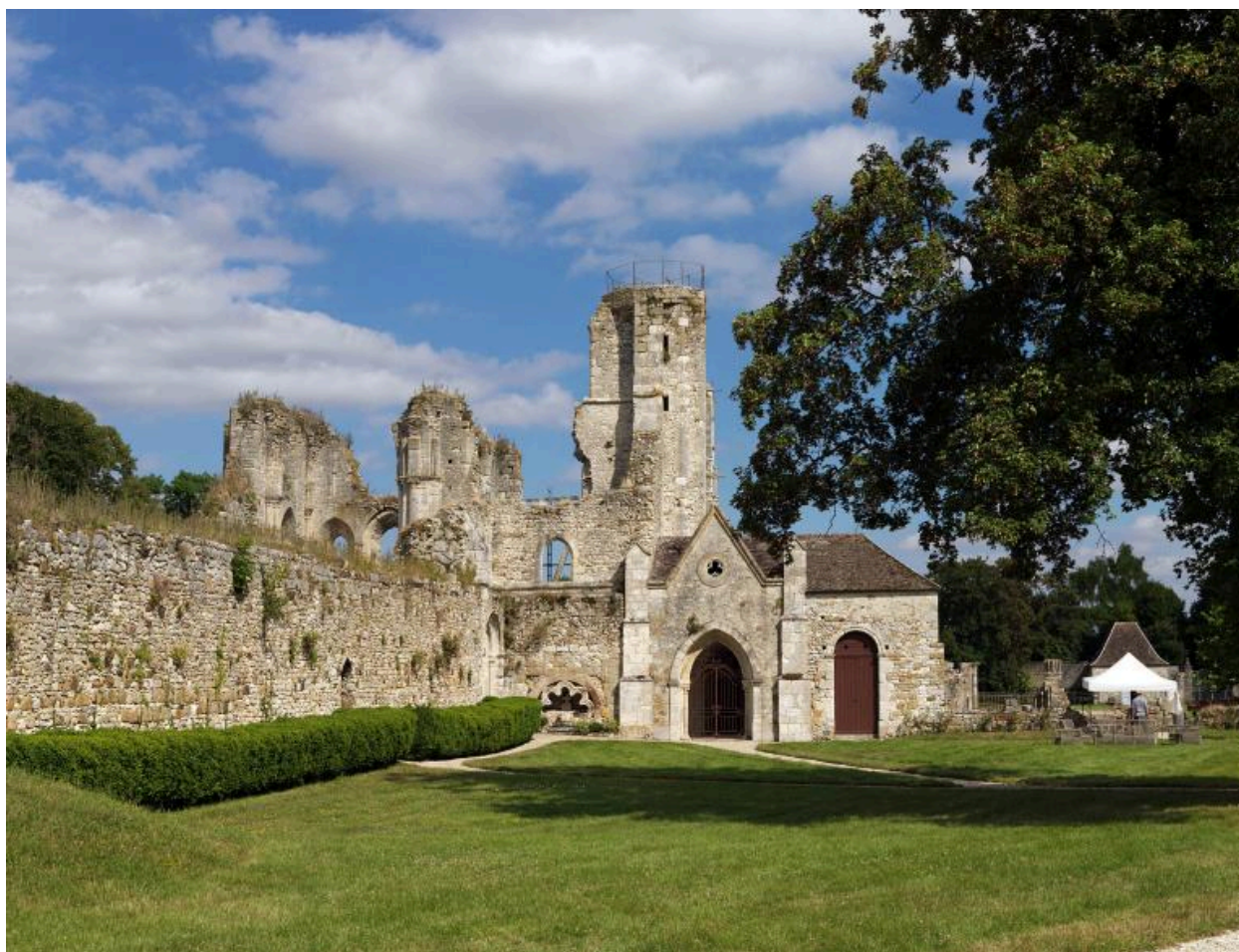
Vue sur les ruines de l'église abbatiale depuis le sud-ouest.
