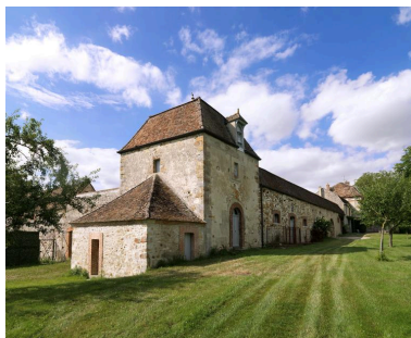
Vue sur la façade est de la grange. Phot. Jean-Bernard Vialles IVR11_20167700187NUC4A
