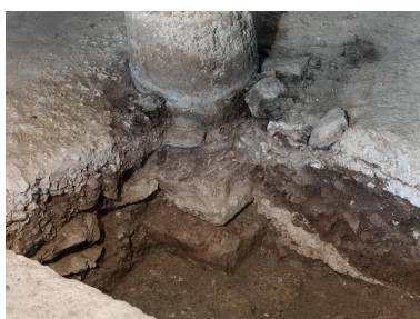
Détail du pilier central de la salle 4 de la grange des Beauvais. Phot. Jean-Bernard Vialles IVR11_20167700181NUC4A
