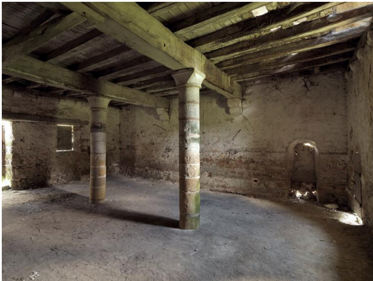
Vue sur la salle 1 de la grange des Beauvais depuis l'angle nord-est.
