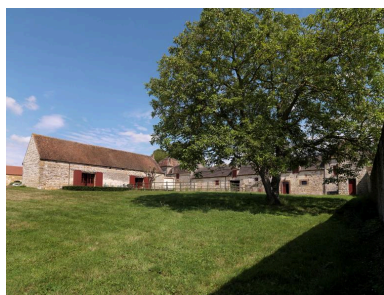
Vue sur le manège depuis le sud-ouest. Phot. Jean-Bernard Vialles IVR11_20167700189NUC4A
