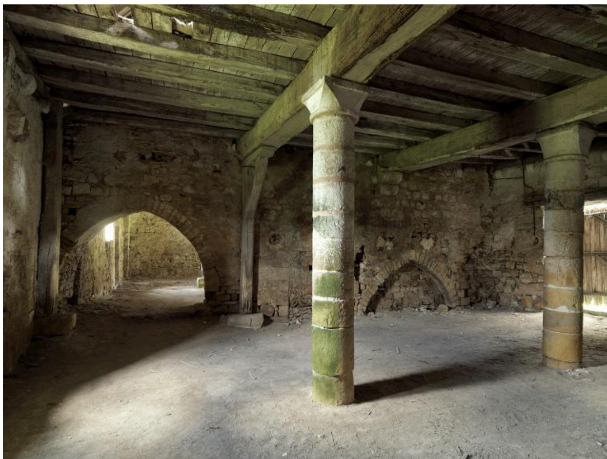
Vue sur la salle 1 de la grange des Beauvais depuis l'angle sud-est.
