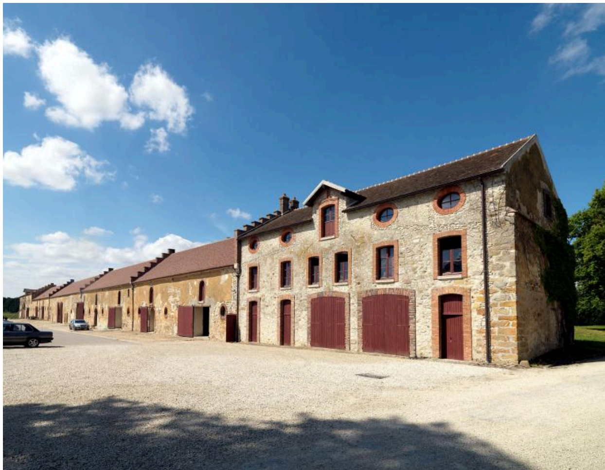
Vue sur les écuries depuis le sud-est.
