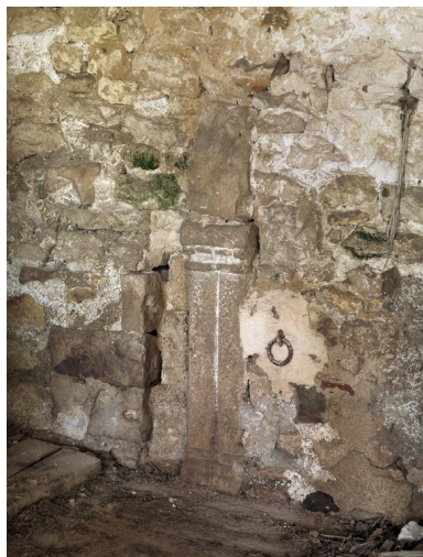
Détail de la salle 5 de la grange des Beauvais. Phot. Jean-Bernard Vialles IVR11_20167700186NUC4A
