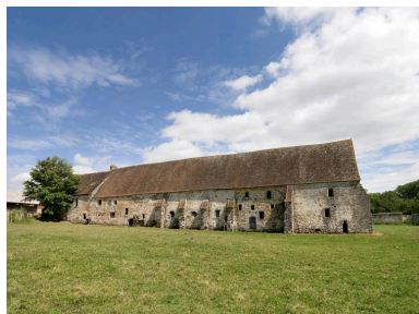
Façade ouest de la grange des Beauvais. Phot. Jean-Bernard Vialles IVR11_20167700173NUC4A
