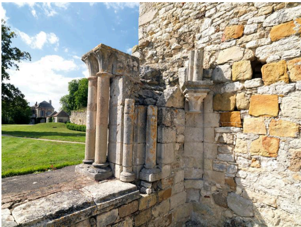
Détail angle nord-ouest de la salle capitulaire.
