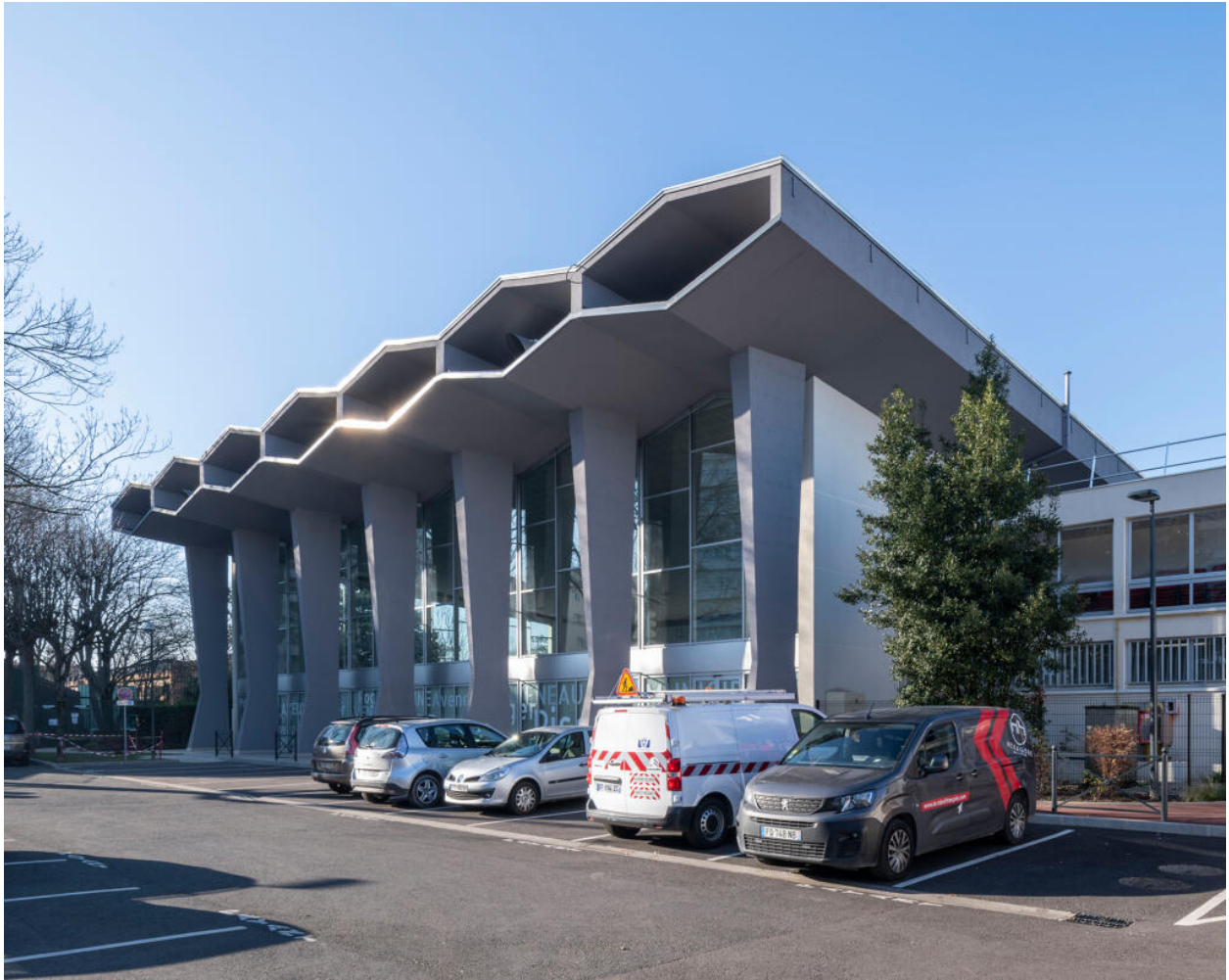
La piscine Roger Aveneau. Façade principale et entrée.
