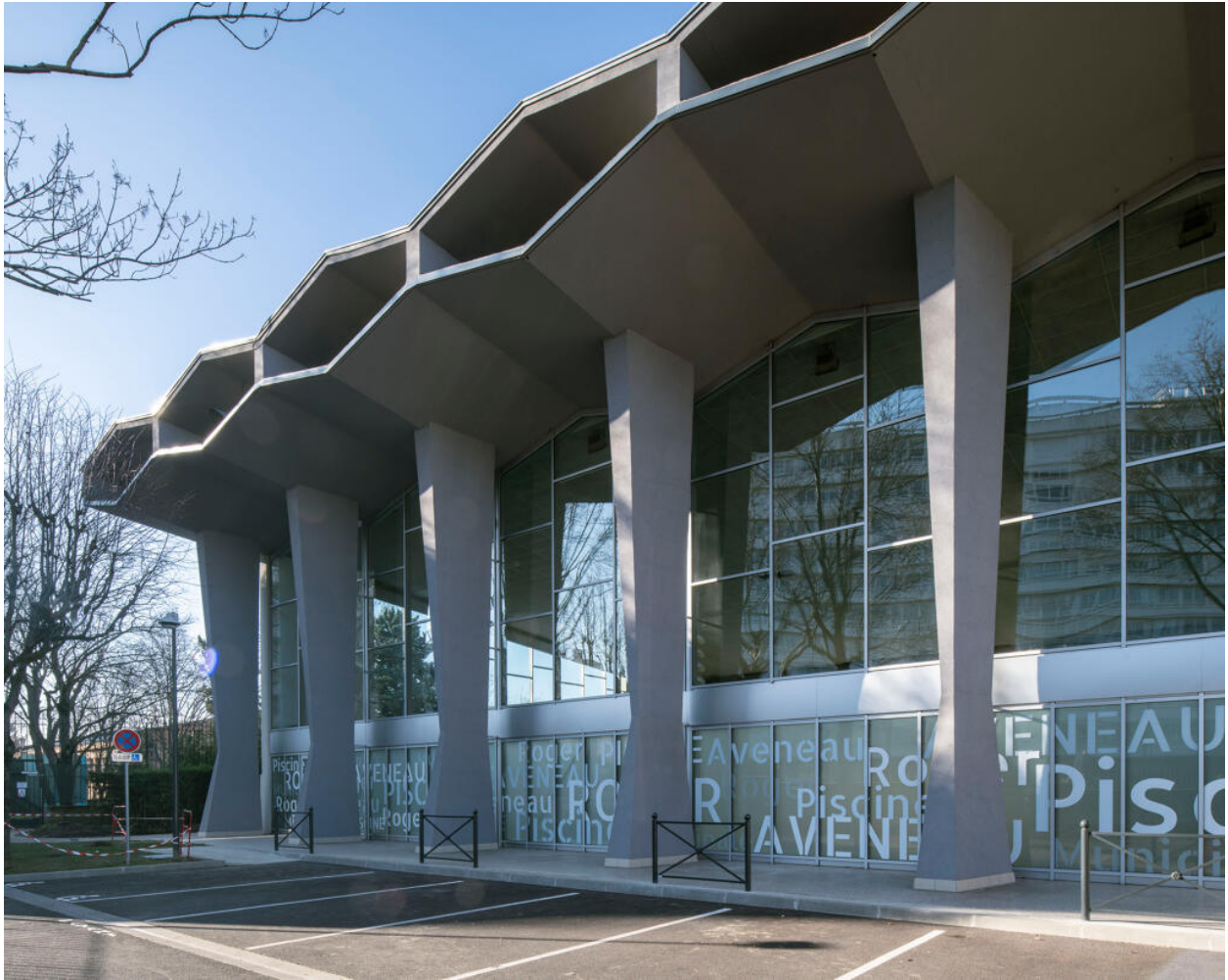
La piscine Roger Aveneau. Façade principale et sa couverture alvéolaire.
