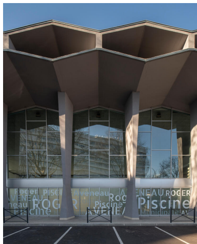
La piscine Roger Aveneau. Détail sur la charpente à structure alvéolaire. Phot. Ayrault Philippe IVR11_20229200023NUC4A
