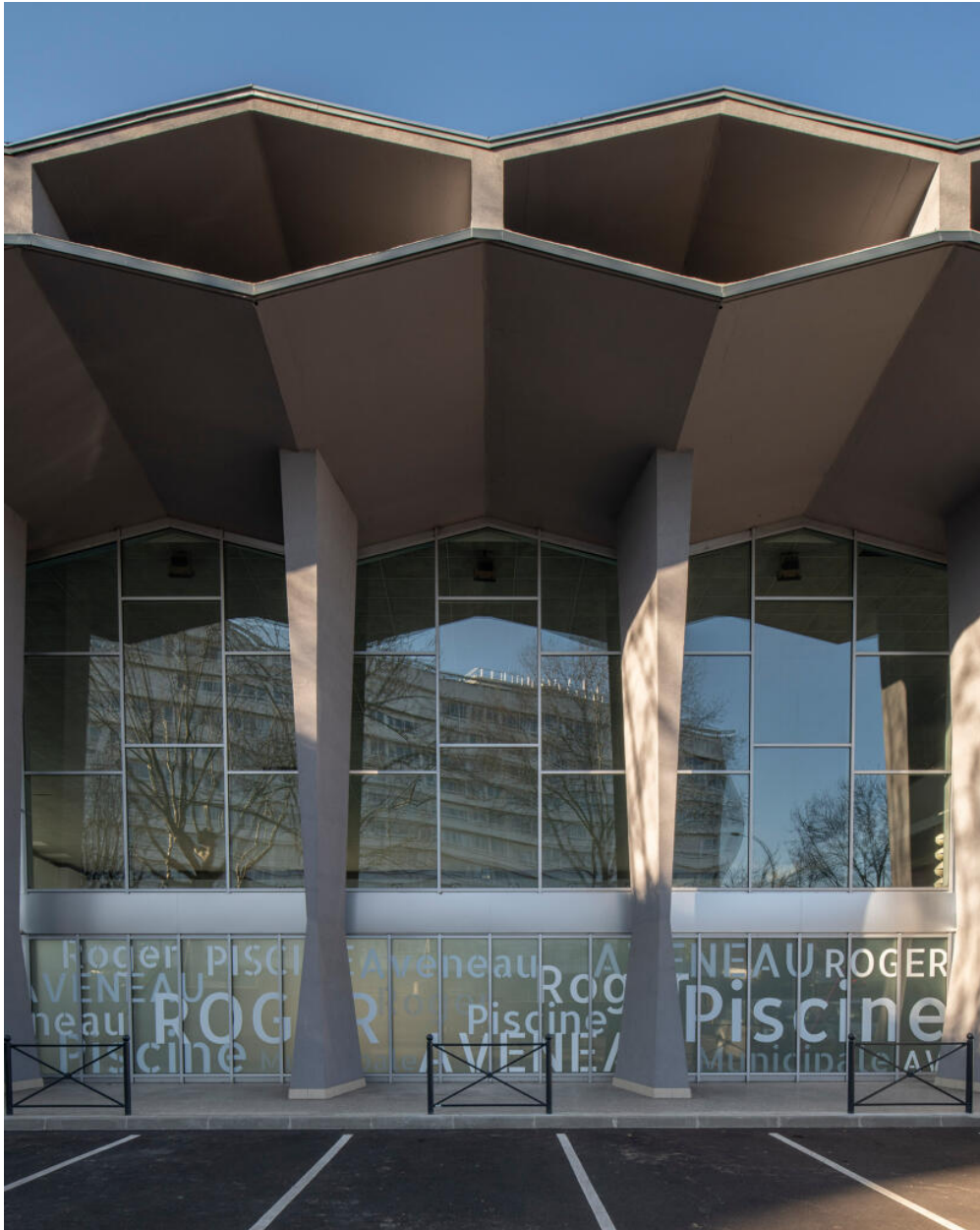
La piscine Roger Aveneau. Détail sur la charpente à structure alvéolaire.
