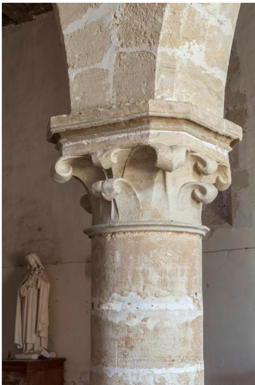
Chapiteau de la troisième colonne des grandes arcades.
