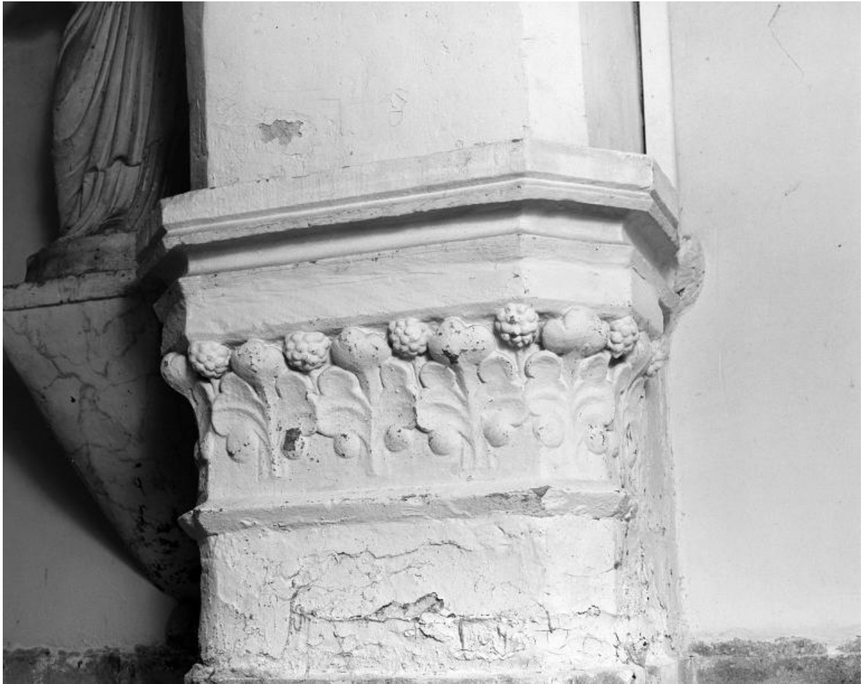
Vue du chapiteau du pilier engagé du mur ouest (état en 1991).
