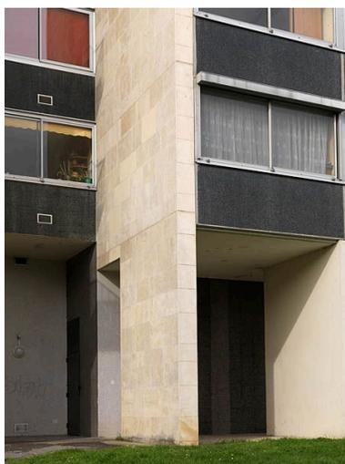
Alternance de parpaings de pierre et mosaïque de grès cérame gris. Ce détail du plan de construction de la tour : les panneaux de cuisine sont décrochés des panneaux des séjours et chambres, il s'agit d'une construction selon un plan écartelé et décalé du noyau central. Ce décrochement laisse apparaître le refend porteur en pierre perpendiculaire à la façade.
