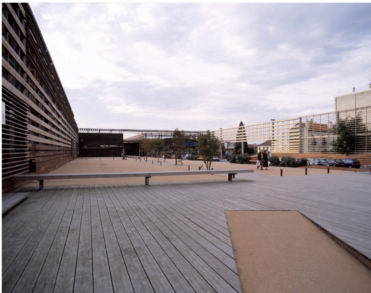
Vue d'ensemble de la place du marché réaménagée en 2001 ; des claustra de bois recouvrent le mur latéral de l'école Jules Ferry.
