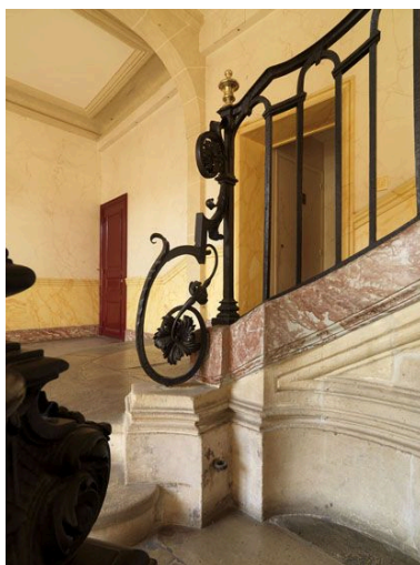
Vue latérale de la console de départ. Phot. Laurent Kruszyk IVR11_20097501580NUC4A
