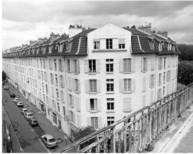
Vue de l'ensemble nord depuis la passerelle de l'Avre. Phot. Ayrault Philippe IVR11_19979200097X
