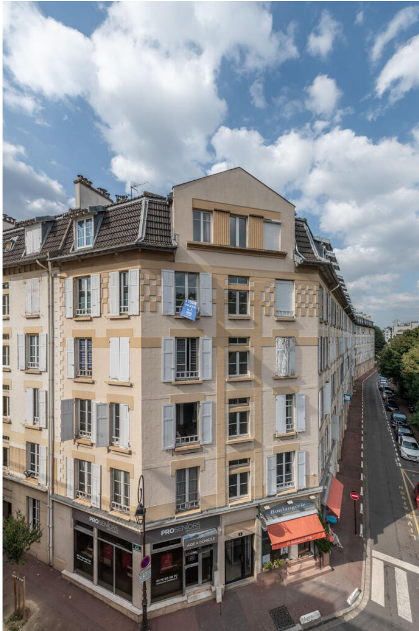
Immeubles, ensemble nord, vue du pan-coupé et du pignon sud-est depuis la passerelle de l'Avre
