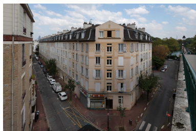
Immeubles, ensemble nord, pan-coupé et pignon sud-ouest, vue depuis la passerelle de l'Avre Phot. Kruszyk Laurent IVR11_20249200439NUC4A
