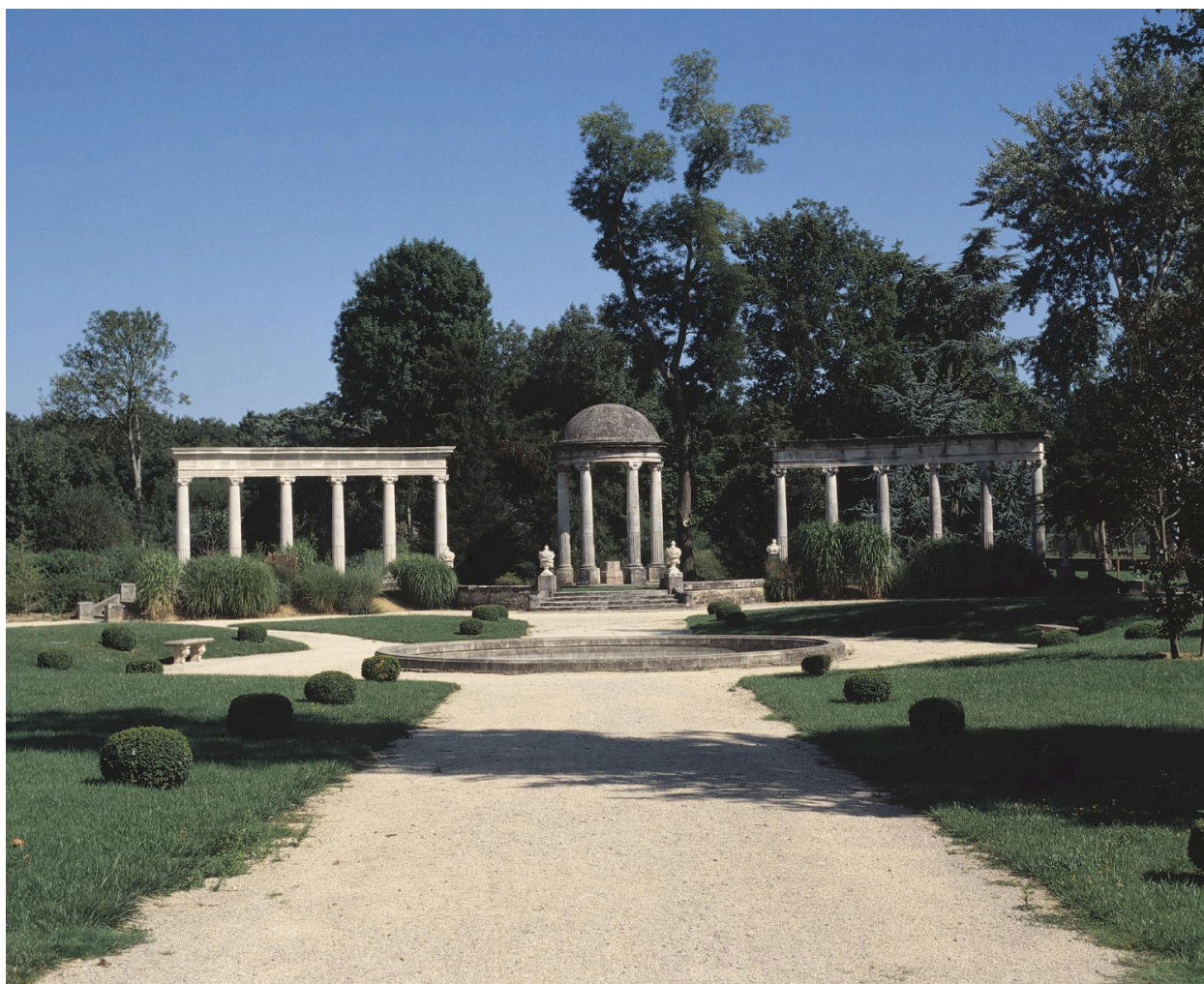
Vue perspective vers l'exèdre après sa restauration.
