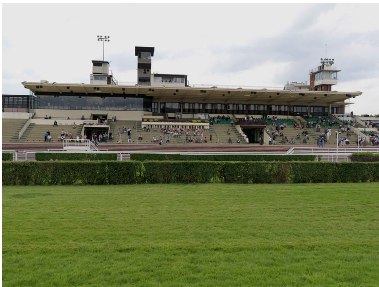
Vue d'ensemble de la tribune du pesage, vers les gradins.
