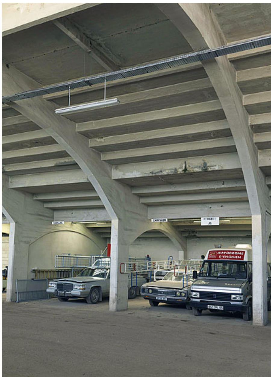
Vue de la nef sous la tribune de la pelouse vers les gradins.
