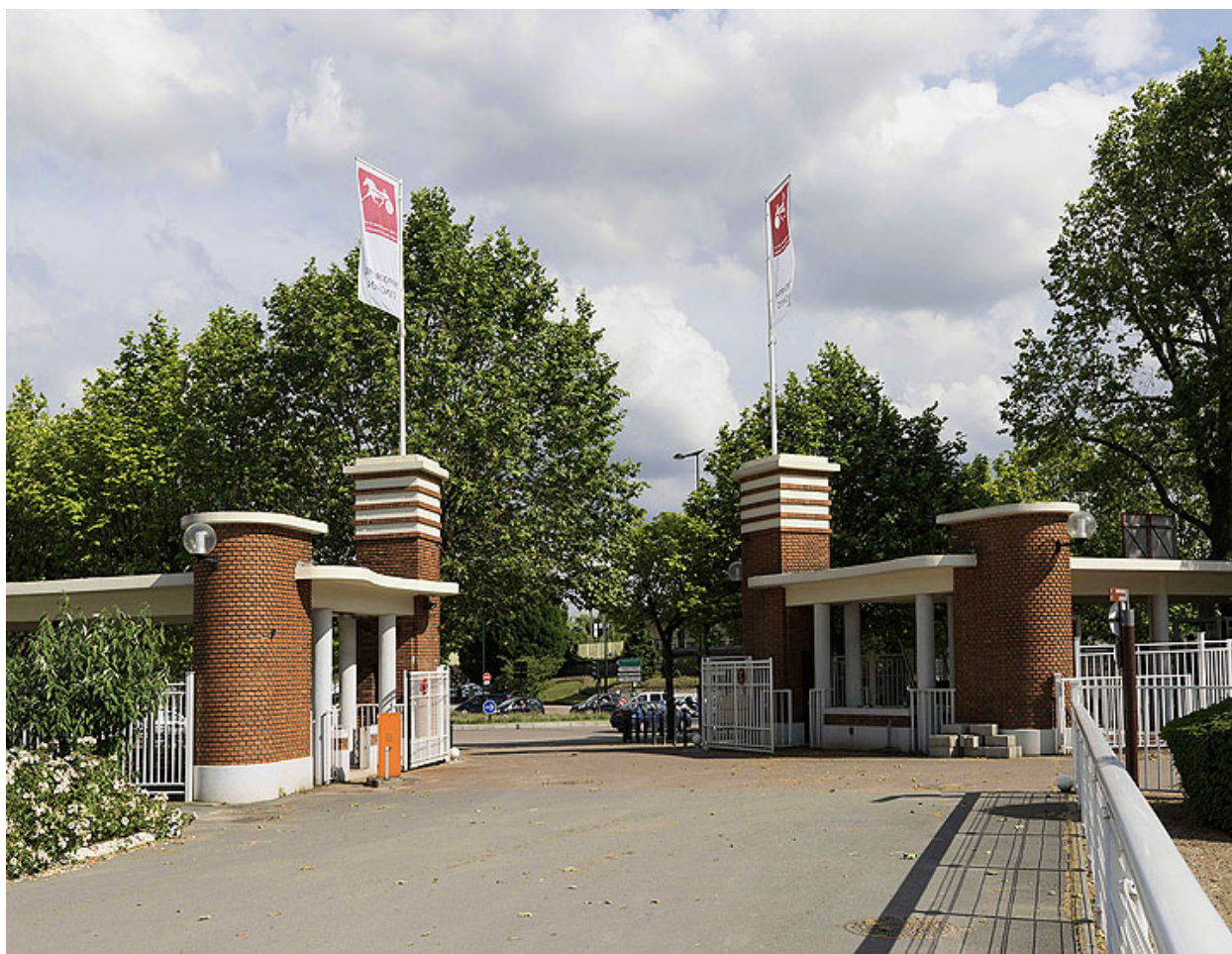
Vue des pavillons d'entrée du champ de course, depuis l'intérieur du domaine. Vue orientée vers le guichet droit.
