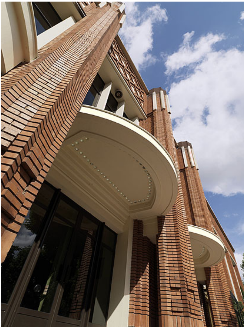
Tribune du pesage : détail de l'auvent de béton ajouré de pastilles de verre, marquant une entrée de la tribune du côté jardin.
