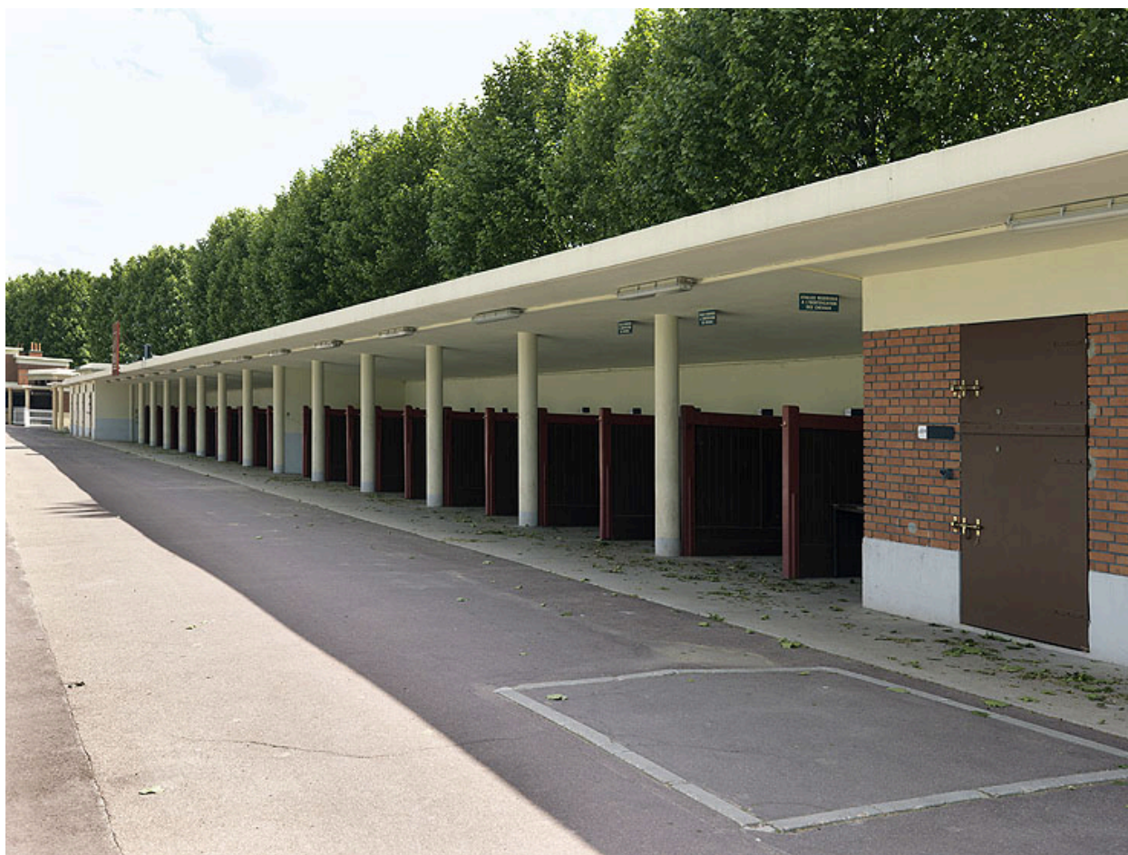
Vue d'ensemble d'une série de boxes.
