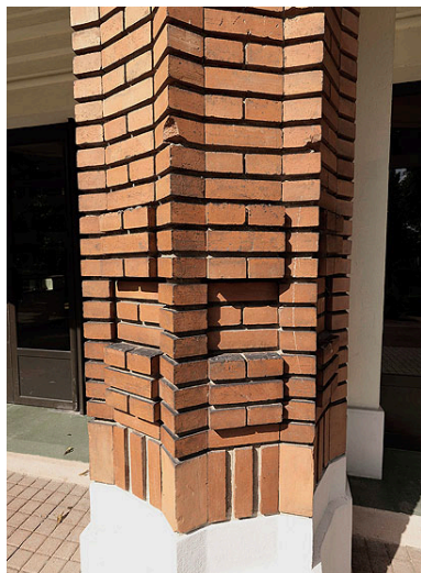
Détail de la mise en oeuvre des briques sur la façade de la tribune du pesage, côté jardin. Phot. Jean-Bernard Vialles IVR11_20089500218NUC4A
