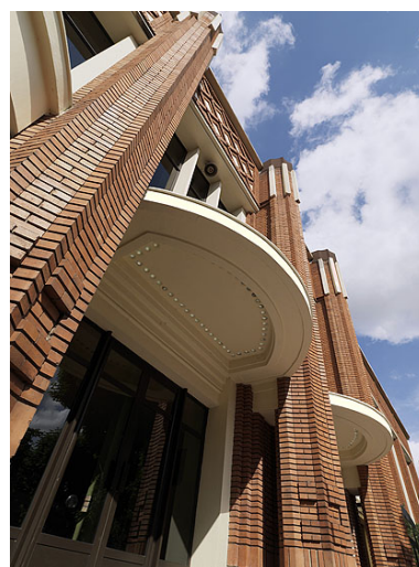
Tribune du pesage : détail de l'auvent de béton ajouré de pastilles de verre, marquant une entrée de la tribune du côté jardin. Phot. Jean-Bernard Vialles IVR11_20089500217NUC4A
