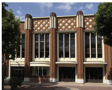
Tribune du pesage : détail des trois travées donnant sur le jardin. Phot. Jean-Bernard Vialles IVR11_20089500216NUC4A
