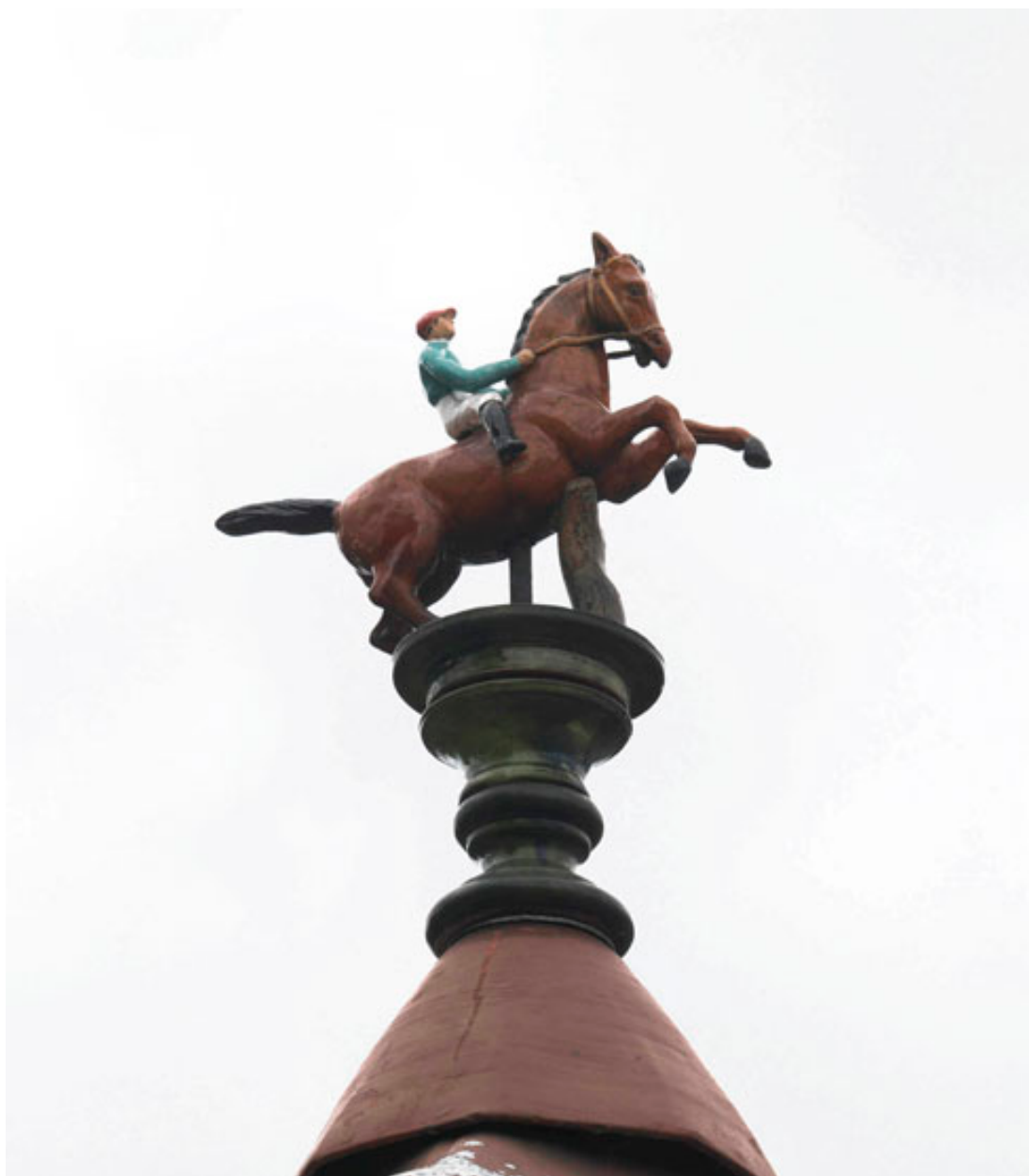
Vue de l'épi de faîtage couronnant le pavillon néo-normand : jockey sur son cheval, profil droit.
