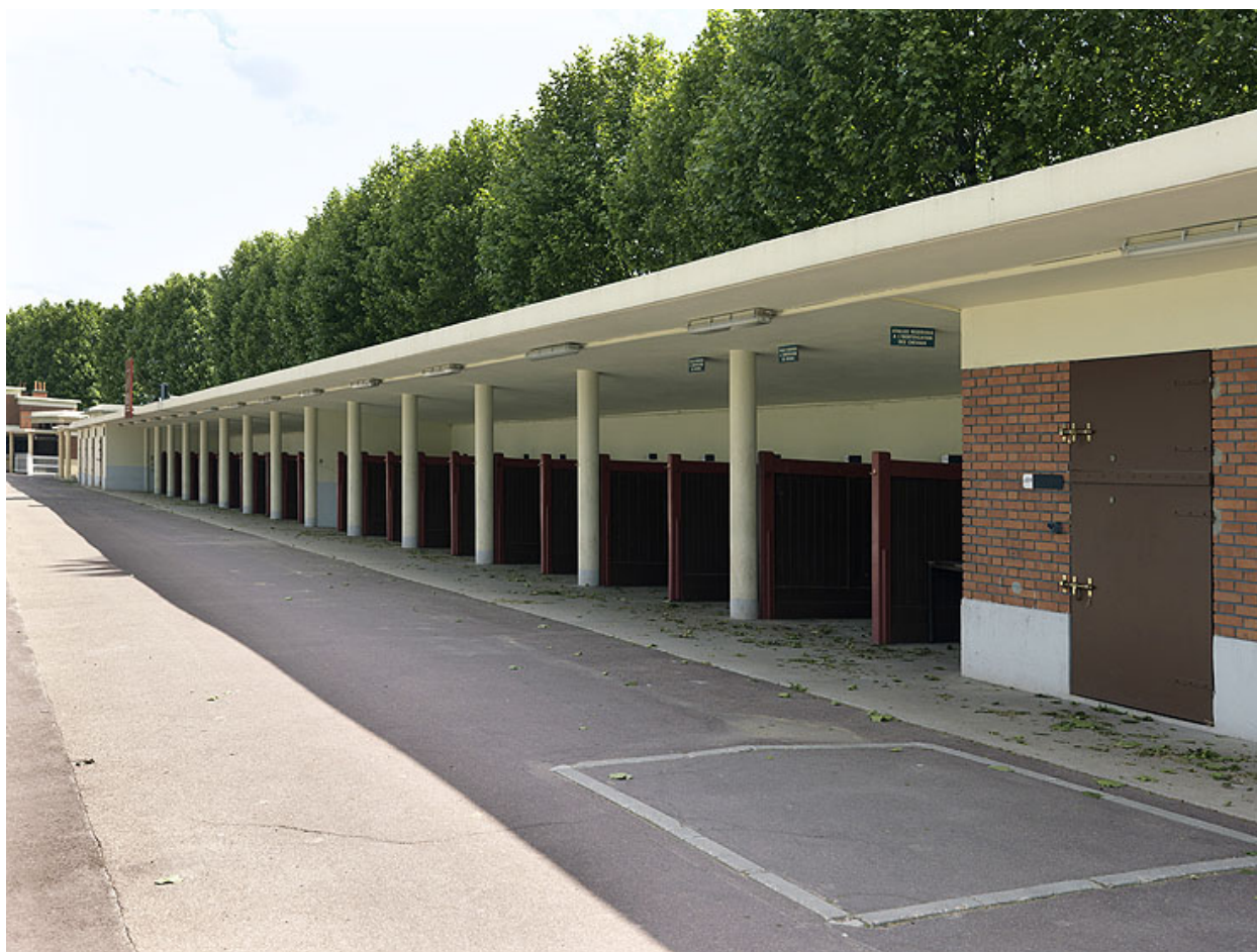
Vue d'ensemble d'une série de boxes.
