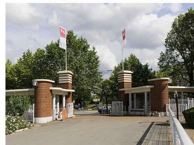
Vue des pavillons d'entrée du champ de course, depuis l'intérieur du domaine. Vue orientée vers le guichet droit. Phot. Jean-Bernard Vialles IVR11_20089500220NUC4A
