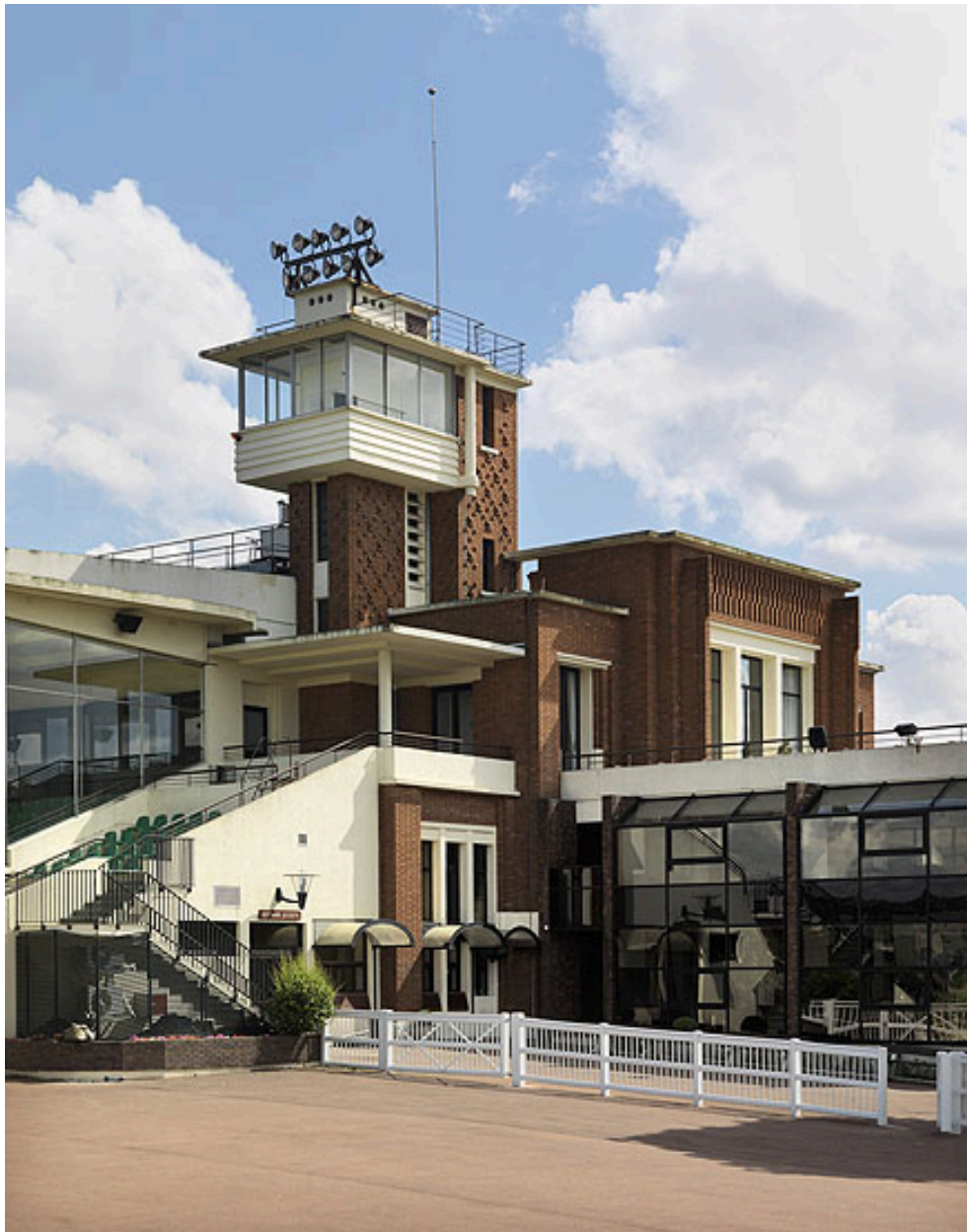
Tribune du pesage : façade latérale vers l'entrée de la salle du pesage. A gauche, les gradins donnant sur le champ de course.
