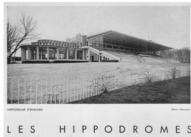
Vue d'ensemble de la tribune du pesage depuis les pistes. Photographie, vers 1934. Tiré de : L'Architecture d'aujourd'hui, n°3, avril 1934. Autr. Chevojon (photographe) IVR11_19909500001XB
