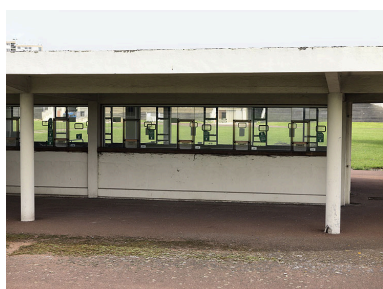
Détail des guichets au centre du champ de course. Phot. Jean-Bernard Vialles IVR11_20089500209NUC4A
