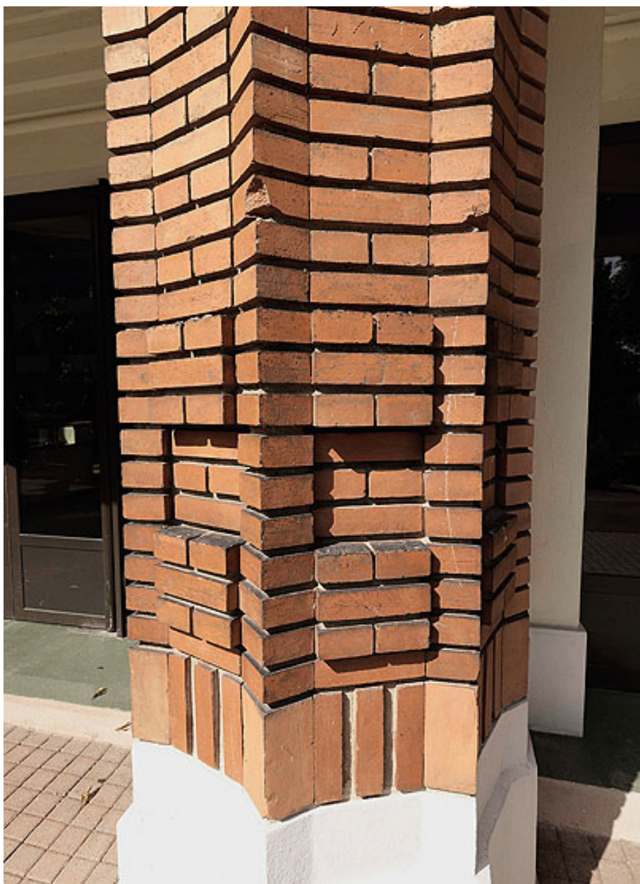
Détail de la mise en oeuvre des briques sur la façade de la tribune du pesage, côté jardin.
