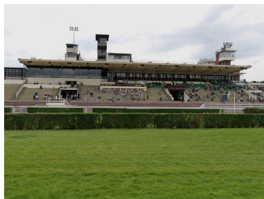
Vue d'ensemble de la tribune du pesage, vers les gradins. Phot. Jean-Bernard Vialles IVR11_20099500662NUC4A
