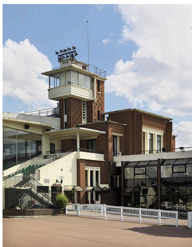
Tribune du pesage : façade latérale vers l'entrée de la salle du pesage. A gauche, les gradins donnant sur le champ de course. Phot. Jean-Bernard Vialles IVR11_20089500213NUC4A
