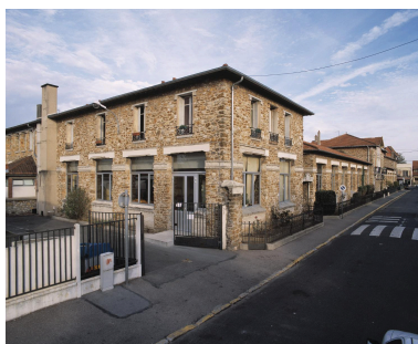
Vue des bâtiments sur la rue Roland-Lambert. Phot. Philippe Ayrault IVR11_20029101647XA
