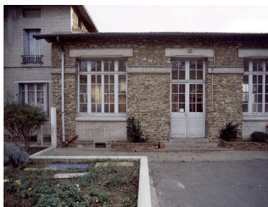
Vue, côté cour, d'une salle de classe en rez-de-chaussée accolée au logement des instituteurs. Phot. Philippe Ayrault IVR11_20029101658XA
