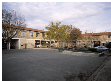
Vue de la cour de récréation. Phot. Philippe Ayrault IVR11_20029101655XA
