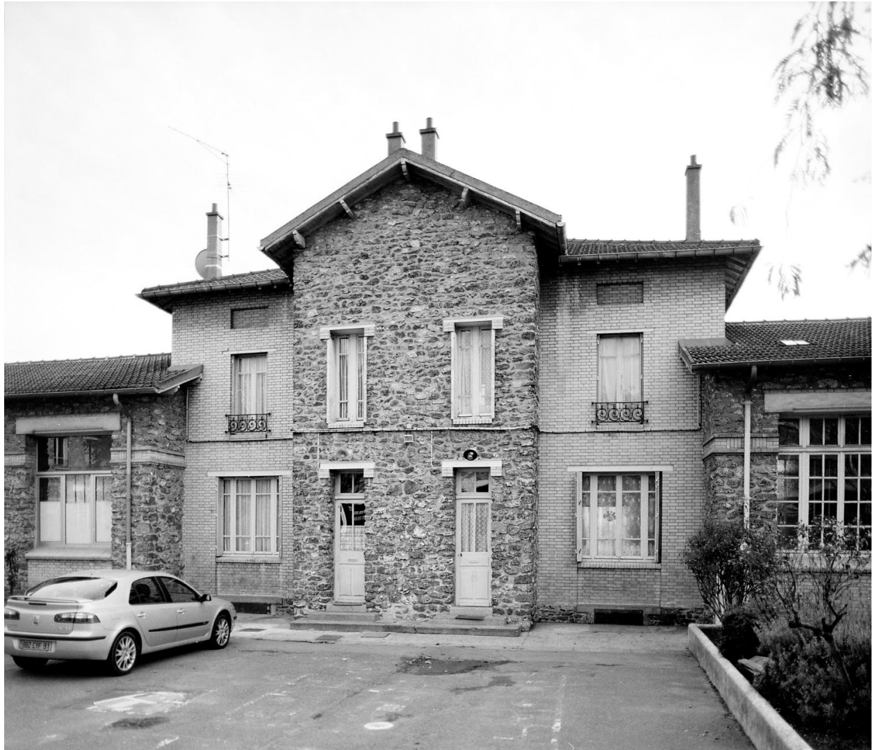
Vue côté cour du logement des instituteurs.
