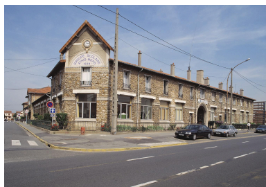
Vue d'ensemble du bâtiment, à l'angle de l'avenue François-Mitterrand et de la rue Roland-Lambert. Phot. Philippe Ayrault IVR11_20039101108XA
