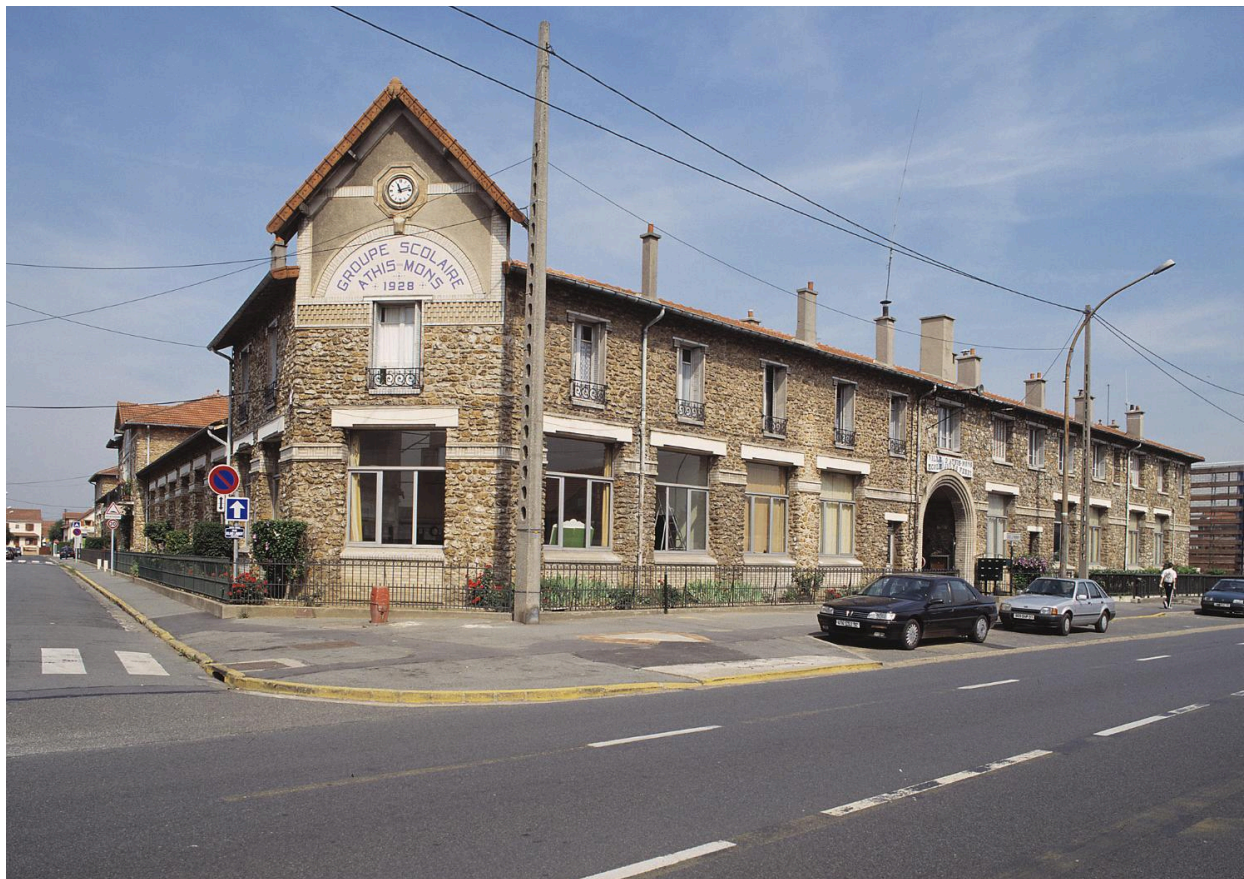
Vue d'ensemble du bâtiment, à l'angle de l'avenue François-Mitterrand et de la rue Roland-Lambert.
