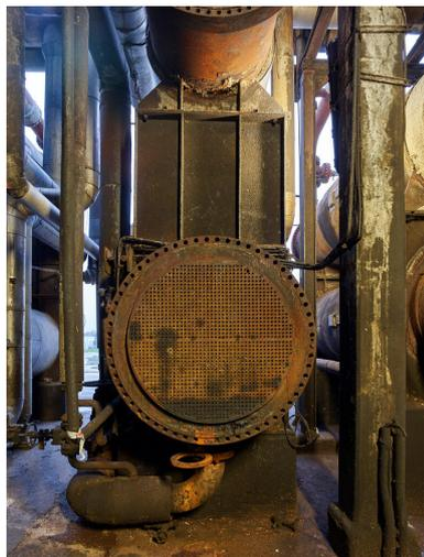
Unités Ouest - Zone de distillation (Unité 612). Echangeur tubulaire avec son faisceau central.
