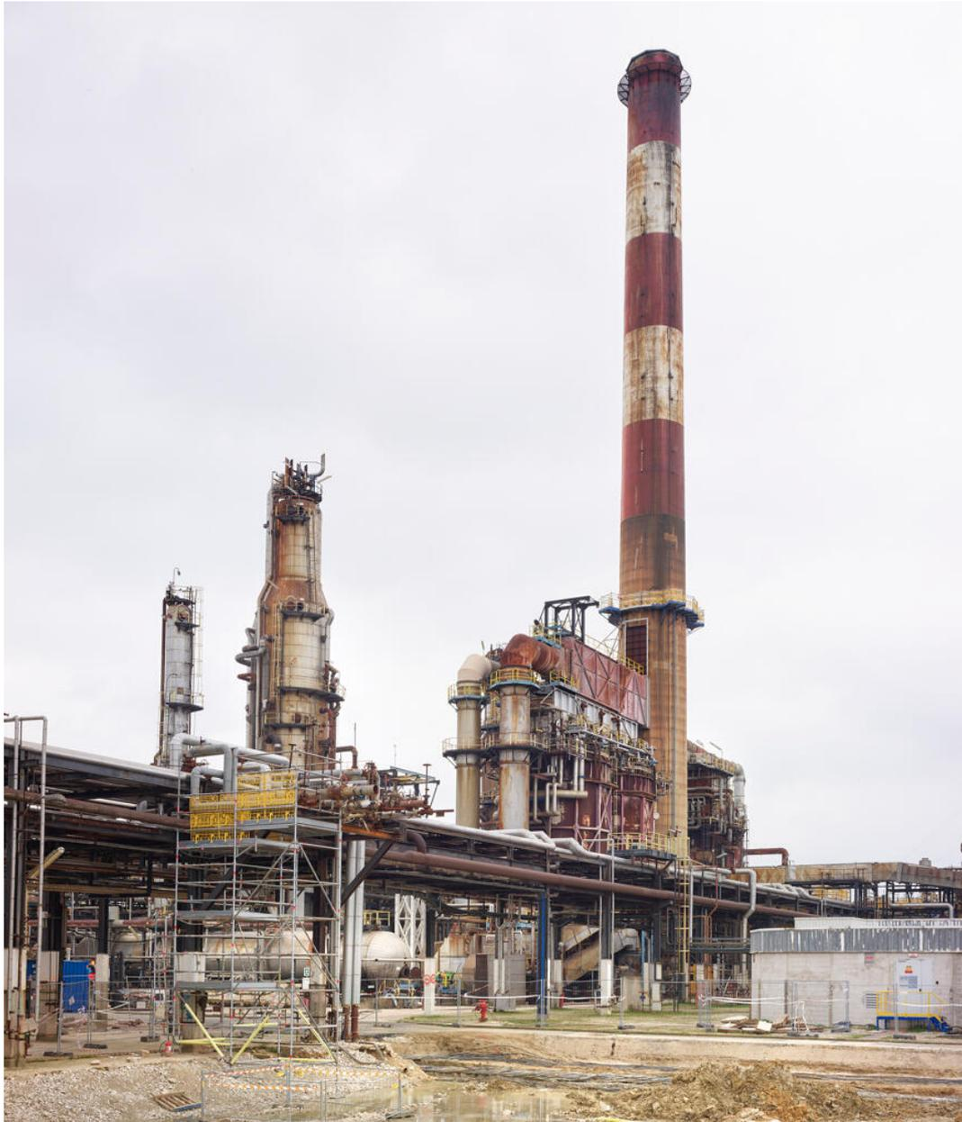
Unités Ouest. En arrière plan, l'unité 612 de distillation atmosphérique/sous-vide. Au premier plan, les travaux de terrassement pour le projet Biojet.
