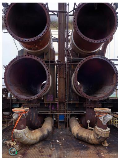
Unités Ouest - Zone de distillation (Unité 612). Echangeurs à faisceaux tubulaires 612 E2 à la sortie de la tête de colonne 612 C1. Ils permettaient un échange de calories entre l'essence très chaude sortant tout juste de la colonne et le pétrole qui devait se faire réchauffer juste avant d'être injecté dans le four. Après cette opération, l'essence ayant subi son premier refroidissement poursuivra son traitement. Les structures internes ont été démontées en prévision d'un démantèlement.
