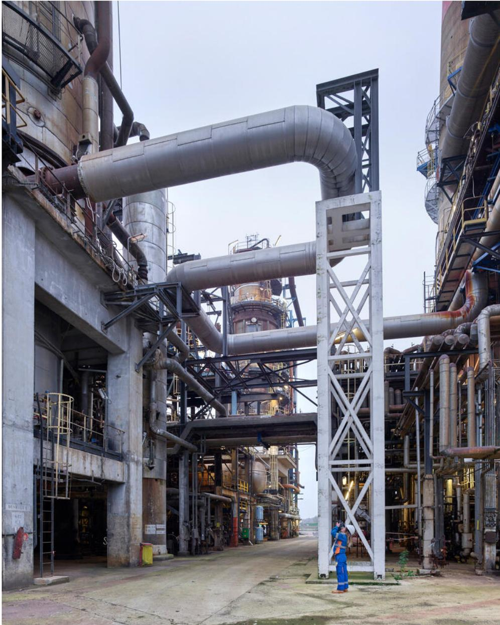
Unités Ouest - Zone de distillation (Unité 612). Ligne de transfert ("en S") calorifugée, vue depuis le four 612 F1 (à droite) vers la colonne 612 C1 (à gauche).
