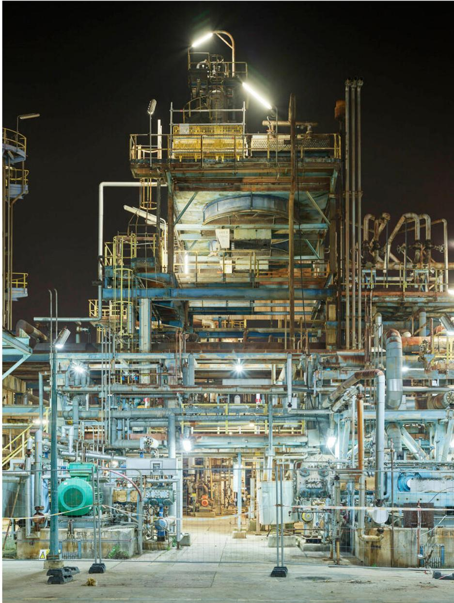
Au cœur des Unités Ouest, face à une partie de l'Unité 662. Aéroréfrigérants 662 EM 30002, dont le principe est de refroidir les produits avant de les renvoyer dans le système, par circulation d'air.
