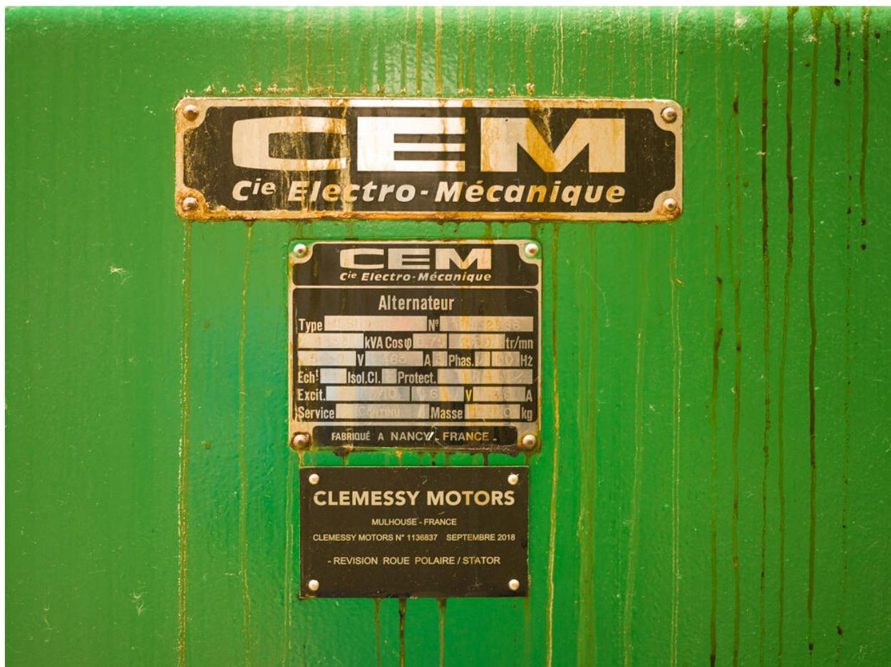
Unités Ouest - Utilités (Unité 430). Groupe turbo-alternateur. Plaque signalétique de l'alternateur CEM. L'alternateur produisait suffisamment d'énergie pour couvrir les moteurs prioritaires en cas d'arrêt inopiné (le site étant alimenté par le réseau RTE).
