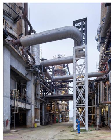
Unités Ouest - Zone de distillation (Unité 612). Ligne de transfert ("en S") calorifugée, vue depuis le four 612 F1 (à droite) vers la colonne 612 C1 (à gauche).
