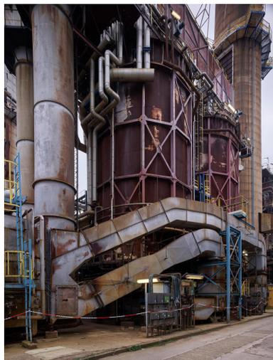
Unités Ouest - Zone de distillation (Unité 612). Fours 612 F1 A et B. Les deux gaines horizontales au premier plan sont destinées à l'alimentation en air des fours, fourni par un compresseur haut débit - basse pression. À gauche, les conduits de fumées.
