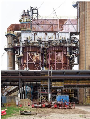
Unités Ouest. Au premier plan, le rack 600 qui traversait les Unités Ouest. Au fond, les deux cellules du four de la colonne de distillation atmosphérique 612 C1.
