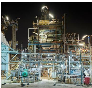
Au c#ur des Unités Ouest, face à une partie de l'Unité 662. Aéroréfrigérants 662 EM 30002, dont le principe est de refroidir les produits avant de les renvoyer dans le système, par circulation d'air.
