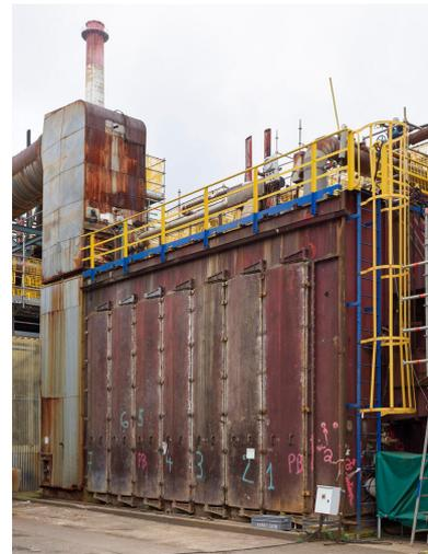
Unités Ouest. Unité 430, vue sur la "grosse" chaudière 430 F4. Les portes servent à la maintenance de la chaudière. La F4 produisait plus de 30 tonnes de vapeur par heure à une pression d'environ 19 Bars.
