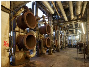
Unités Ouest - Zone de distillation (Unité 612). Trains d'échange, où circulaient des produits semi-finis chauds sortant des colonnes, pour réchauffer le pétrole avant de l'injecter dans le dessaleur et dans le four.
