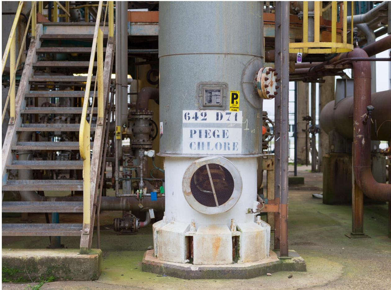
Unités Ouest. Ballon 642 D71 appelé "Piège à chlore". Comme son nom l'indique, cet équipement servait à piéger le chlore contenu dans de l'hydrogène avant d'aller alimenter d'autres unités sur les secteurs Ouest et Est.
