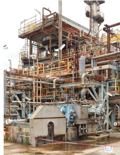
Unités Ouest. Au premier plan, le compresseur d'hydrogène de recyclage de l'unité HDT2, le 642 KM 402 A. En arrière plan, les aéroréfrigérants EM 3002 de l'unité 662 et la colonne 662 C3001 de lavage aux amines haute pression. Les parties démontables du compresseur ont été retirées pour une mise en conservation, dans le but d'être réutilisées pour le projet Biojet.
