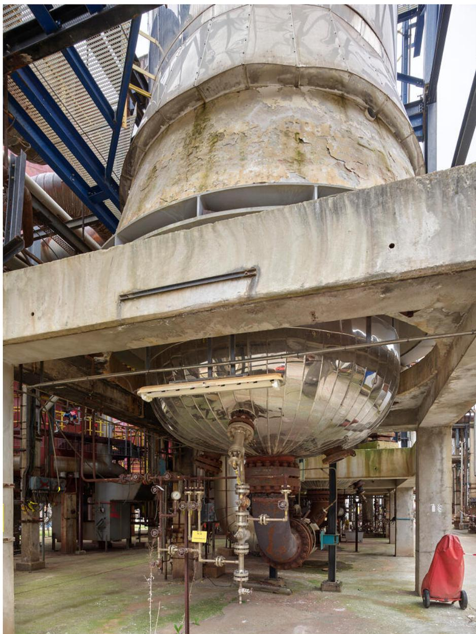
Unités Ouest - Reformeur catalytique (Unité 642). Fond du réacteur 642 D8 avec sa prise d'échantillon de catalyseur. Ce catalyseur permettait la réaction chimique qui génèrait de l'essence à haut indice d'octane. Echantillonner le catalyseur permettait de savoir à quel moment il fallait le régénérer ou le remplacer.
