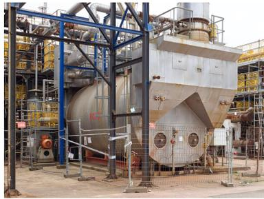
Unités Ouest. Unité 430. Chaudière 430 F3, la plus récente. Technologie différente des chaudières F1 et F2 : la F3 était une chaudière à brûleurs immergés et pouvait être démarrée à distance. Les F1 et F2 étaient des chaudières à tubes et nécessitaient l'intervention d'un opérateur pour le démarrage.
