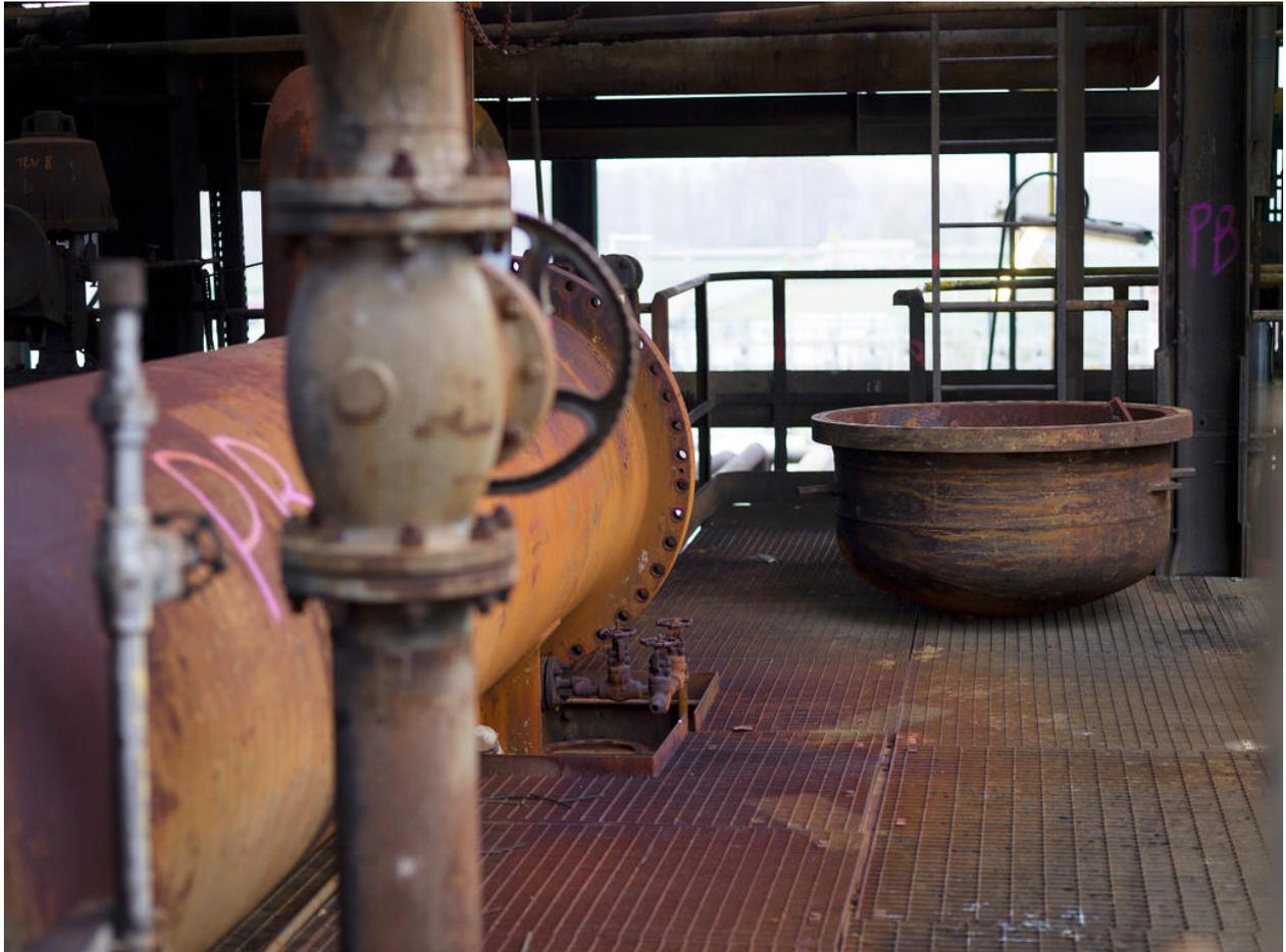
Unités Ouest - Zone de distillation (Unité 612). Echangeur à faisceaux tubulaires 612 E13 à gauche, et son bonnet amovible déposé au sol.
