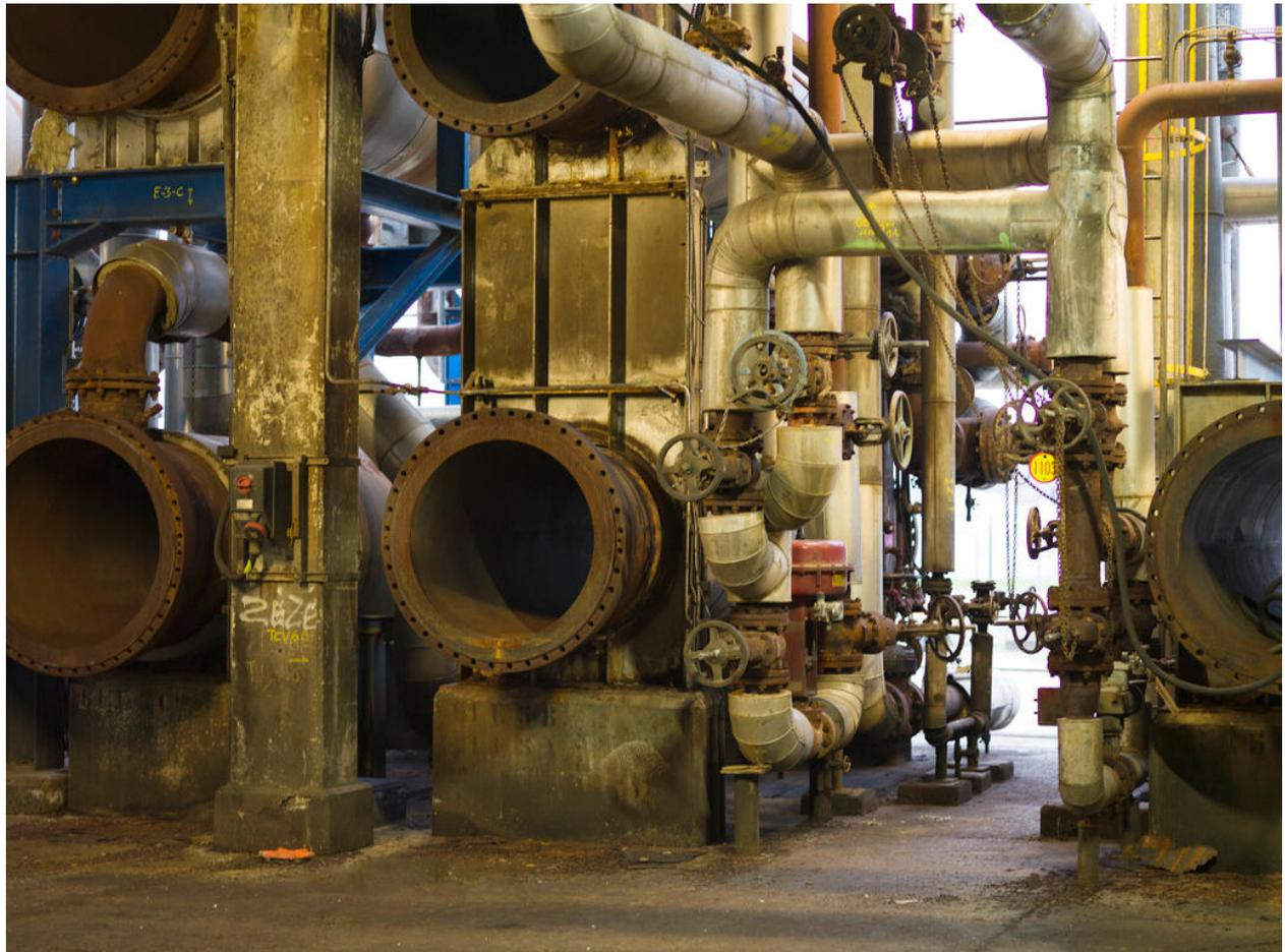
Unités Ouest - Zone de distillation (Unité 612). Trains d'échange, où circulaient des produits semi-finis chauds sortant des colonnes, pour réchauffer le pétrole avant de l'injecter dans le dessaleur et le four F1.
