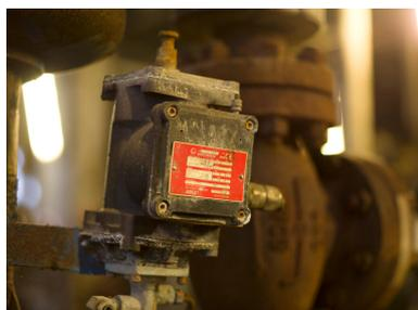
Unités Ouest - Zone de distillation (Unité 612). "S.O.V", système pneumatique d'ouverture ou de fermeture de vannes de sécurité.
