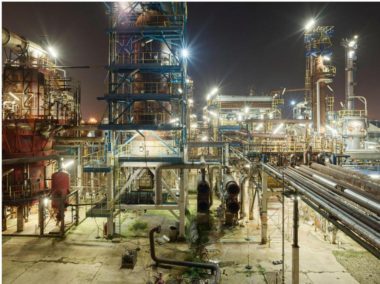
Unités Ouest - Hydrodésulfuration des gasoils "HDS" - HDS 2 (Unité 662). Vue générale de l'Unité 662, depuis l'ouest. On distingue le four à gauche (préchauffage du gasoil à traiter), et à sa suite le réacteur chimique 662 D1001 au centre. Ces deux équipements seront conservés dans le cadre du projet Biojet.
