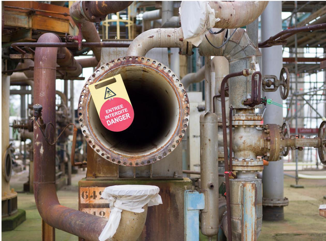
Unités Ouest - 642 E60. Vue sur la calandre de l'échangeur tubulaire servant à refroidir de l'essence riche en hydrogène (le fluide réfrigérant utilisé est l'eau).
