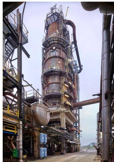
Unités Ouest - Zone de distillation (Unité 612). Colonne 612 C7 de distillation sous vide. Sur la gauche, le ballon 612 D2 est relié à la tête de la colonne 612 C1 et permet de récupérer l'essence fraîchement distillée.
