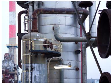
Unités Ouest - Zone de distillation (Unité 612). Colonne 612 C1 avec ses tuyaux de sous-tirage d'un gasoil.
