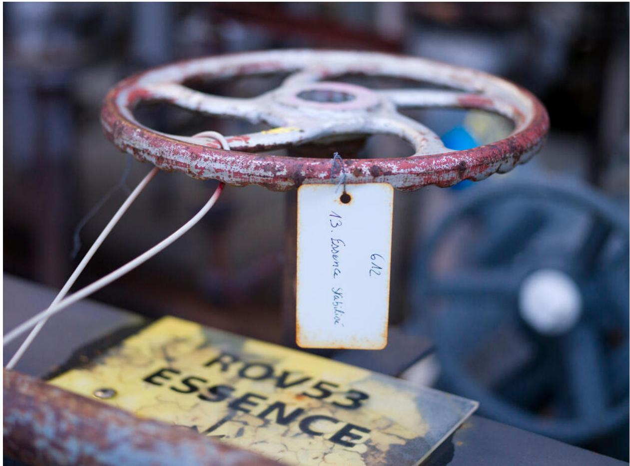
Unités Ouest - Zone de distillation (Unité 612). Rack limite des Unités Ouest. Rallonge de la vanne du circuit d'essence vers le stockage. L'étiquette a été déposée au moment de l'arrêt de l'exploitation afin de repérer les circuits à sécuriser.
