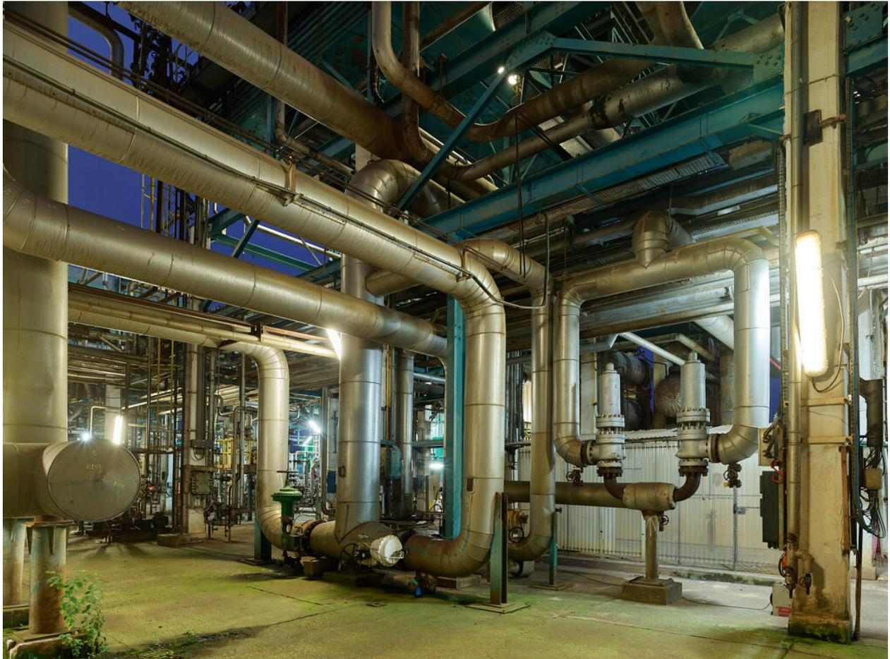
Unités Ouest - Reformeur catalytique (Unité 642). Vue sur la sortie des réacteurs. Au centre, les deux sorties des réacteurs chimiques de l'Unité. Sur la droite, les deux soupapes de sécurité de ces sorties.
