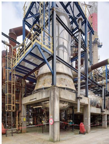
Unités Ouest - Reformeur catalytique (Unité 642). Réacteurs 642 D8 (au premier plan) pour la production d'essence à haut indice d'octane. Réacteurs D6 et D7 en arrière plan.
