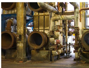
Unités Ouest - Zone de distillation (Unité 612). Trains d'échange, où circulaient des produits semi-finis chauds sortant des colonnes, pour réchauffer le pétrole avant de l'injecter dans le dessaleur et le four F1.
