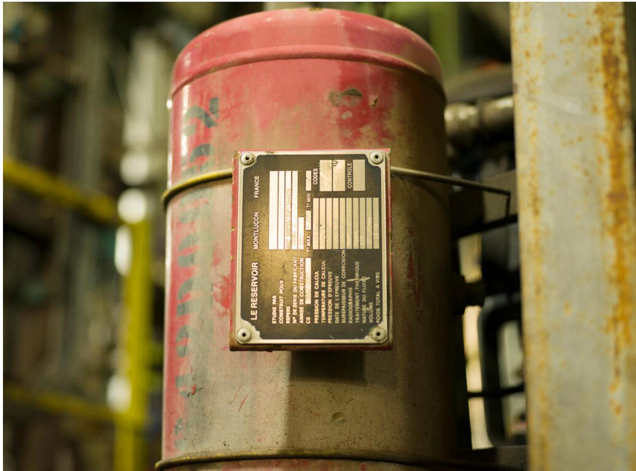
Unités Ouest - Reformeur catalytique (Unité 642). Bouteilles d'air comprimé permettant l'ouverture des vannes de sécurité.
