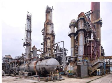
Unités Ouest - Zone de distillation (Unité 612). Au premier plan, équipement horizontal de dessalage 612 D1 (le "dessaleur" permettant d'extraire l'eau et les sels minéraux qui accompagnent le pétrole brut). Au centre, la colonne de distillation atmosphérique 612 C1 (première distillation du pétrole). À gauche, la colonne 612 C5 (le "stabilisateur") dédié à la stabilisation de l'essence.
