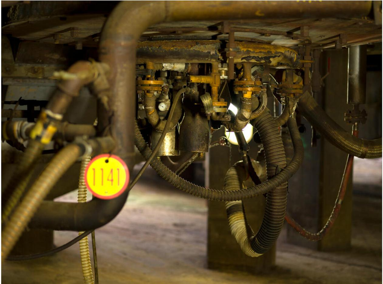
Unités Ouest - Zone de distillation (Unité 612). Brûleur du four 612 F1 A et B, couronne de combustible gaz d'un des six brûleurs.
