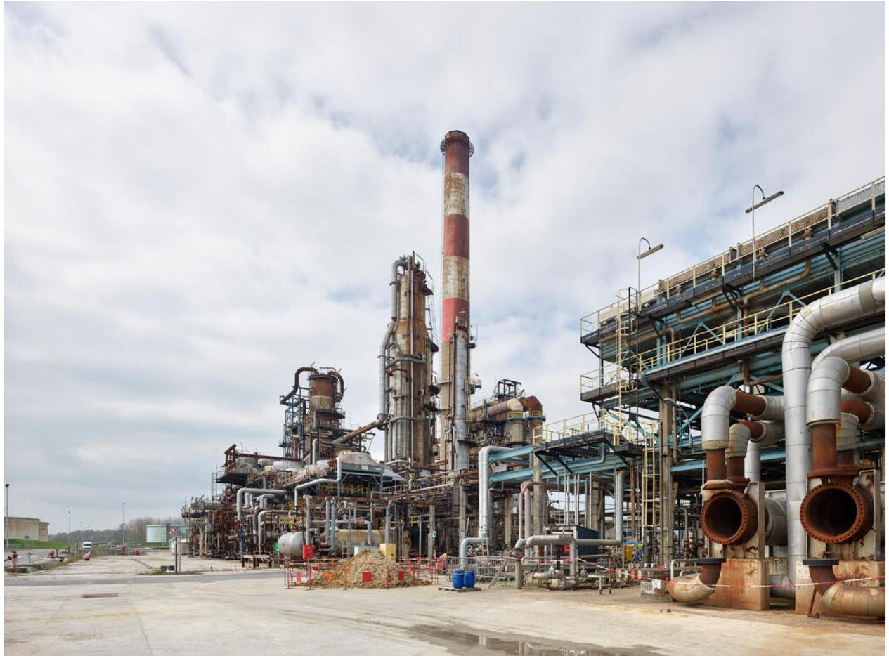
Unités Ouest. Au fond, vue de l'unité 612 de distillation atmosphérique/sous-vide depuis le côté sud-est. À droite de l'image, les échangeurs à faisceaux tubulaires de l'unité 642.
