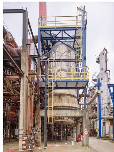
Unités Ouest - Reformeur catalytique (Unité 642). Au premier plan le réacteur 642 D8, à droite le stripper d'H<sub>2</sub>S 642 C1.
