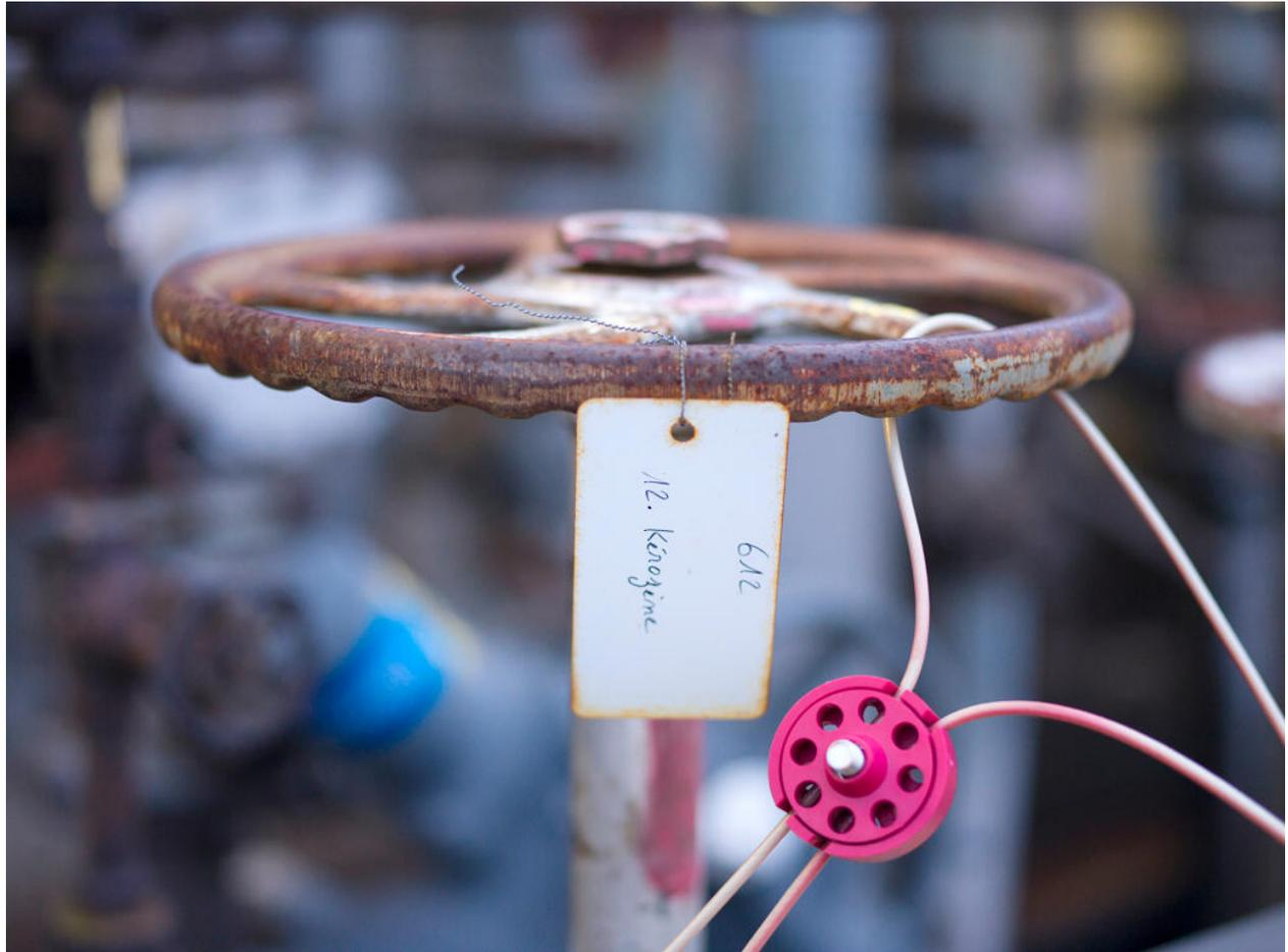
Unités Ouest - Zone de distillation (Unité 612). Rack limite des Unités Ouest. Rallonge de la vanne du circuit de kérosène vers le stockage. L'étiquette a été déposée au moment de l'arrêt de l'exploitation afin de repérer les circuits à sécuriser.
