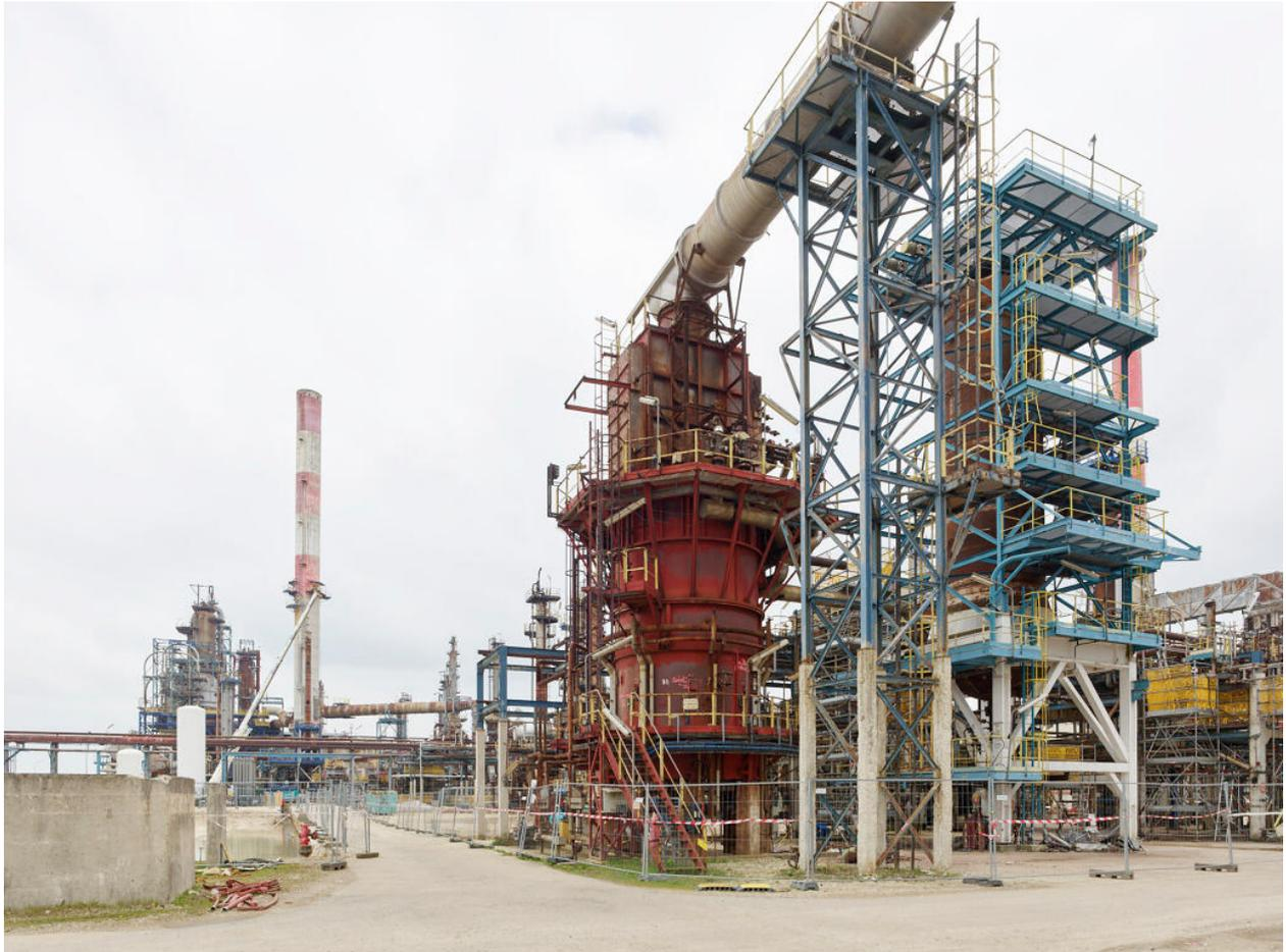
Unités Ouest. Four et réacteur des unités 662 F1001 et 662 D1001 d'hydrodésulfuration des gazoles. Au fond , les unités Est.
