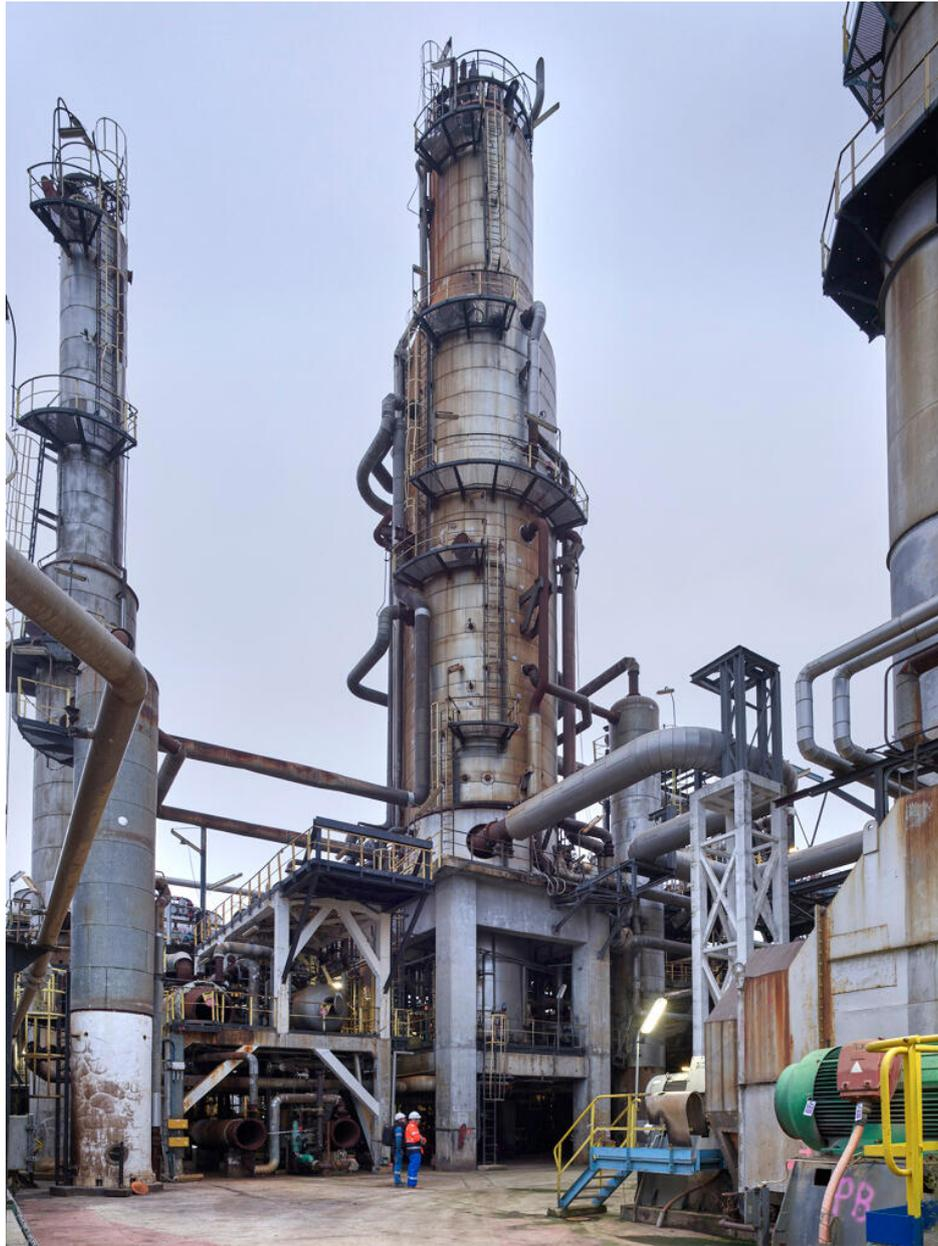
Unités Ouest - Zone de distillation (Unité 612). Colonne 612 C1. En bas de la colonne, sa ligne de transfert venant du four 612 F1. À gauche, la colonne de stabilisation des essences 612 C5.
