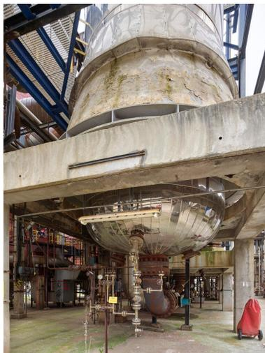
Unités Ouest - Reformeur catalytique (Unité 642). Fond du réacteur 642 D8 avec sa prise d'échantillon de catalyseur. Ce catalyseur permettait la réaction chimique qui générerait de l'essence à haut indice d'octane. Echantillonner le catalyseur permettait de savoir à quel moment il fallait le régénérer ou le remplacer.
