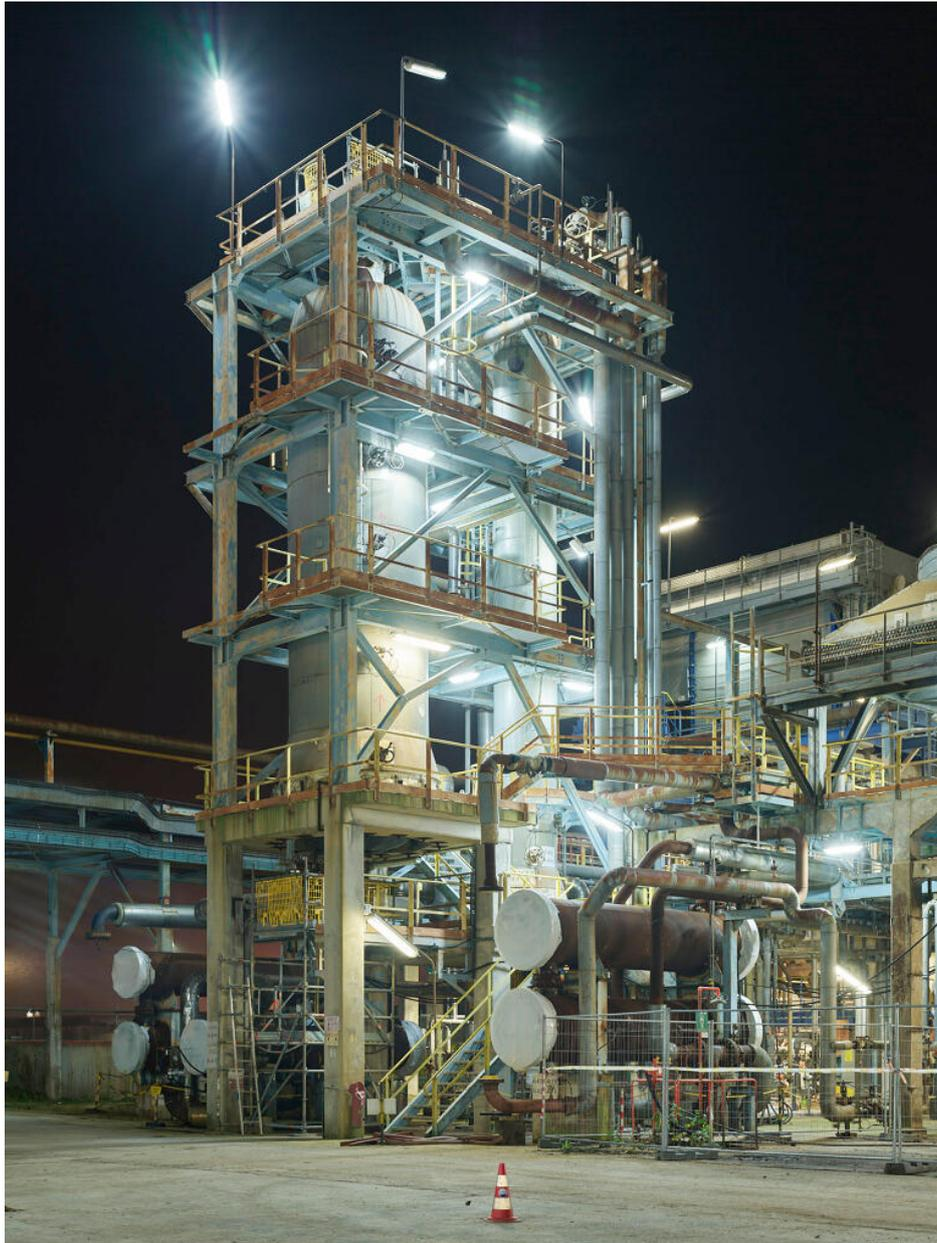
Unités Ouest - Reformeur catalytique (Unité 642). Deux réacteurs chimiques intégrés à l'Unité HDT2, destinés à l'épuration des produits (avant transformation) en provenance des Unités Est, pour retraitement sur l'Unité 642.
