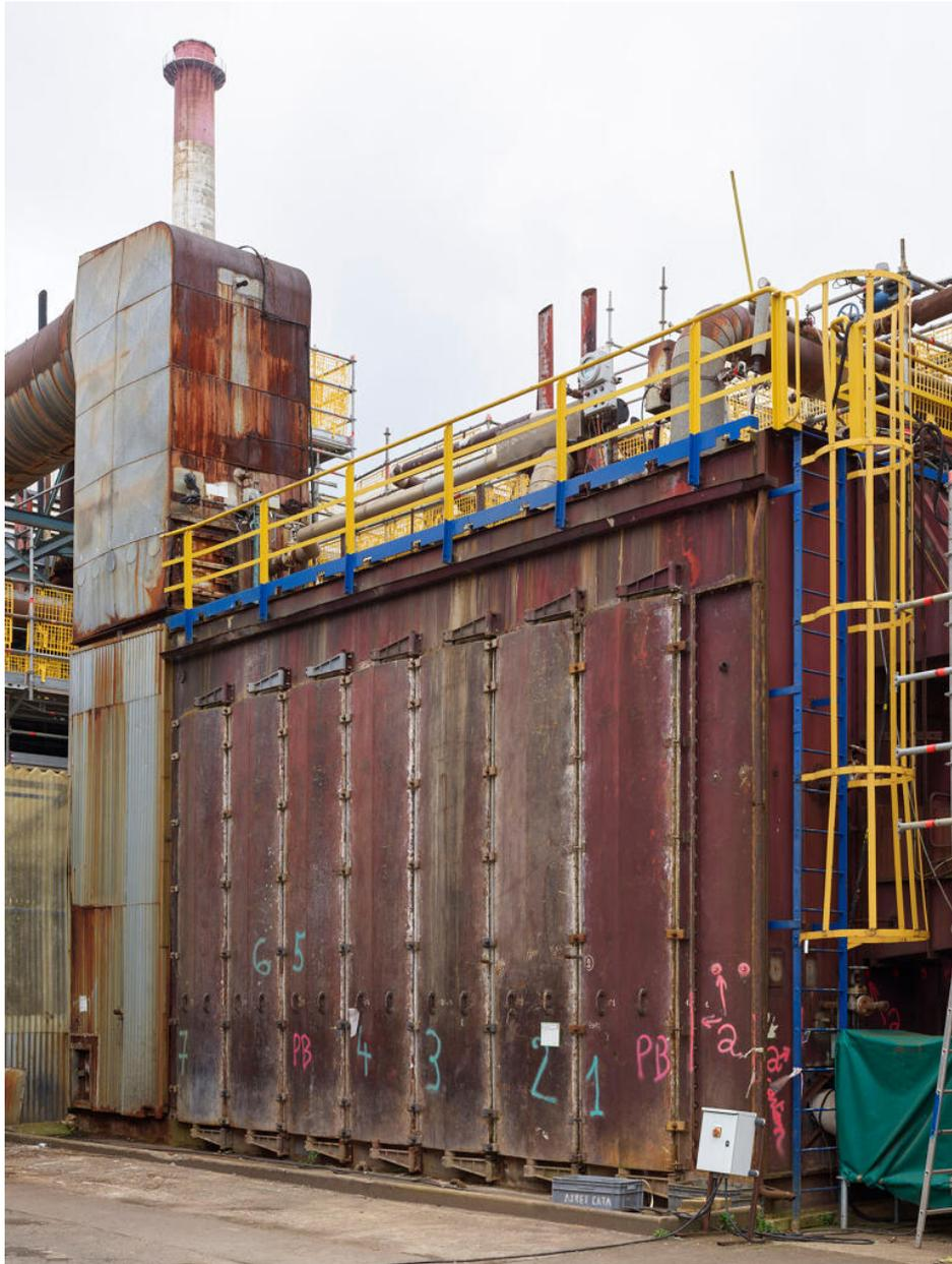
Unités Ouest. Unité 430, vue sur la "grosse" chaudière 430 F4. Les portes servent à la maintenance de la chaudière. La F4 produisait plus de 30 tonnes de vapeur par heure à une pression d'environ 19 Bars.
