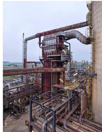
Unités Ouest - Zone de distillation (Unité 612). Four 612 F2, surmonté d'un surchauffeur destiné à élever la température de la vapeur pour ensuite l'injecter dans le procédé (afin de faciliter la distillation).
