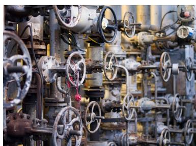
Unités Ouest - Zone de distillation (Unité 612). Rack limite des Unités Ouest. Jeu de vannes du rack (appelé la "cuisine") permettant l'orientation des produits vers différents circuits.
