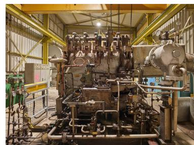
Unités Ouest - Utilités (Unité 430). Groupe turbo-alternateur. Dos de la turbine, avec son entrée de vapeur et la vanne de contrôle sur la droite.
