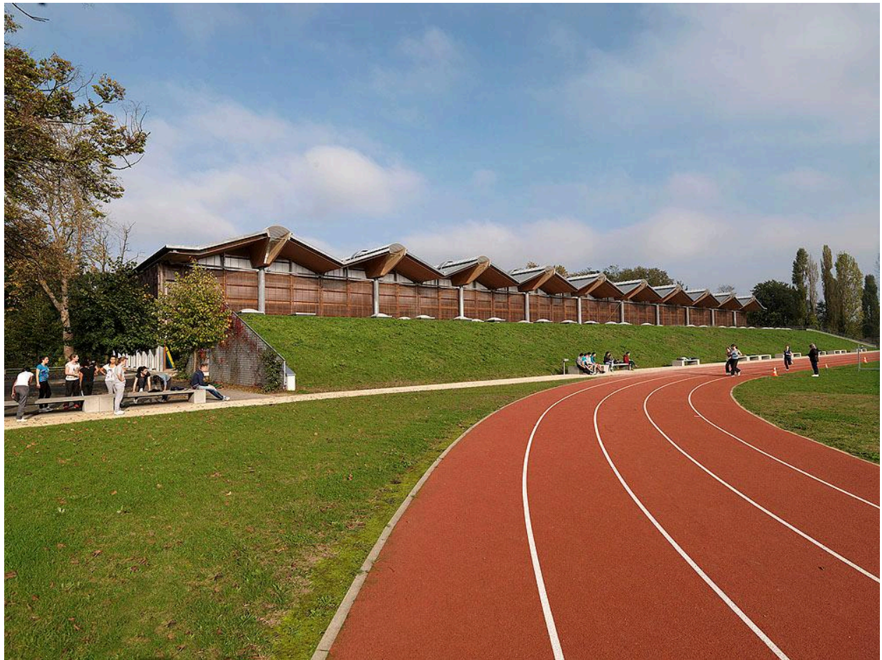
Vue générale sur le nouveau gymnase, avec ses façades en panneaux de méthacrylate translucide et sa toiture en zigzag.
