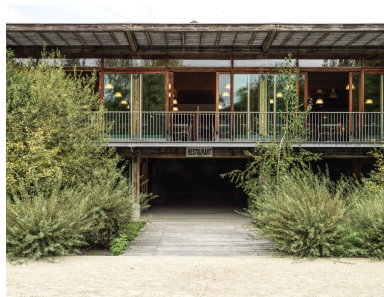
Vue générale du nouveau réfectoire en bois, bâti sur pilotis.
