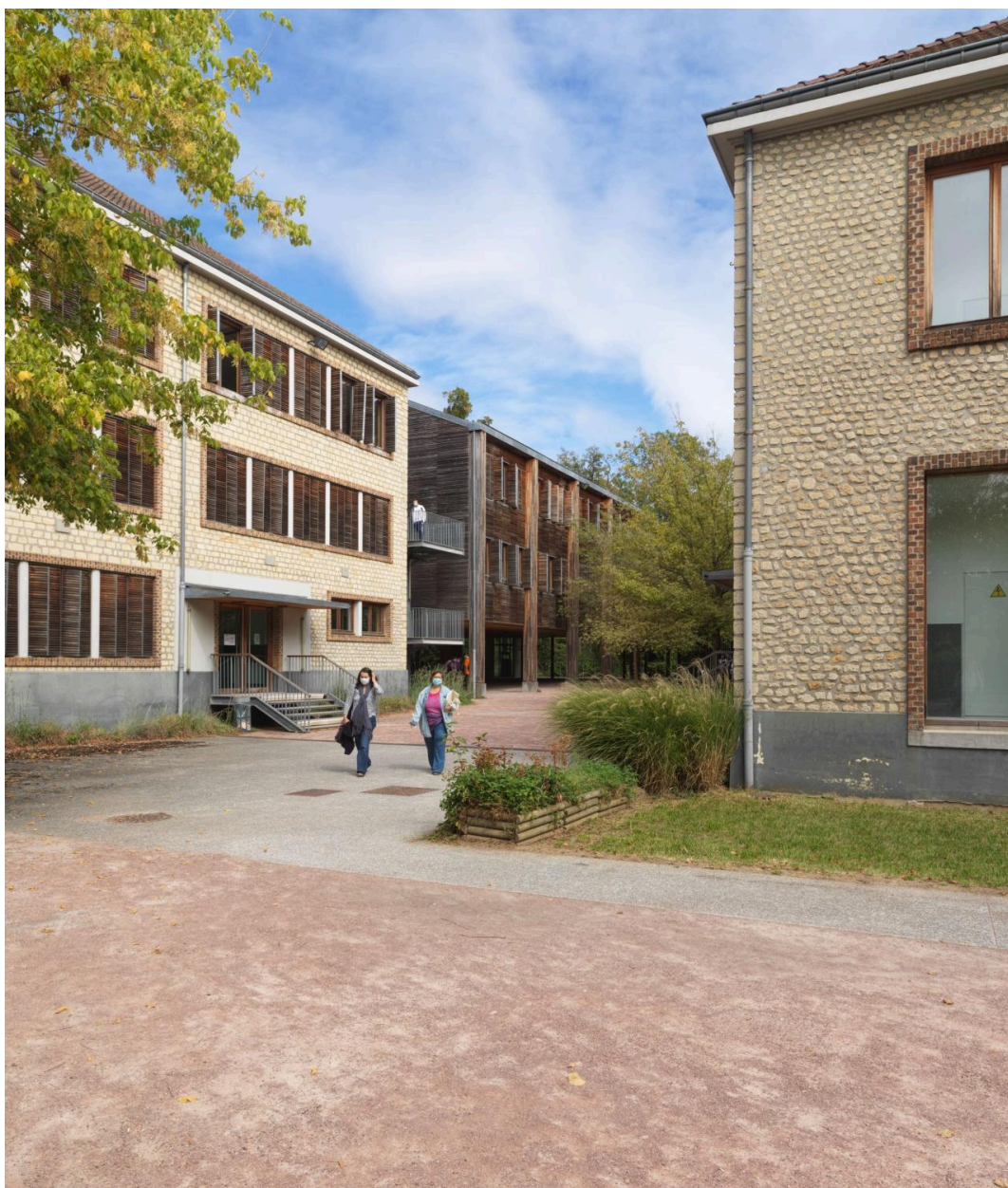
Les bâtiments d'enseignement restructurés et leurs prolongements en bois contemporains, sur pilotis.
