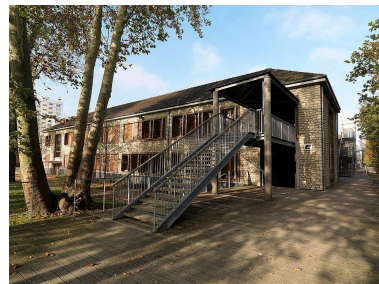
A l'ouest se trouvent les bâtiments d'enseignement des années 1950, qui ont été conservés : leurs élévations en briques et épais moellons de meulière ont été restaurées et dotées de baies et de persiennes répondant au souhait de protection solaire et de confort climatique.
