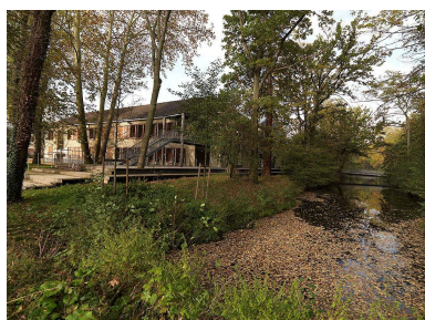
Vue générale des bâtiments d'enseignement des années 1950 restructurés, en bordure de l'Orge.
