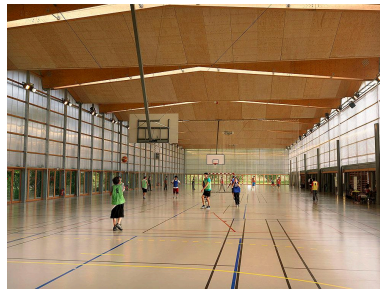
Vue intérieure du gymnase. Ses façades en panneaux de méthacrylate translucide, doublés d'une protection solaire sur les expositions sud, est et ouest, et sa toiture en zigzag, portée par des poteaux métalliques et des poutres en bois dédoublées, laissent la lumière pénétrer à flots dans l'édifice.
