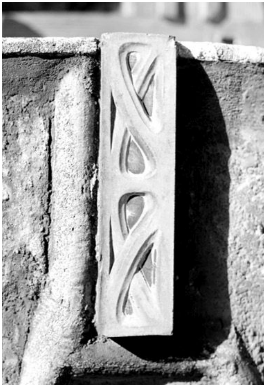
Détail d'une brique moulurée décorant les ouvertures du rez-de-chaussée.
