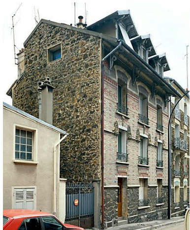
Façades antérieure et latérale. Phot. Christian Décamps IVR11_19869400281VA
