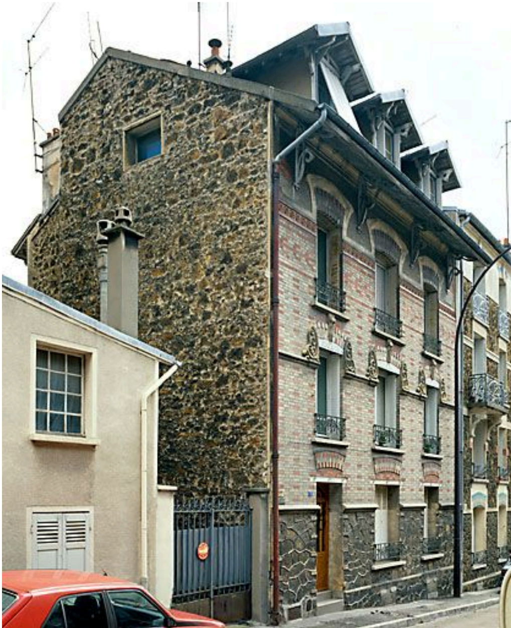
Façades antérieure et latérale.
