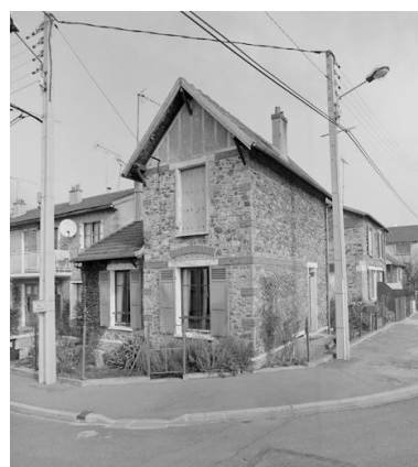
Vue d'ensemble d'une maison située à l'angle des rues d'Orléans (n° 2) et de la Prévoyance (n° 13), autrefois accolée à une autre maison identique. Phot. Philippe Ayrault IVR11_20029100279X
