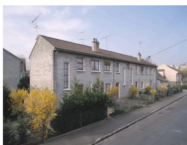
Vue d'ensemble de l'immeuble collectif reconstruit par la société au 1-7, rue d'Orléans, après la destruction de plusieurs de ses pavillons par le bombardement d'avril 1944 ; il fait face à un immeuble identique portant les numéros 4-14 ; un 3e immeuble a été construit au 7-11, rue de la Prévoyance. Phot. Philippe Ayrault IVR11_20029100282XA
