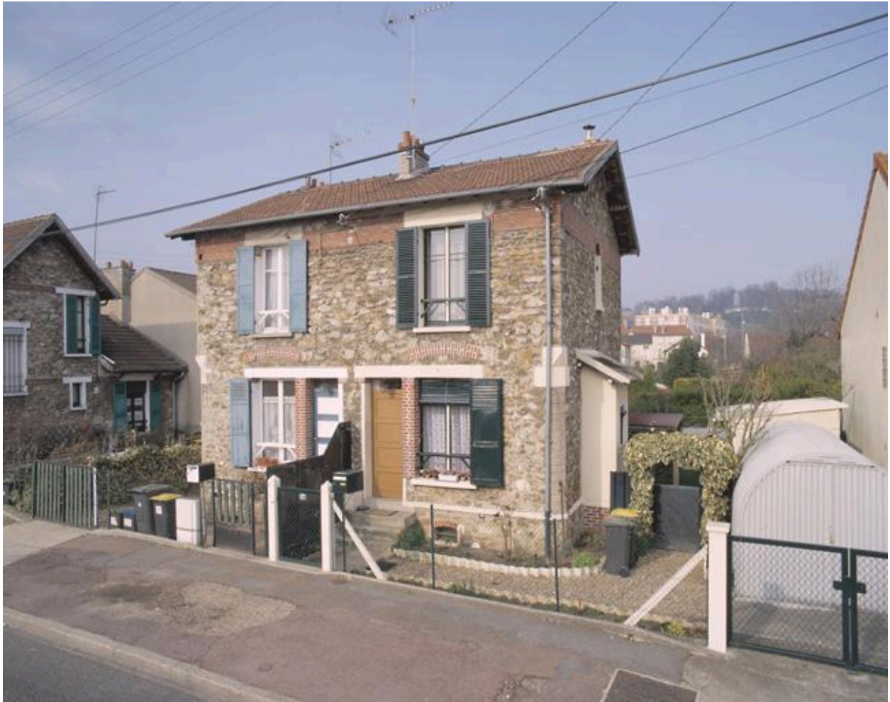
Vue d'ensemble d'une maison jumelle, 15 et 17 rue de la Prévoyance.
