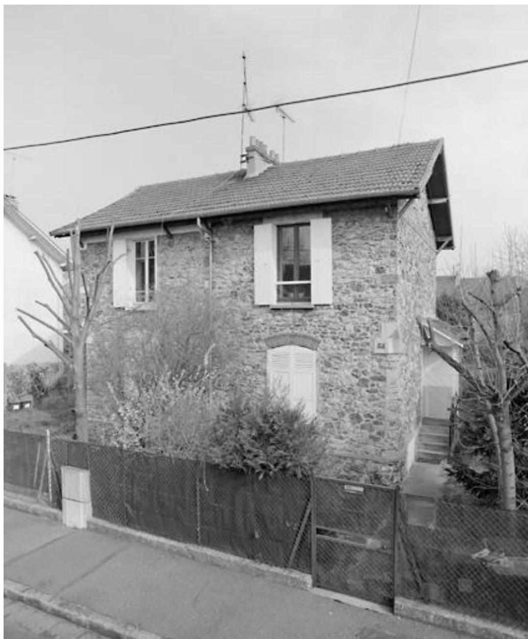
Vue d'ensemble de la maison jumelle, 16 et 18 rue d'Orléans.
