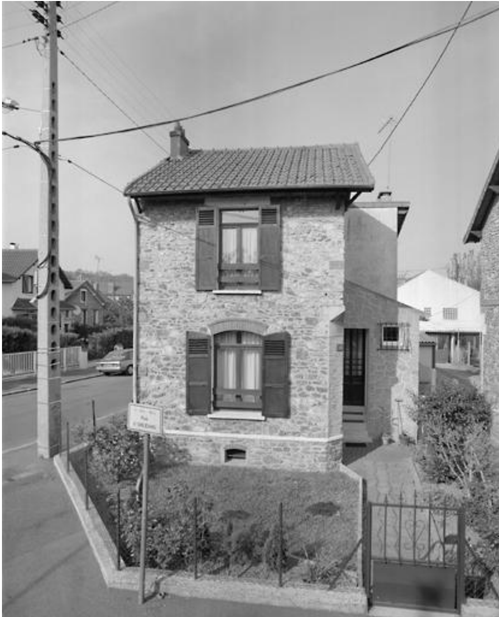
Vue d'ensemble de la maison située au 28 rue d'Orléans.
