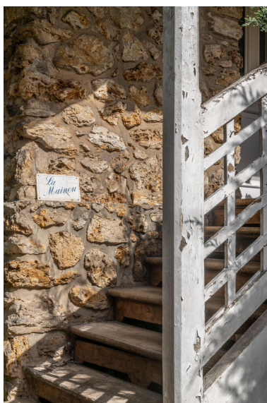
Détail de l'escalier du perron. Phot. Kruszyk Laurent IVR11_20247800276NUC4A
