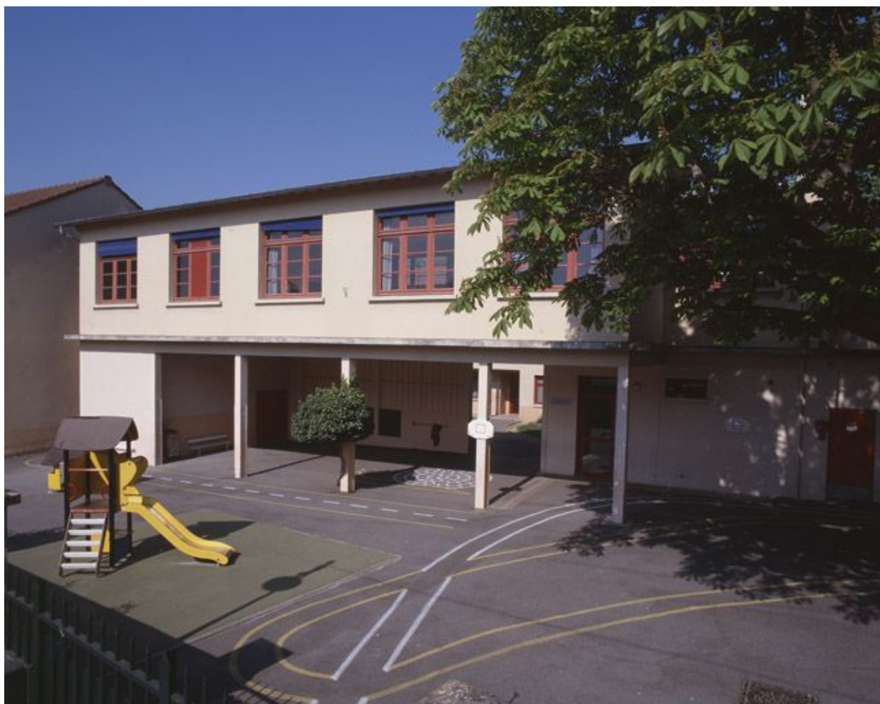
Vue de la cour de récréation et du bâtiment des classes dont le rez-de-chaussée forme préau.
