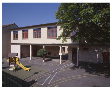
Vue de la cour de récréation et du bâtiment des classes dont le rez-de-chaussée forme préau.
