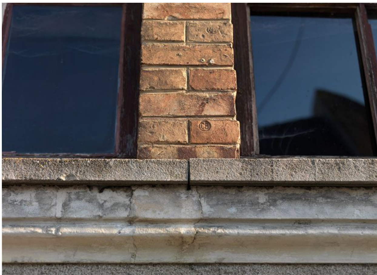
Vue de détail des encadrements de fenetre de l'atelier de transformation dont les briques portent l'estampille ""CB"".
