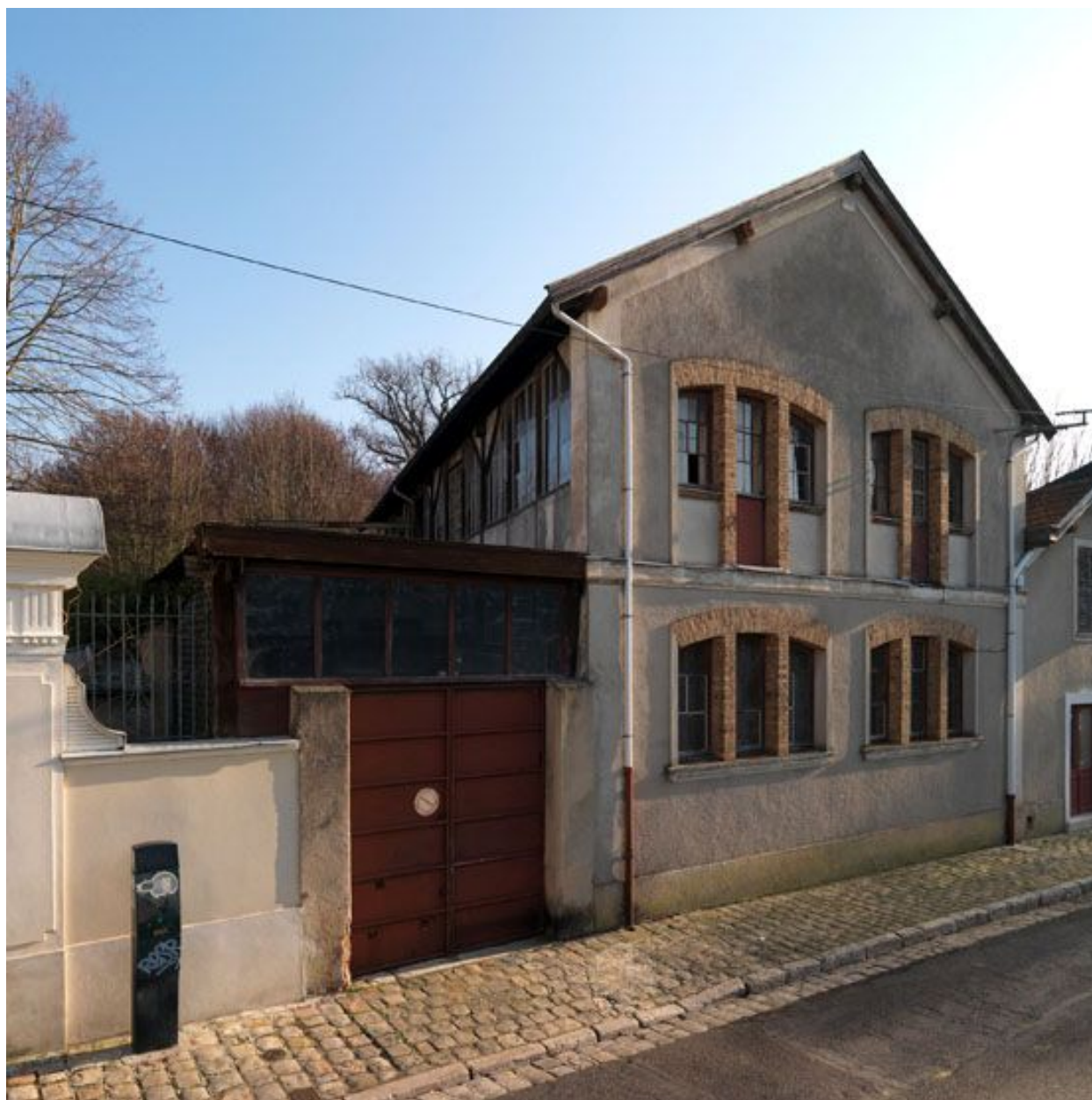
Garage et atelier de transformation de l'usine de menuiserie Parchowski et Chemin.
