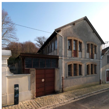
Garage et atelier de transformation de l'usine de menuiserie
