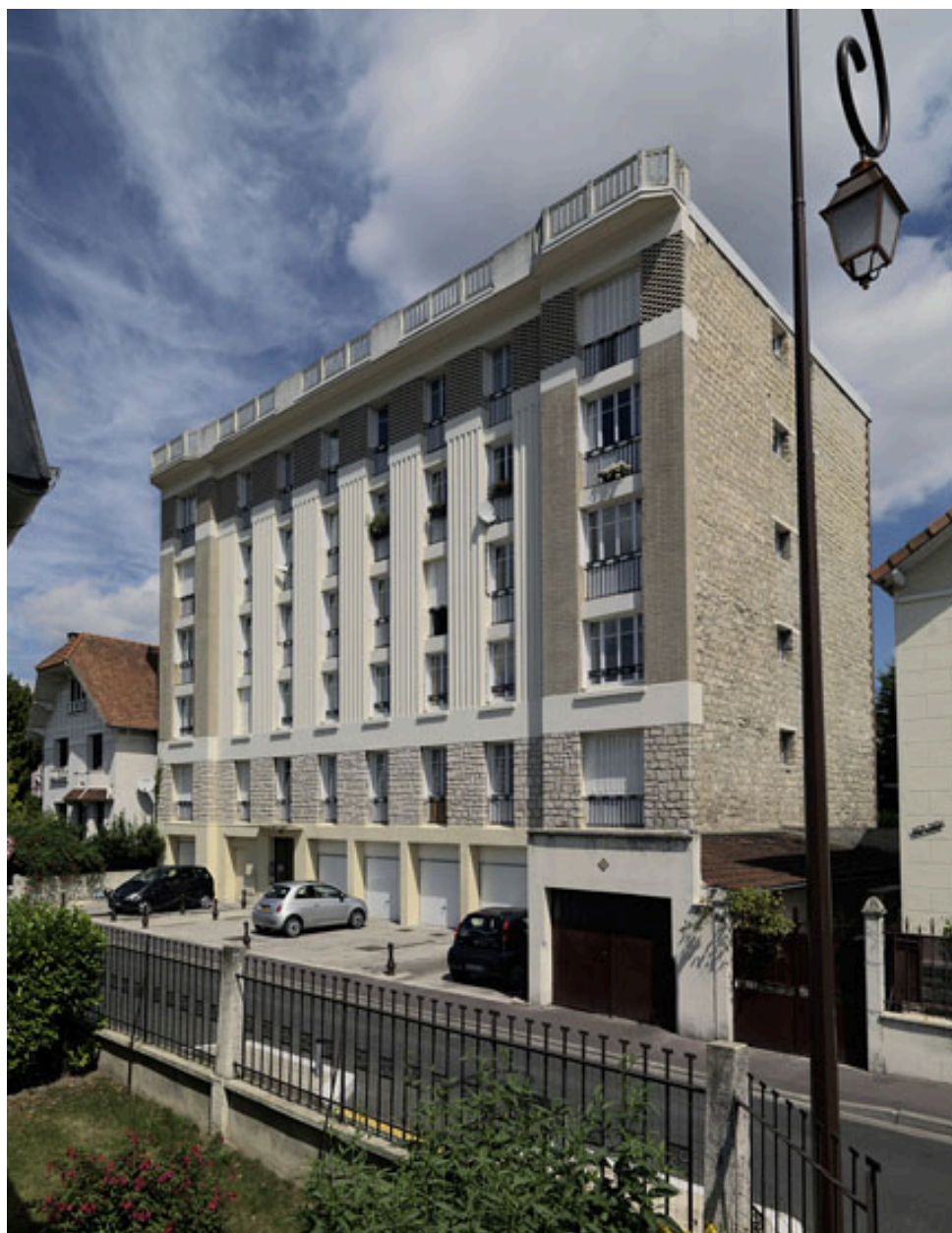
Vue d'ensemble de l'immeuble. Sur la porte, figure le monogramme G. B.
