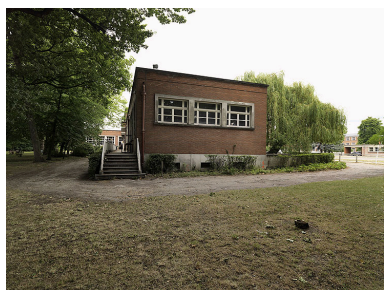
Façade du réfectoire donnant sur le parc. Phot. Jean-Bernard Vialles IVR11_20089500329NUC4A
