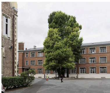
Vue du bâtiment du lycée donnant sur l'avenue de Ceinture, prise côté cour. Phot. Jean-Bernard Vialles IVR11_20089500332NUC4A
