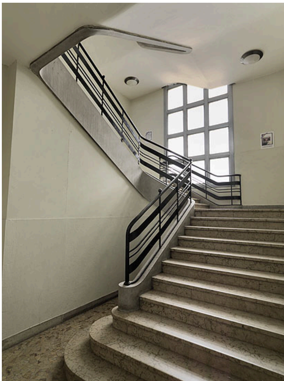
Vue de l'un des escaliers, situé dans le bâtiment donnant sur l'avenue de Ceinture (le premier à main droite en entrant).
