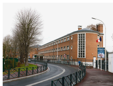
Vue d'ensemble du bâtiment donnant sur l'avenue de Ceinture. Phot. Jean-Bernard Vialles IVR11_20089500605NUC4A
