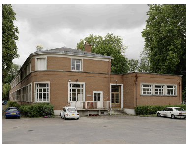
Vue du bâtiment du réfectoire : façade antérieure. Phot. Jean-Bernard Vialles IVR11_20089500327NUC4A
