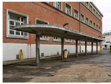
Vue des parcs à vélo formés d'une série de colonnes en béton supportant un auvent arrondi du même matériau. Ils ont été récemment supprimés, à l'occasion de la réfection de la clôture de l'ensemble de l'établissement. Phot. Jean-Bernard Vialles IVR11_20089500056NUC4A
