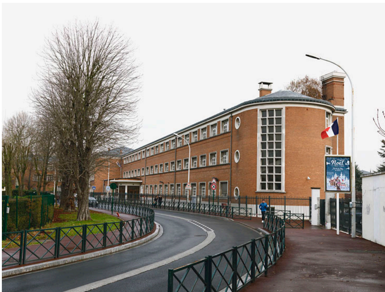
Vue d'ensemble du bâtiment donnant sur l'avenue de Ceinture.
