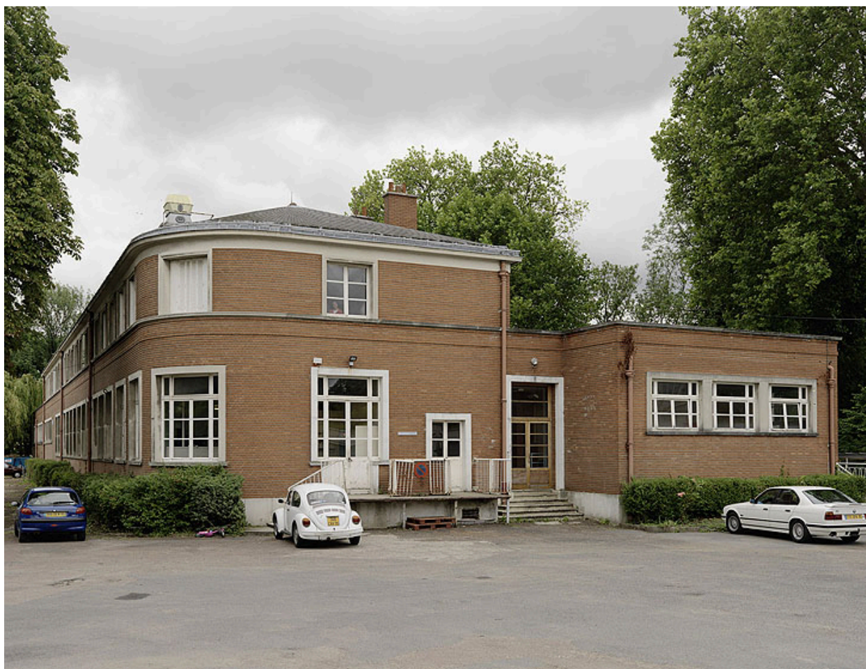
Vue du bâtiment du réfectoire : façade antérieure.
