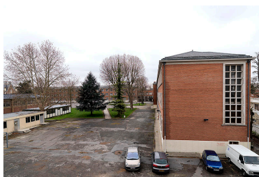
Vue d'ensemble des bâtiments sur cour depuis le premier étage du château Léon. Au premier plan le mur pignon de l'édifice perpendiculaire à la rue du Château Léon. Phot. Jean-Bernard Vialles IVR11_20089500049NUC4A
