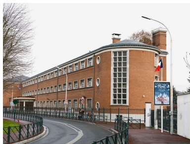
Détail du bâtiment donnant sur l'avenue de Ceinture : l'angle traité en arrondi, la grande baie verticale et les ouvertures hublot reprennent le vocabulaire de l'architecture d'avant guerre. Phot. Jean-Bernard Vialles IVR11_20089500606NUC4A
