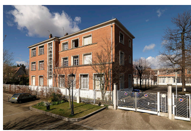
Vue de l'un des bâtiments du lycée professionnel. Phot. Jean-Bernard Vialles IVR11_20089500072NUC4A
