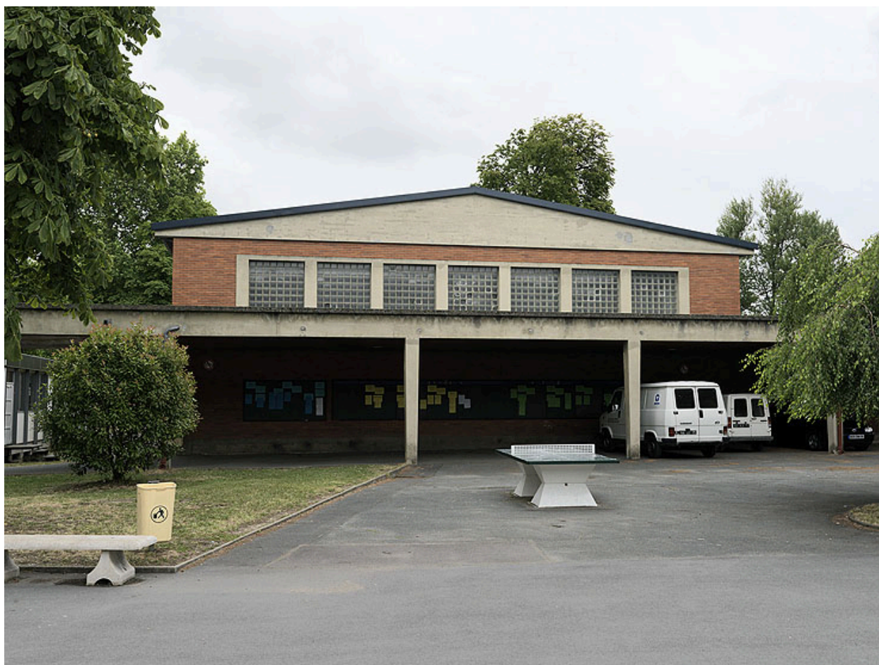
Façade d'entrée du gymnase.
