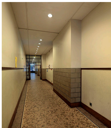
Vue de l'un des couloirs de dégagement dans le bâtiment principal sur rue. Les murs sont en partie revêtus de grès cérame. Phot. Jean-Bernard Vialles IVR11_20089500057NUC4A
