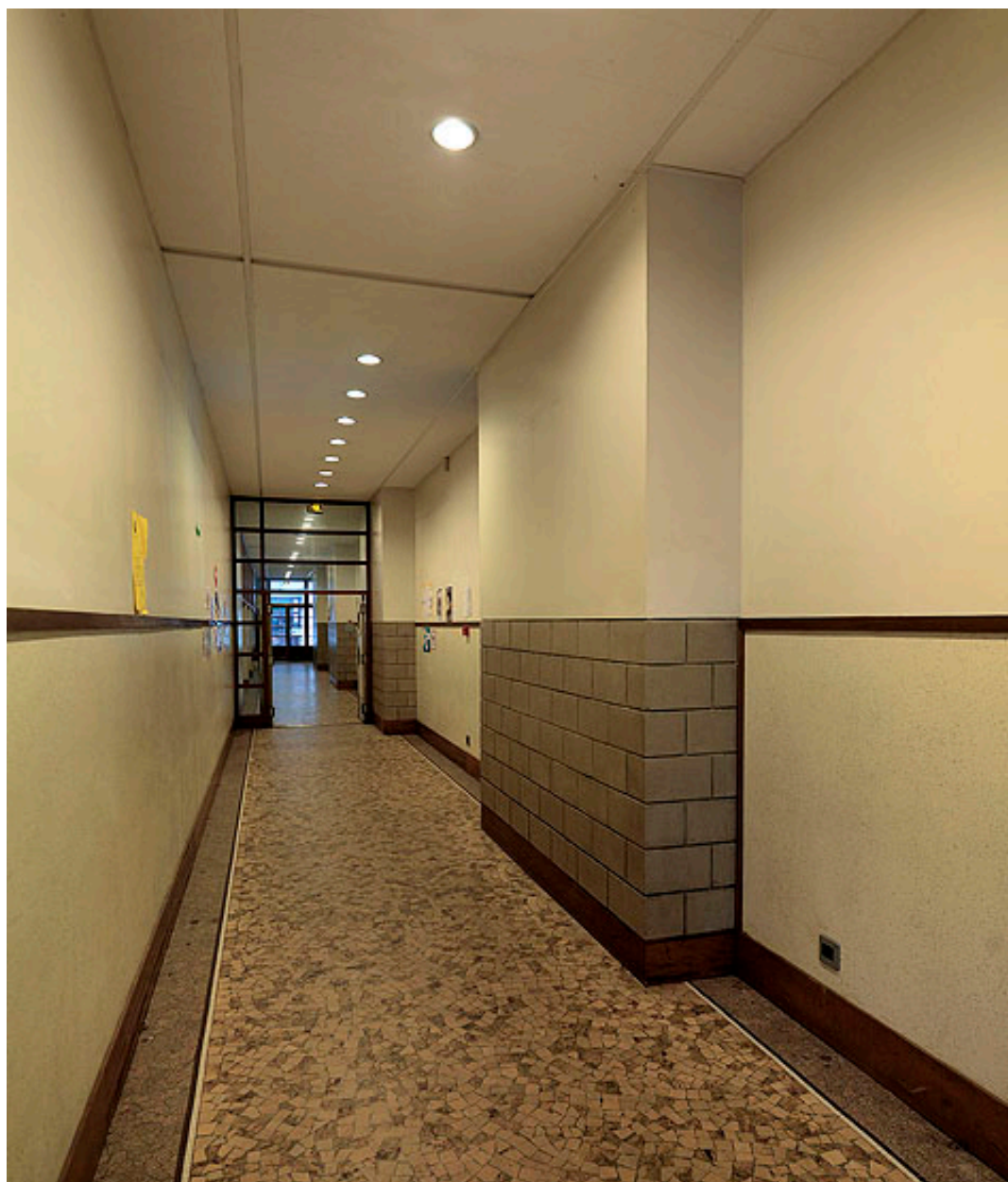
Vue de l'un des couloirs de dégagement dans le bâtiment principal sur rue. Les murs sont en partie revêtus de grès cérame.
