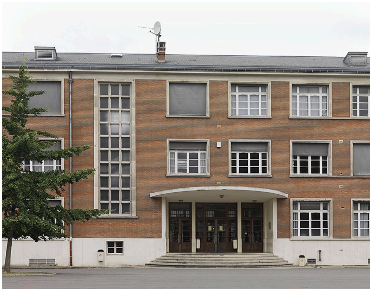
Détail de l'une des entrées du lycée donnant sur la cour.
