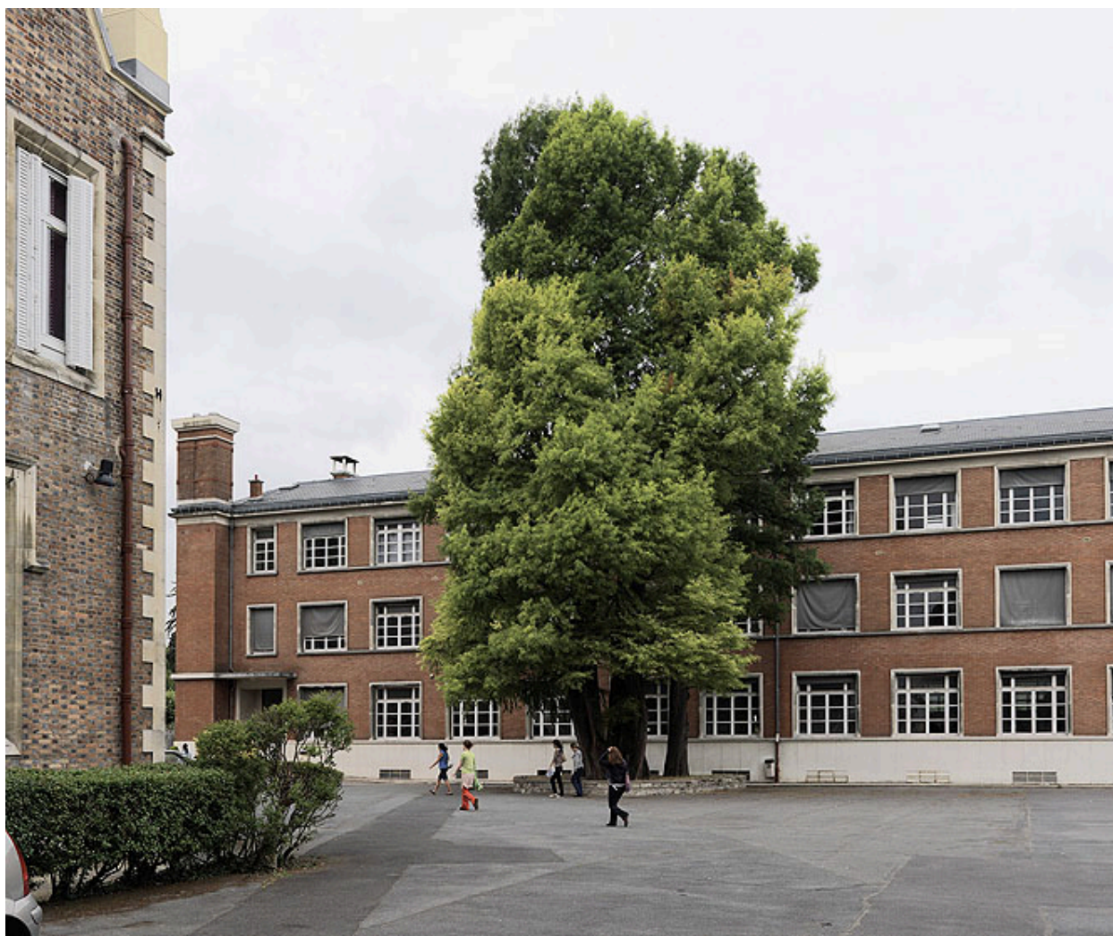
Vue du bâtiment du lycée donnant sur l'avenue de Ceinture, prise côté cour.
