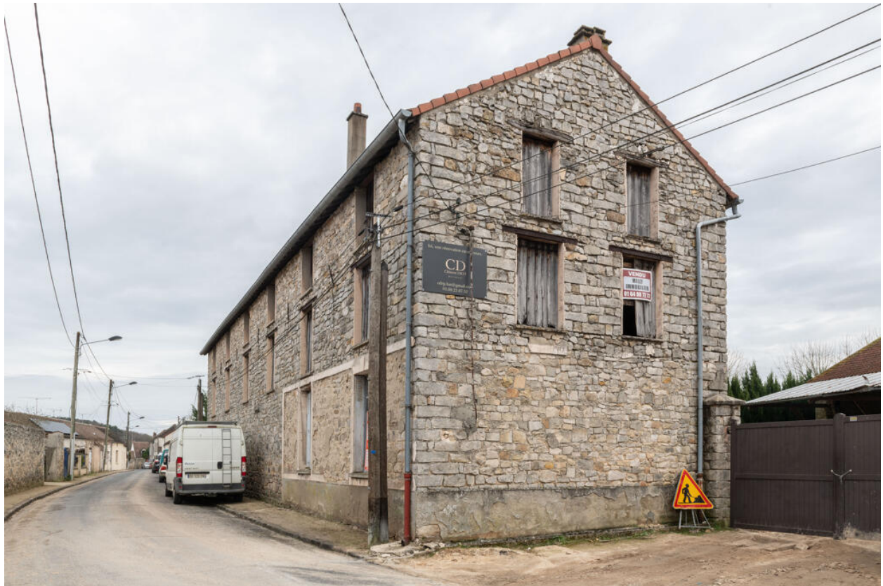
Vue générale de l'ancien séchoir à plantes, depuis le nord-ouest.
