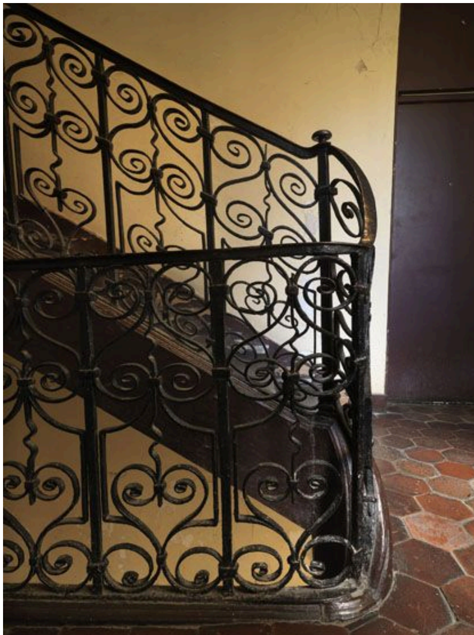
Balustres droits et balustres rampants.
