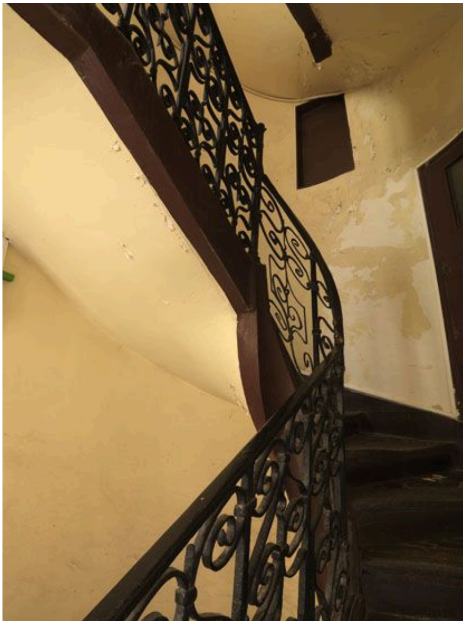
Partie tournante de l'escalier.
