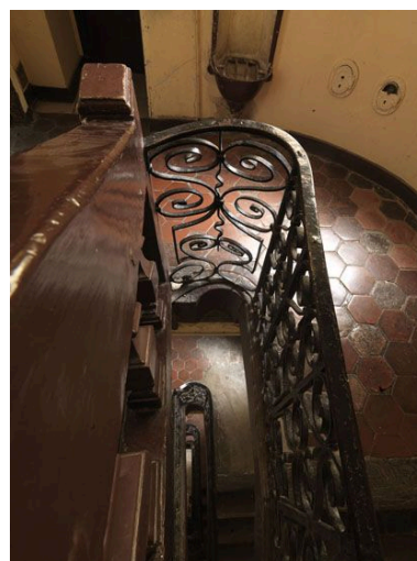
Vue plongeante sur le vide central. Phot. Laurent Kruszyk IVR11_20097501411NUC4A
