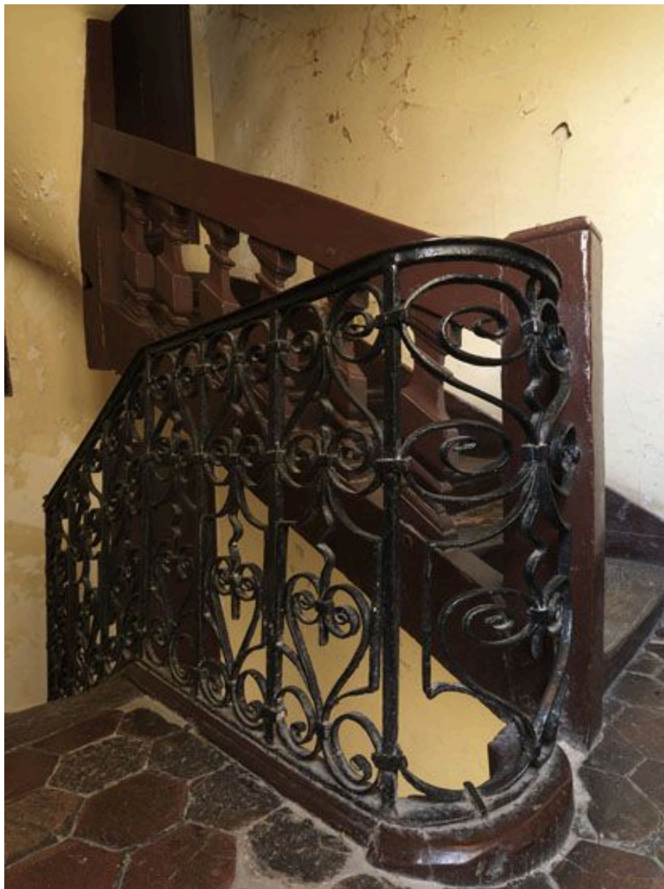
La jonction entre balustres en ferronnerie et balustres en bois.
