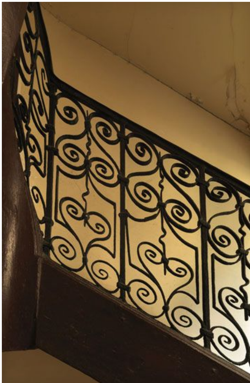
Détail des balustres ; on aperçoit les anciennes chevilles en bois.
