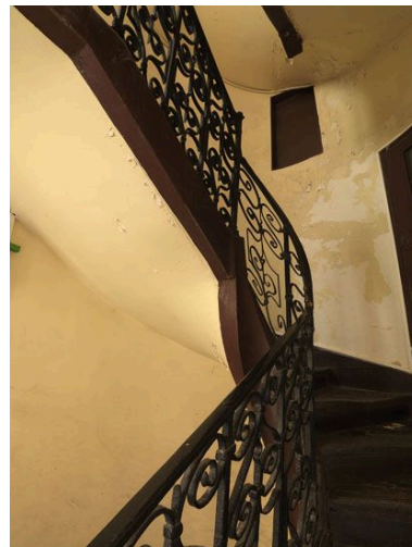
Partie tournante de l'escalier. Phot. Laurent Kruszyk IVR11_20097501408NUC4A
