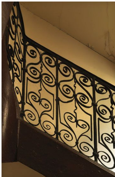
Détail des balustres ; on aperçoit les anciennes chevilles en bois. Phot. Laurent Kruszyk IVR11_20097501407NUC4A
