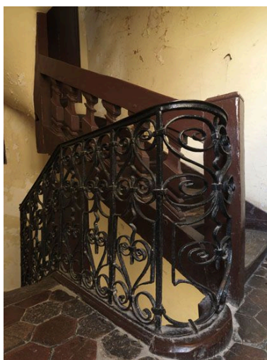
La jonction entre balustres en feronnerie et balustres en bois. Phot. Laurent Kruszyk IVR11_20097501410NUC4A
