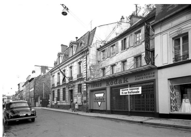
Vue de l'entrée du square avant la destruction des maisons que l'on voit, avenue de la République (Fonds Bertin). Phot. Bertin IVR11_20177800667NUC2B
