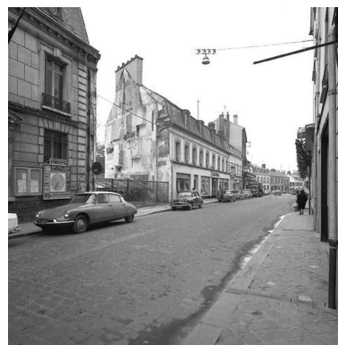
Maisons de l'avenue de la République détruites pour agrandir l'hôtel-de-ville. (Fonds Bertin) Phot. Bertin IVR11_20177800603NUC2B
