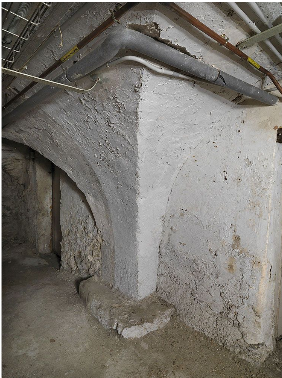
La cave sous l'aile sud.
