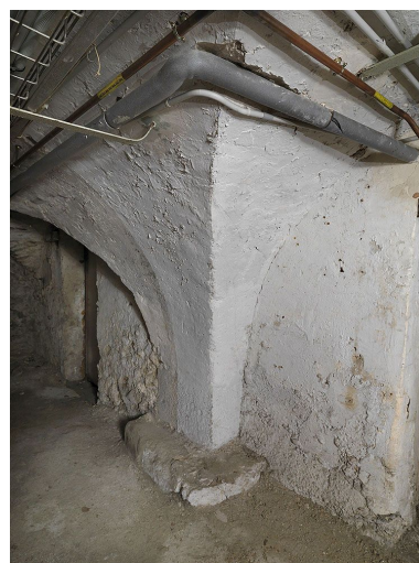
La cave sous l'aile sud. Phot. Jean-Bernard Vialles IVR11_20137700114NUC4A
