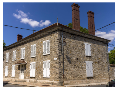
Vue générale du 71 rue Langlois (ou 1 rue Charles Cochin) depuis le sud-ouest. Phot. Asseline Stéphane
