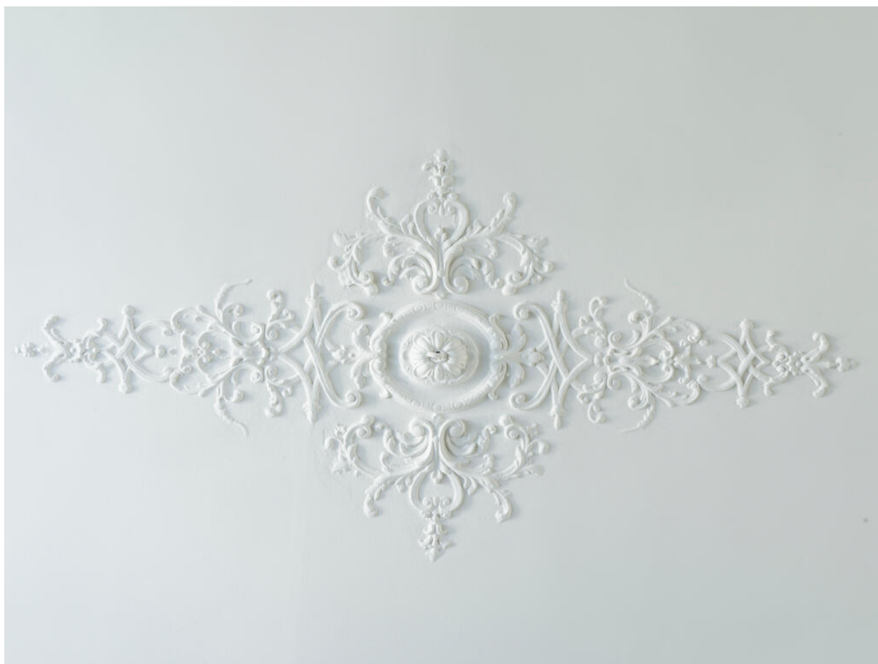
Moulure centrale du plafond du grand couloir du rez-de-chaussée desservant l'escalier.
