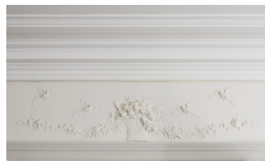
Moulure ornant un mur de la pièce nord-ouest du rez-de-chaussée. Phot. Asseline Stéphane IVR11_20259101103NUC4A
