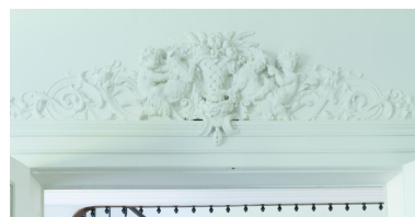
Moulure surmontant une porte intérieure de la pièce sud- ouest du rez-de-chaussée. Phot. Asseline Stéphane IVR11_20259101106NUC4A
