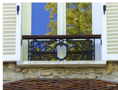
Détail d'un garde-corps d'une fenêtre de l'étage de la façade sur cour. Phot. Asseline Stéphane IVR11_20259101089NUC4A
