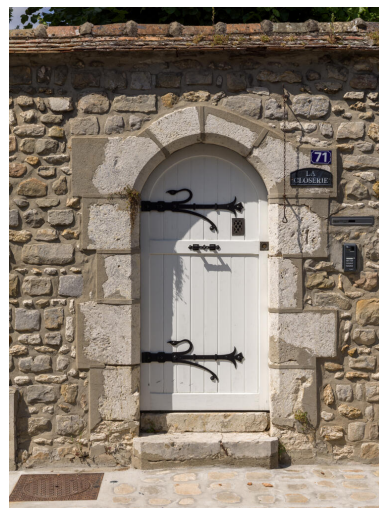
Porte piétonne aménagée dans le mur de clôture donnant sur la rue Langlois, vue depuis le sud.
