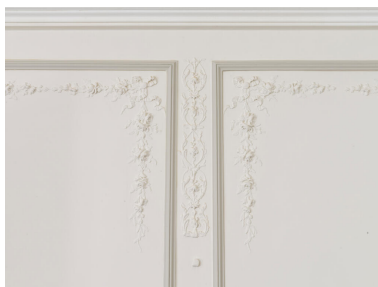
Détail du décor mouluré qui orne les murs de la pièce nord- ouest du rez-de-chaussée. Phot. Asseline Stéphane IVR11_20259101104NUC4A
