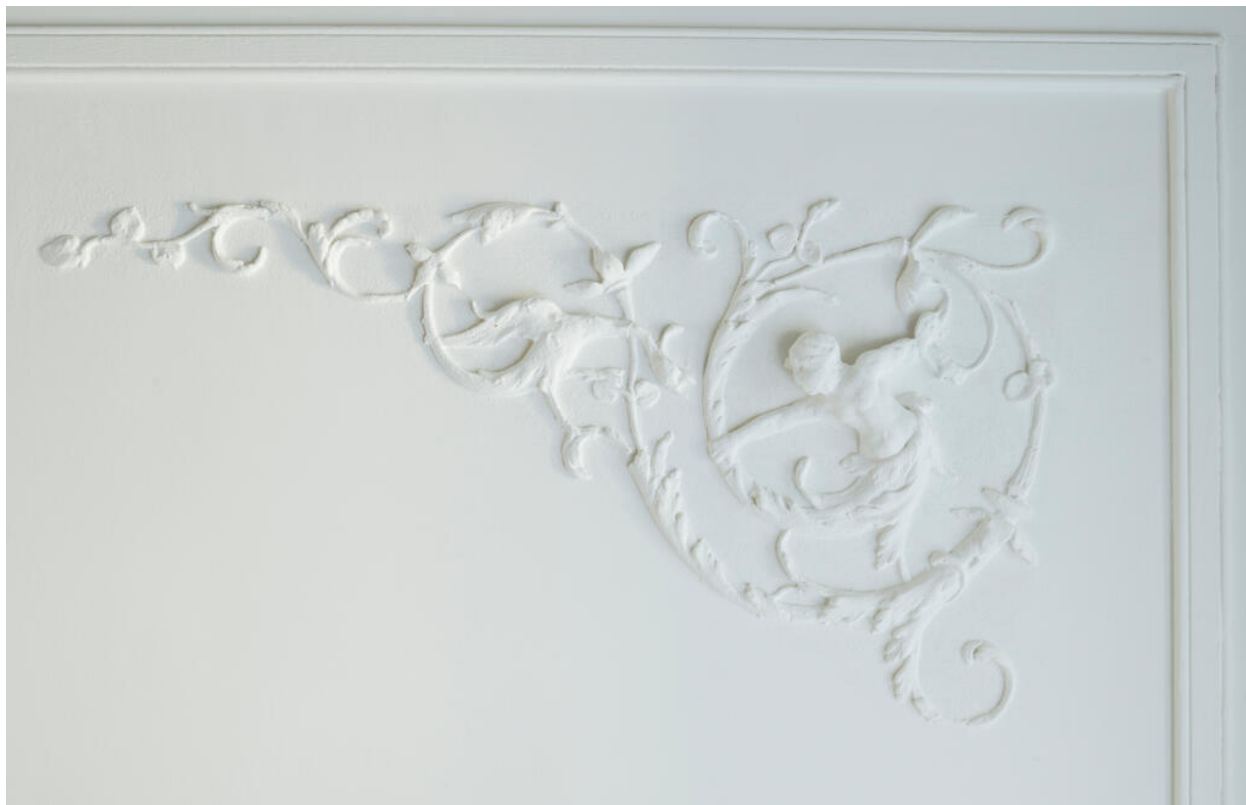
Moulure d'angle du plafond du grand couloir du rez-de-chaussée desservant l'escalier.
