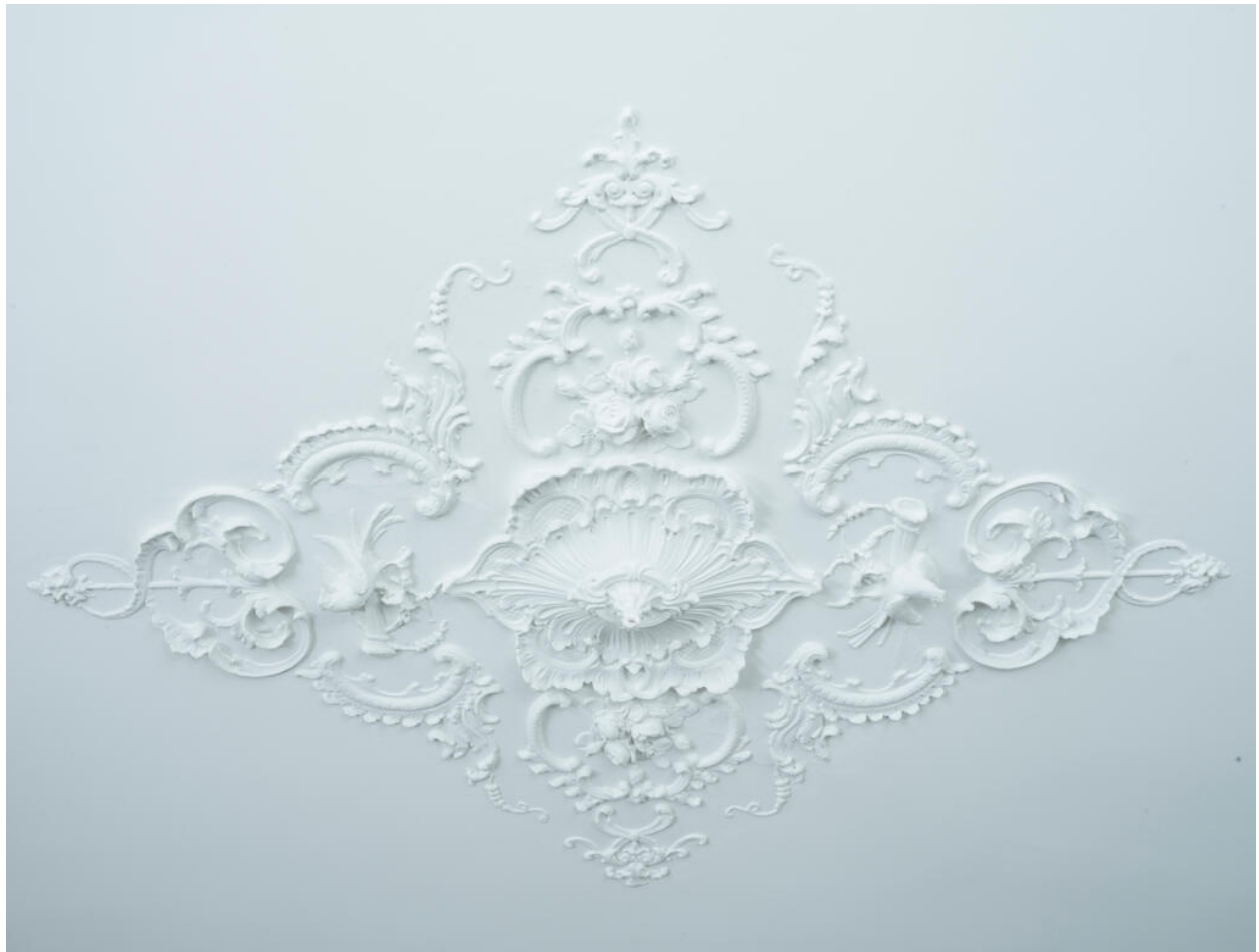
Moulure centrale du plafond de la pièce nord-ouest du rez-de-chaussée.
