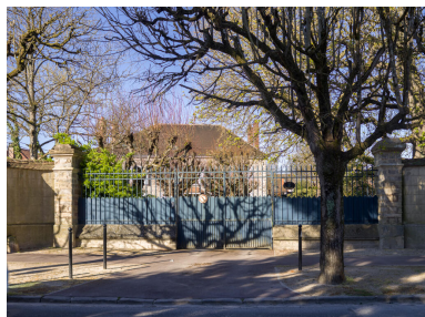
Entrée principale de la propriété sur le boulevard du Maréchal Foch, vue depuis l'est. Phot. Asseline Stéphane IVR11_20269100079NUC4A
