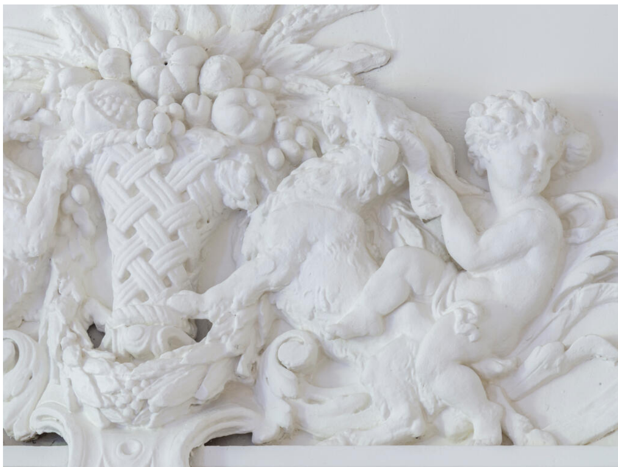
Détail de la moulure (pièce sud-ouest du rez-de-chaussée).
