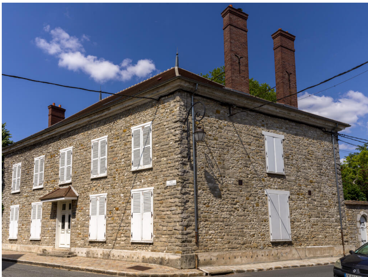
Vue générale du 71 rue Langlois (ou 1 rue Charles Cochin) depuis le sud-ouest.
