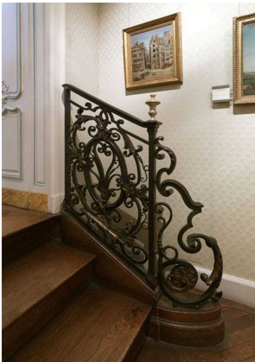
Fragment de la rampe d'appui et de la console de départ remonté au musée Carnavalet, (entrée de la salle 28).
