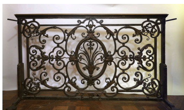
Vue d'un panneau droit remonté au musée Carnavalet, (salle 17 dite de Villacerf).
