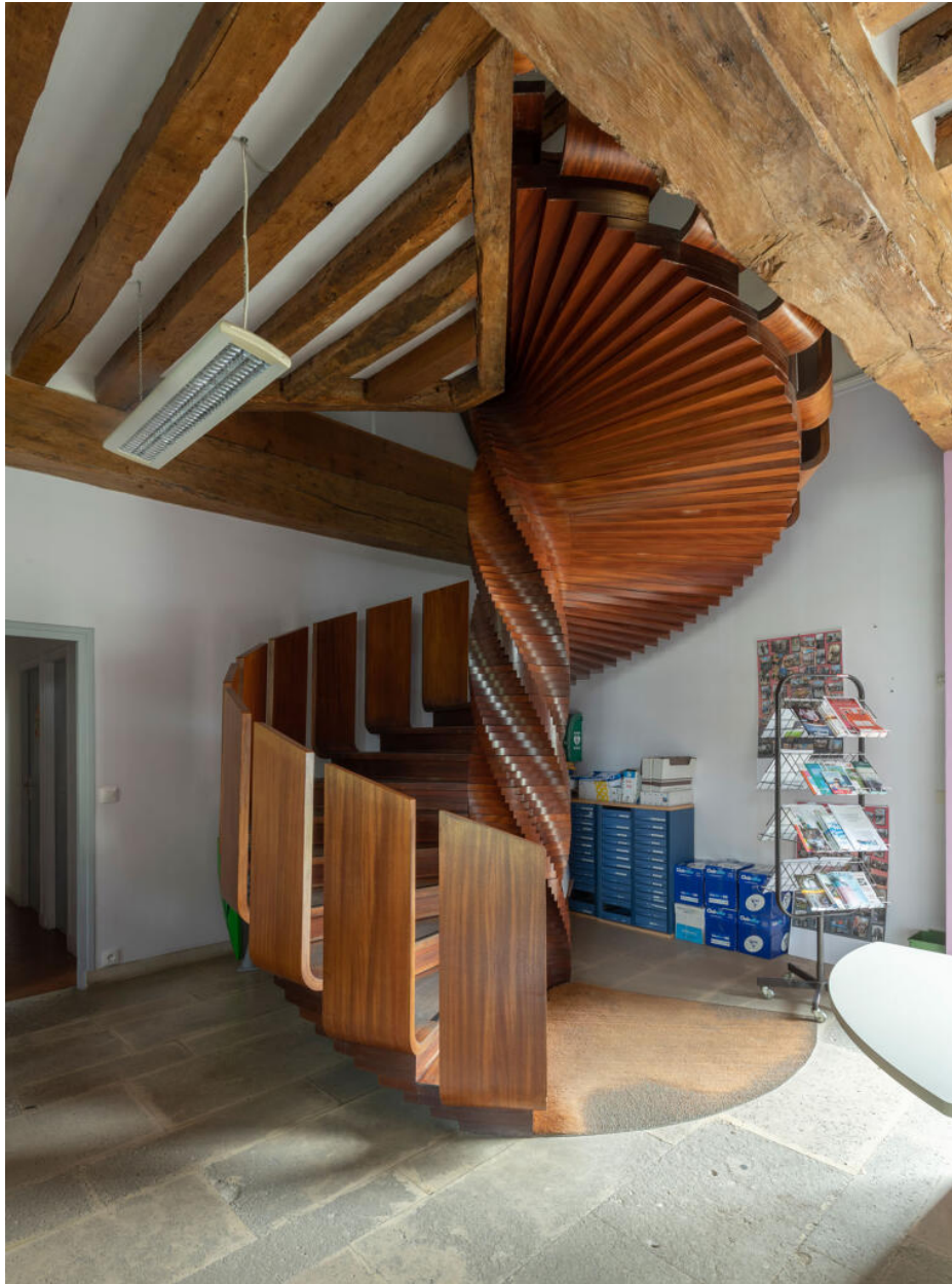
Dans la maison en fond de cour, le nouvel escalier de la mairie.
