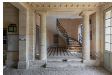
Sous le porche, départ de l'escalier d'honneur menant aux étages. IVR11_20239500220NUC4A
