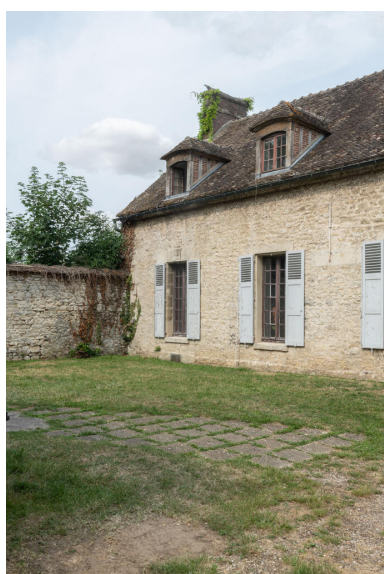
La façade sur la cour arrière n'a reçu aucun décor. Les lucarnes sont en brique pour les joues, et bois pour le chambranle. Les moellons sont laissés apparents, témoignant de l'usage du bâtiment, utilitaire et rustique. IVR11_20239500217NUC4A
