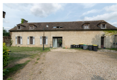
Façade sur la cour arrière du bâtiment agricole. Au centre, le grand passage, bien maçonné, qui traverse l'édifice de part en part. IVR11_20239500216NUC4A
