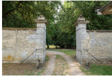
Le portail menant de la cour au vaste parc. IVR11_20239500215NUC4A
