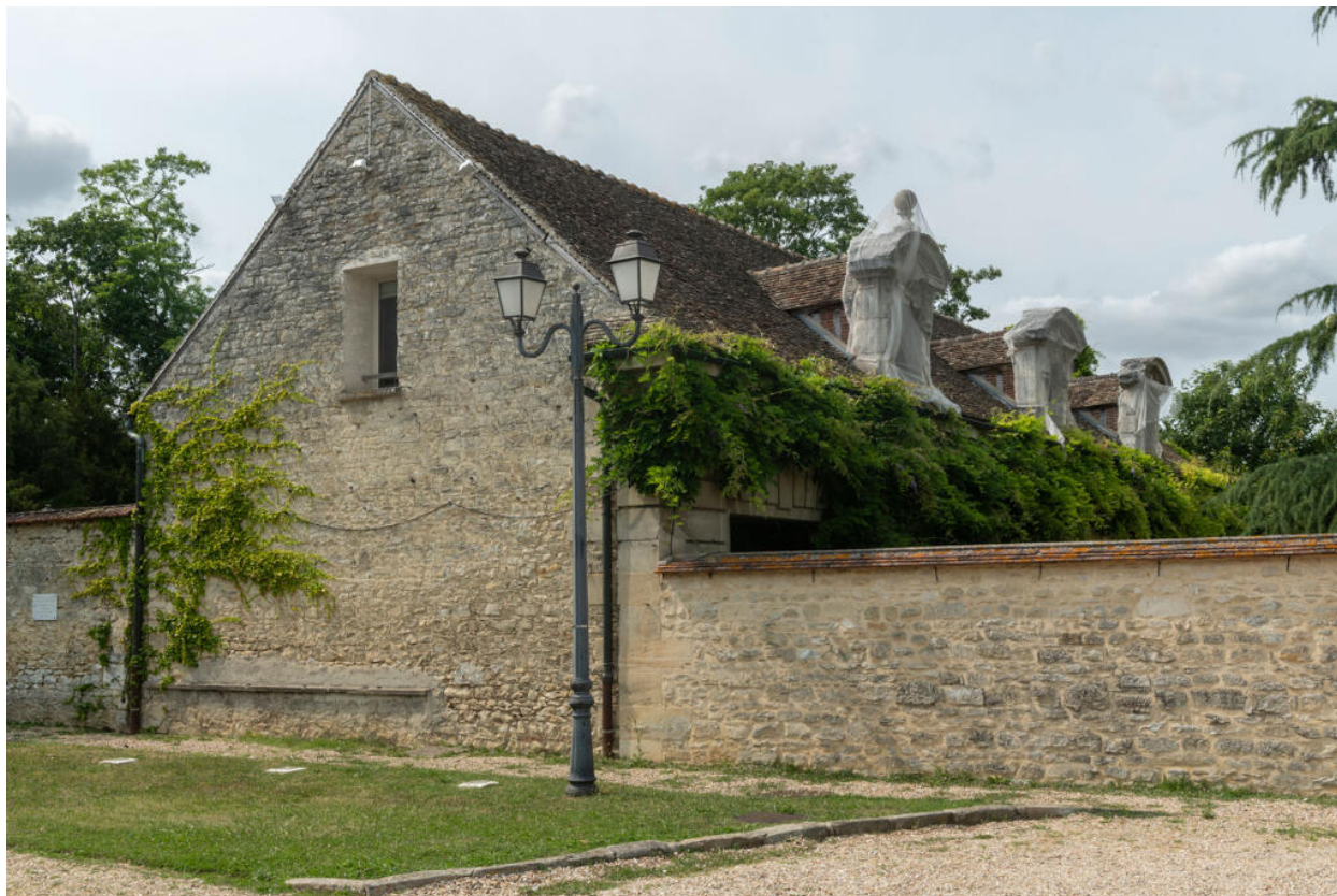
Façade latérale sud du bâtiment agricole.
