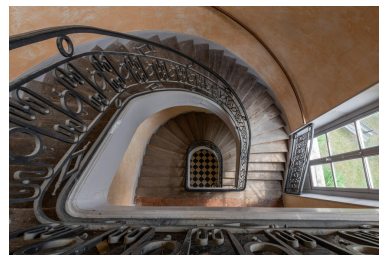
Vue plongeante de l'escalier. IVR11_20239500223NUC4A
