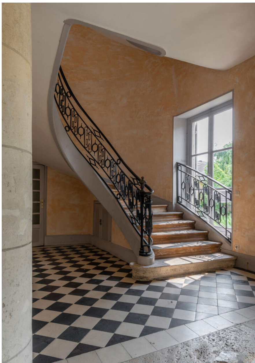
Départ de l'escalier à motif continu en serrurerie.
