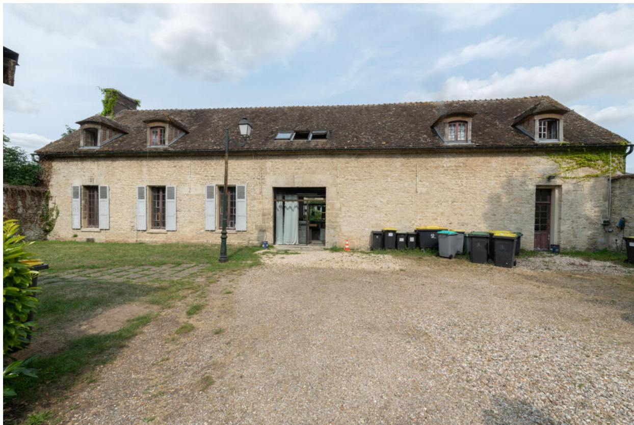
Façade sur la cour arrière du bâtiment agricole. Au centre, le grand passage, bien maçonné, qui traverse l'édifice de part en part.
