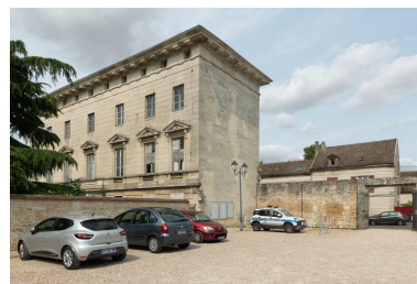
Façades postérieure et latérale sud. Le bâtiment se situe entre la rue et la cour fermée. La propriété s'étend alentour, au sud et à l'ouest.
