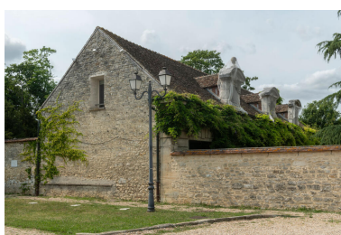
Façade latérale sud du bâtiment agricole. IVR11_20239500218NUC4A
