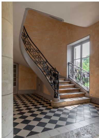
Départ de l'escalier à motif continu en serrurerie. IVR11_20239500221NUC4A
