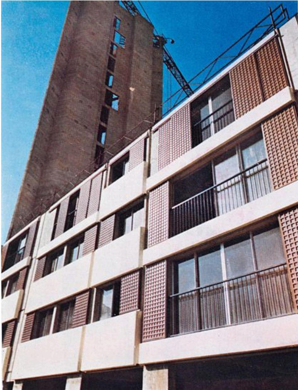
Mise en oeuvre des éléments de façades avec éléments coulissants et le détail via liaisons verticales Armatube d'une des tours de Beauval. Tiré de : "L'installateur", juin 1969, n° 312, p. 128, p.129 (Cité de l'architecture et du patrimoine. fonds Lods 323 AA69/4)
