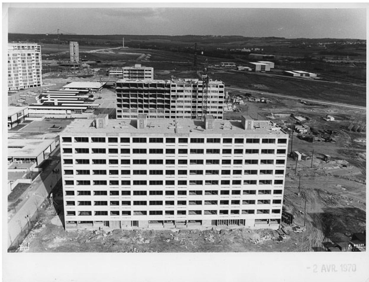
Chantier de la construction - Mise en place des grues sur rail et achèvement de l'élévation des barres de Beauval. Vue de l'école primaire et du collège Camus - 2 avril 1970. (OPAC Meaux)
