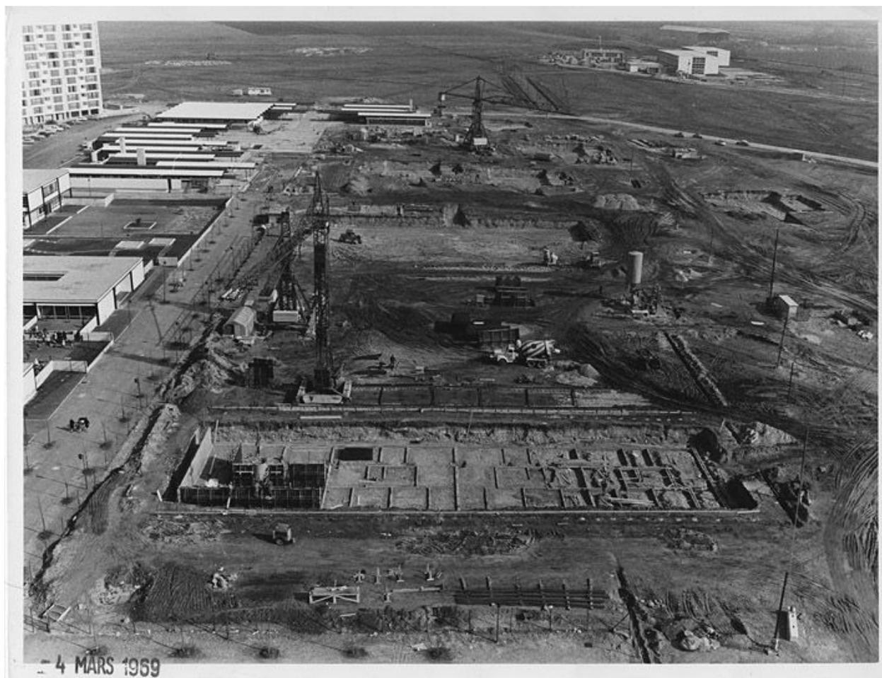
Chantier de la construction - Mise en place des grues et début de l'élévation d'une barre de Beauval. 4 mars 1969.
