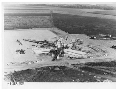
Début du chantier de construction d'une des tours de Meaux-Beauval. Montage de la grue dans le noyau. 3 septembre 1969. (OPAC Meaux) IVR11\_20097701140NUC4
