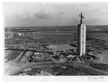
Chantier de construction d'une des tours de Meaux-Beauval. Vue du noyau avec la grue intérieure. 27 janvier 1970. (OPAC Meaux) IVR11\_20097701141NUC4
