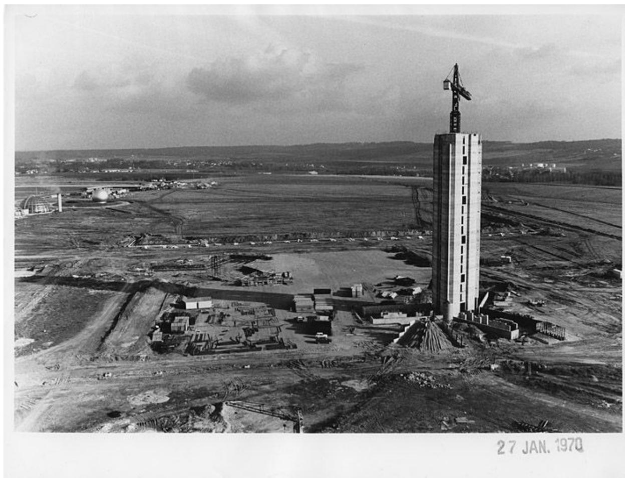
Chantier de construction d'une des tours de Meaux-Beauval. Vue du noyau avec la grue intérieure . 27 janvier 1970.
