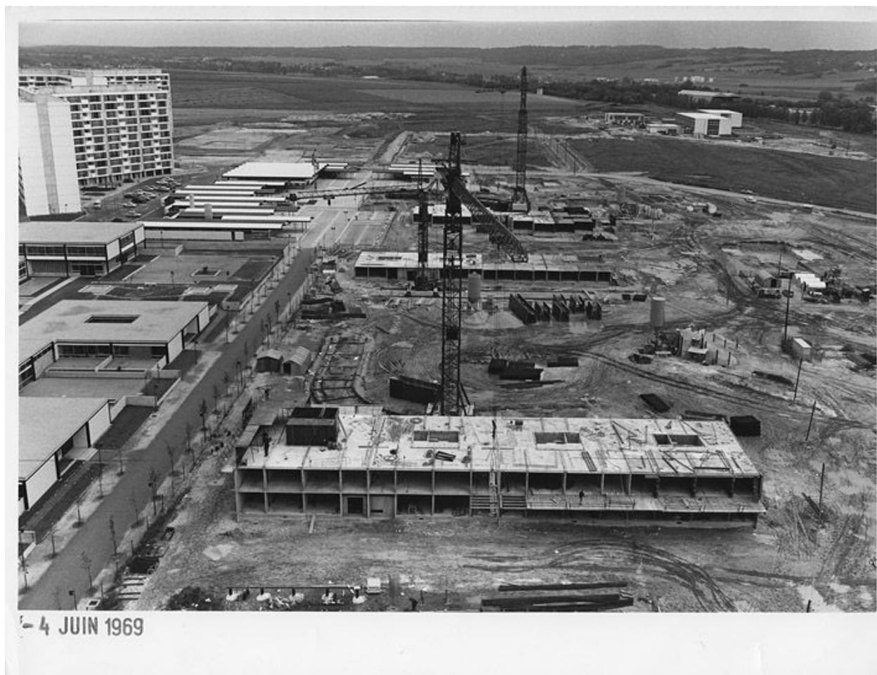
Chantier de la construction - Mise en place des grues sur rail et début de l'élévation de deux barres de Beauval. Vue de l'école primaire et du collège Camus- 4 juin 1969. (OPAC Meaux)
