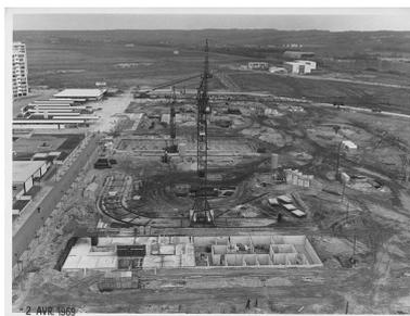
Chantier de la construction - Mise en place des grues et début de l'élévation de deux barres de Beauval. 2 avril 1969. (OPAC Meaux) IVR11\_20097701113NUC4
