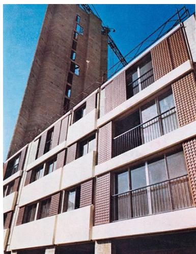
Mise en oeuvre des éléments de façades avec éléments coulissants et le détail via liaisons verticales Armatube d'une des tours de Beauval. Tiré de : "L'installateur", juin 1969, n° 312, p. 128, p.129 (Cité de l'architecture et du patrimoine. fonds Lods 323 AA69/4) IVR11\_20097700996NUC4A
