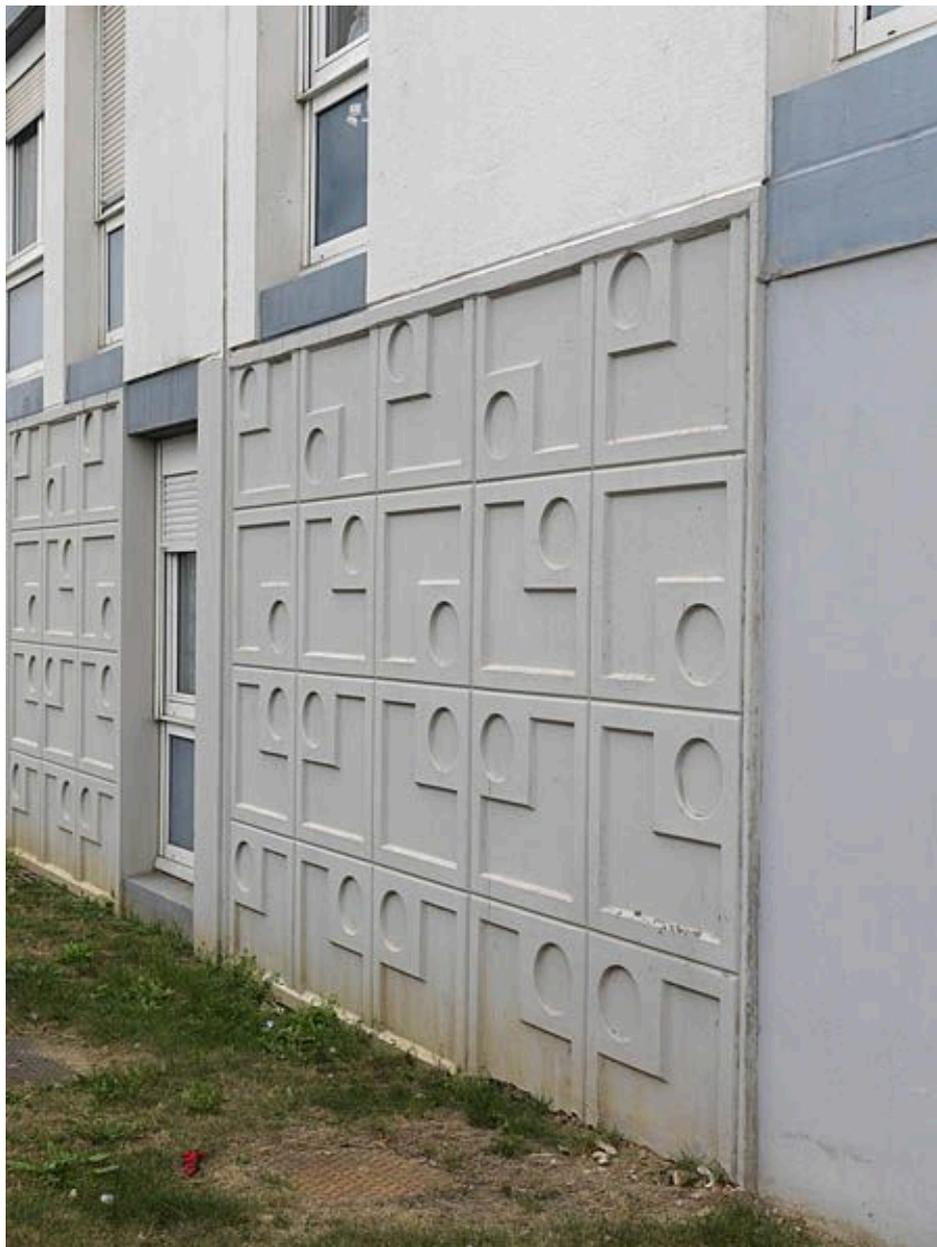
Immeuble "square" R+4 et R+8 de Beauval A avec allèges de fenêtres bleues. Mise en oeuvre des soubassements en béton décoré.
