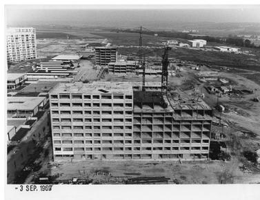
Chantier de la construction - Mise en place des grues sur rail et début de l'élévation de deux barres de Beauval. 2 mai 1969. (OPAC Meaux)
