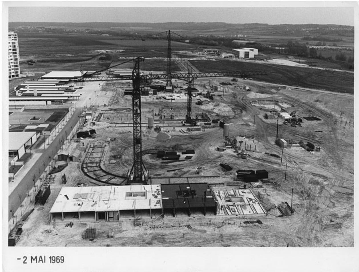
Chantier de la construction - Mise en place des grues sur rail et début de l'élévation de deux barres de Beauval. 2 mai 1969. (OPAC Meaux)
