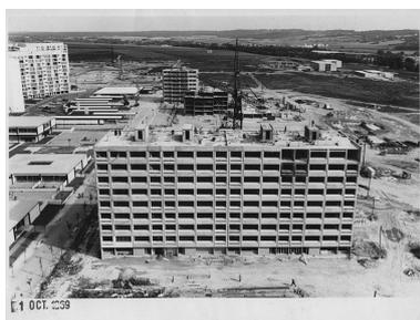
Chantier de la construction - Mise en place des grues sur rail et avancement de l'élévation des barres de Beauval. Vue de l'école primaire et du collège Camus- 4 juin 1969. (OPAC Meaux)
