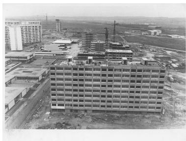
Chantier de la construction - Mise en place des grues sur rail et achèvement de l'élévation des barres de Beauval. Vue de l'école primaire et du collège Camus- après le 10 octobre 1969. (OPAC Meaux)
