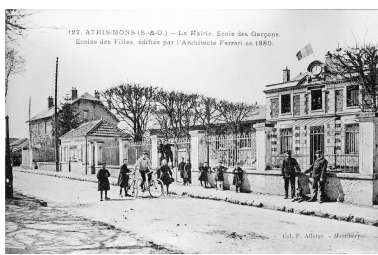
La mairie-école avec l'un de ses pavillons d'entrée. IVR11_20019100458XB
