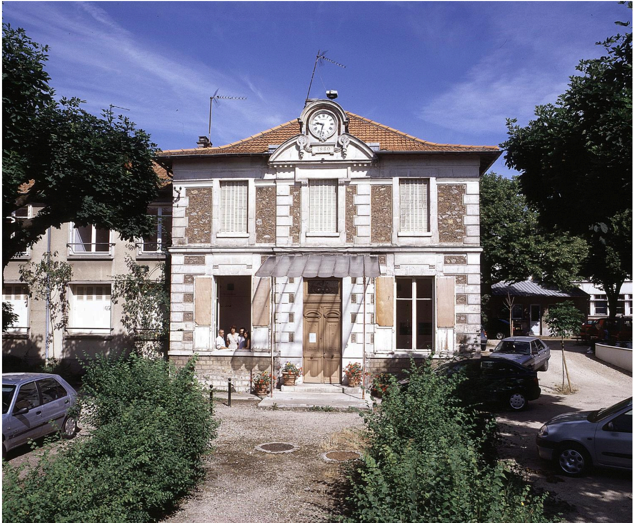
Vue d'ensemble du bâtiment, aujourd'hui siège de la Maison de Banlieue et de l'Architecture.
