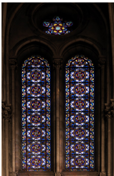
Verrière réalisée vers 1858 par Gsell-Laurent. Phot. Jean-Bernard Vialles IVR11_20097500027NUC4A
