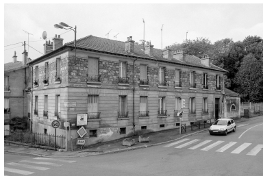
Vue d'ensemble. Phot. Christian Décamps IVR11_20007800727X
