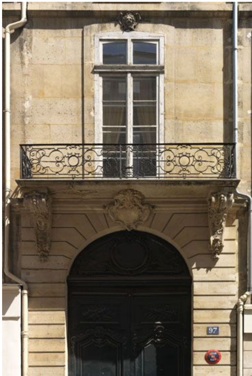
Vue de la porte cochère surmontée d'un balcon.
