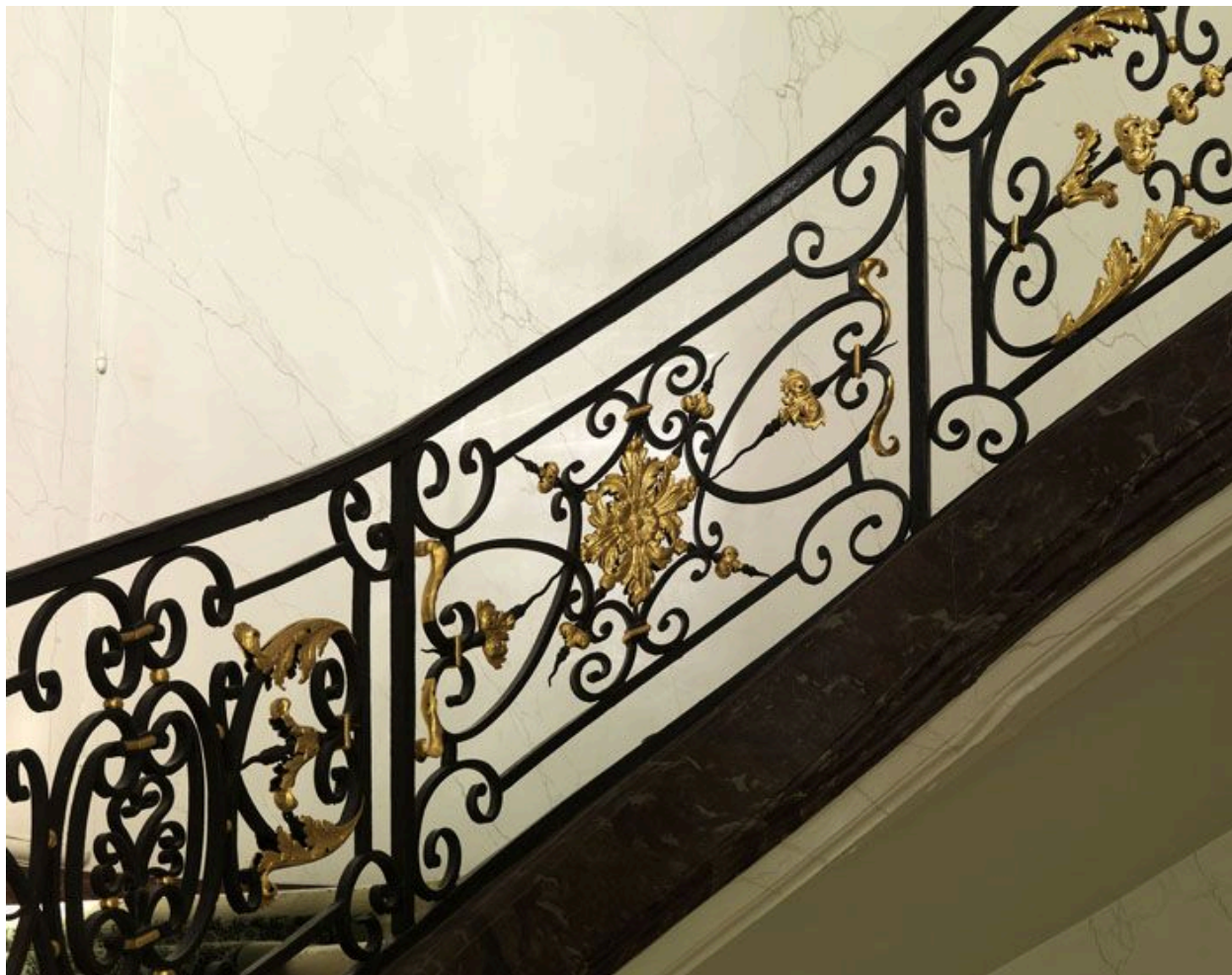
Un petit panneau rampant à rosette centrale en bronze.
