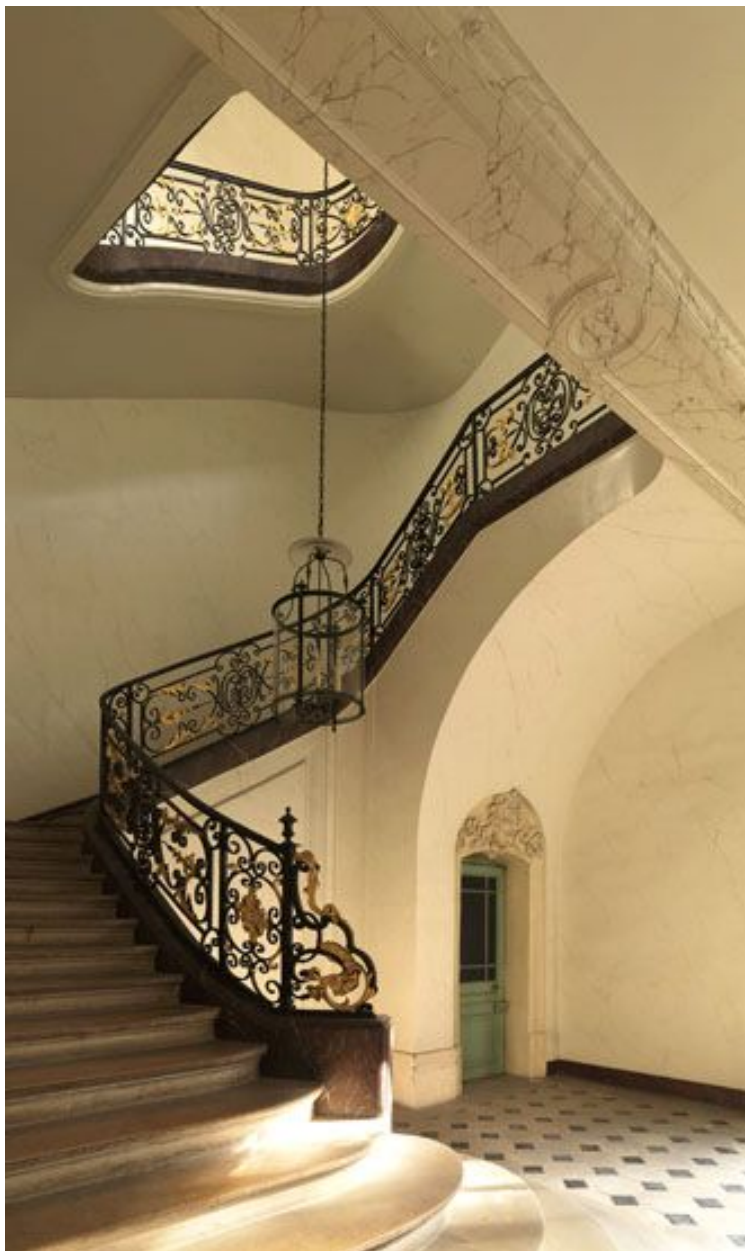
Vue d'ensemble de la première volée.
