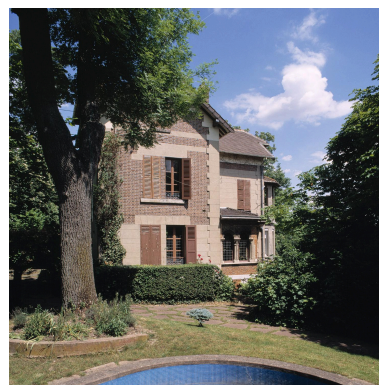
Vue de la façade latérale ouest. Phot. Philippe Ayrault IVR11_20029100772XA
